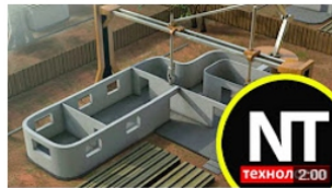
Китайская компания Winsun напечатала первую пятиэтажку на 3D принтере
