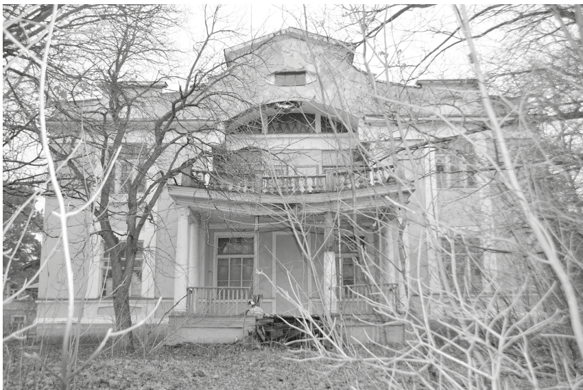
Рис. 11. Главный корпус «Тарховского военного санатория» МО РФ (бывшая дача П. А. Авенариуса — М. Ф. Святополк-Мирской). Западный фасад. Фото П. О. Яковлева. 2014
