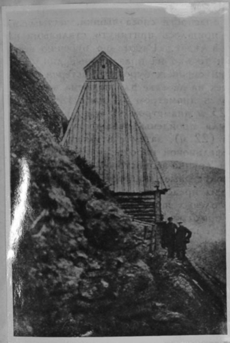
20 августа 1929 г. на Кукисвумчорре, на высоте с отметкой 560 метров, заложена первая буровая в Хибинской тундре.
