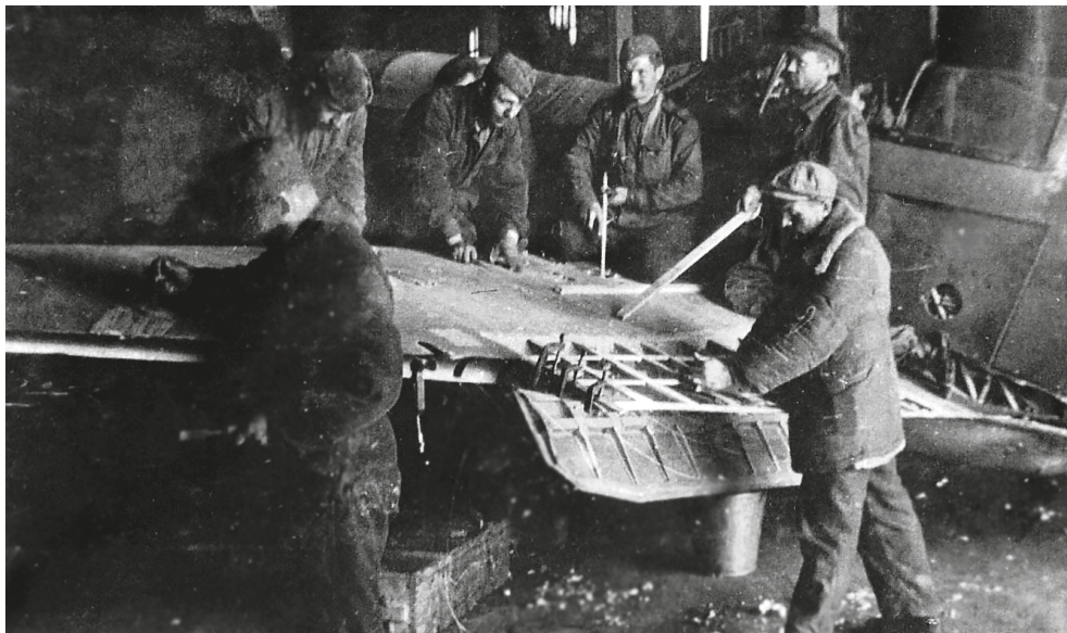
Ремонт крыла самолета-истребителя Як-1Б из состава 21-го истребительного авиаполка ВВС Краснознаменного Балтийского флота в авиамастерской завода № 37 (Яров С. В. Повседневная жизнь блокадного Ленинграда. СПб., 2013. С. 255)
