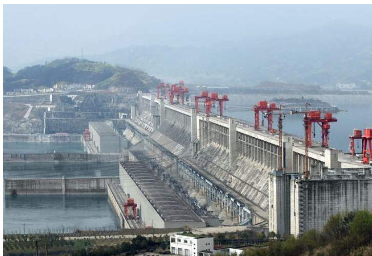
Рисунок 3.6 - ГЭС «Три ущелья» (Санься), Китай (Сила воды...).
