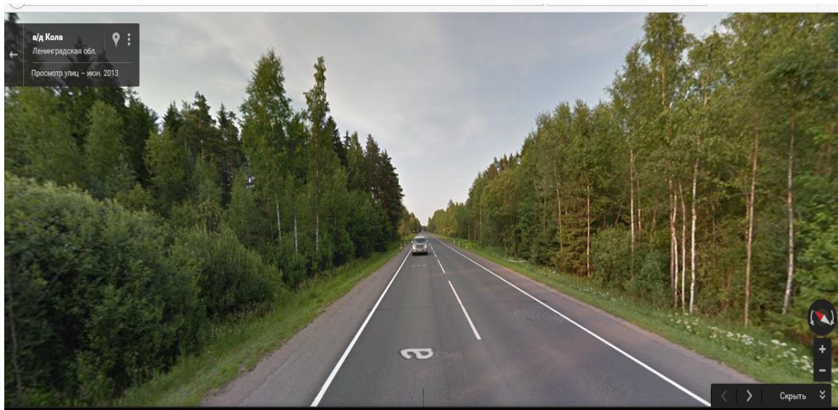
Рисунок 19 - Обочина дороги вдоль 180 км трассы Кола
