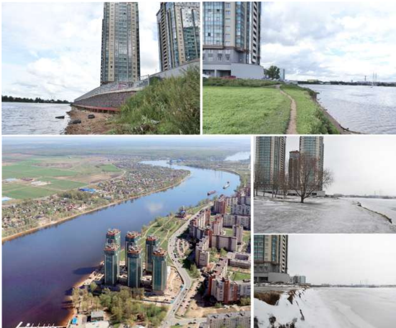
3.3.14. ЖК «Речной». Фотофиксация
