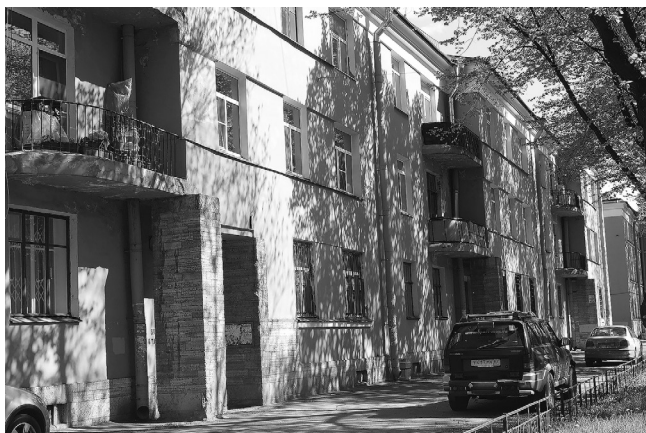
Рис. 1. Жилмассив на Тракторной улице. Пр. Стачек, д. 6а–12Б / Тракторная ул., д. 1–15 / ул. Метростроевцев, 2а (бывший «Крыловский участок»). 1924–1927 гг., арх. А.И. Герелло, А.С. Никольский, Г.А. Симонов. Фото С.В. Семенцова, 2012 г.
