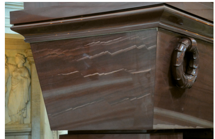
Рис. 5. Слоистость и система мелких дислокаций в кварците в стенке саркофага. Фото А. И. Брусницына
