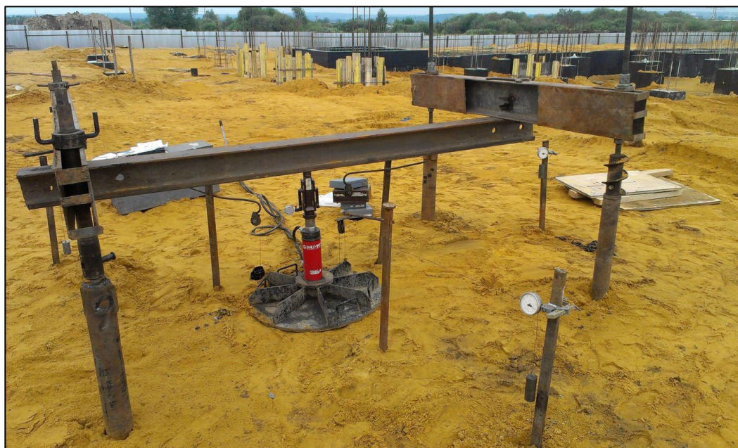
Рис. 6. Вид установки штампа для испытаний грунтов.
