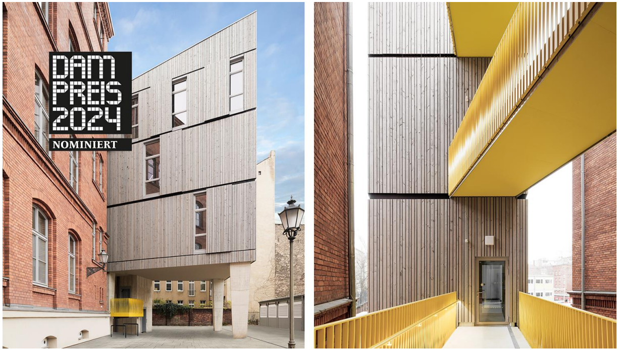
Рисунок № 7. Пристройка после реконструкции школы им. Роберта Коха
