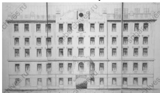
1.1.5. 1903 г. – осуществлена перестройка здания, надстроен пятый этаж
