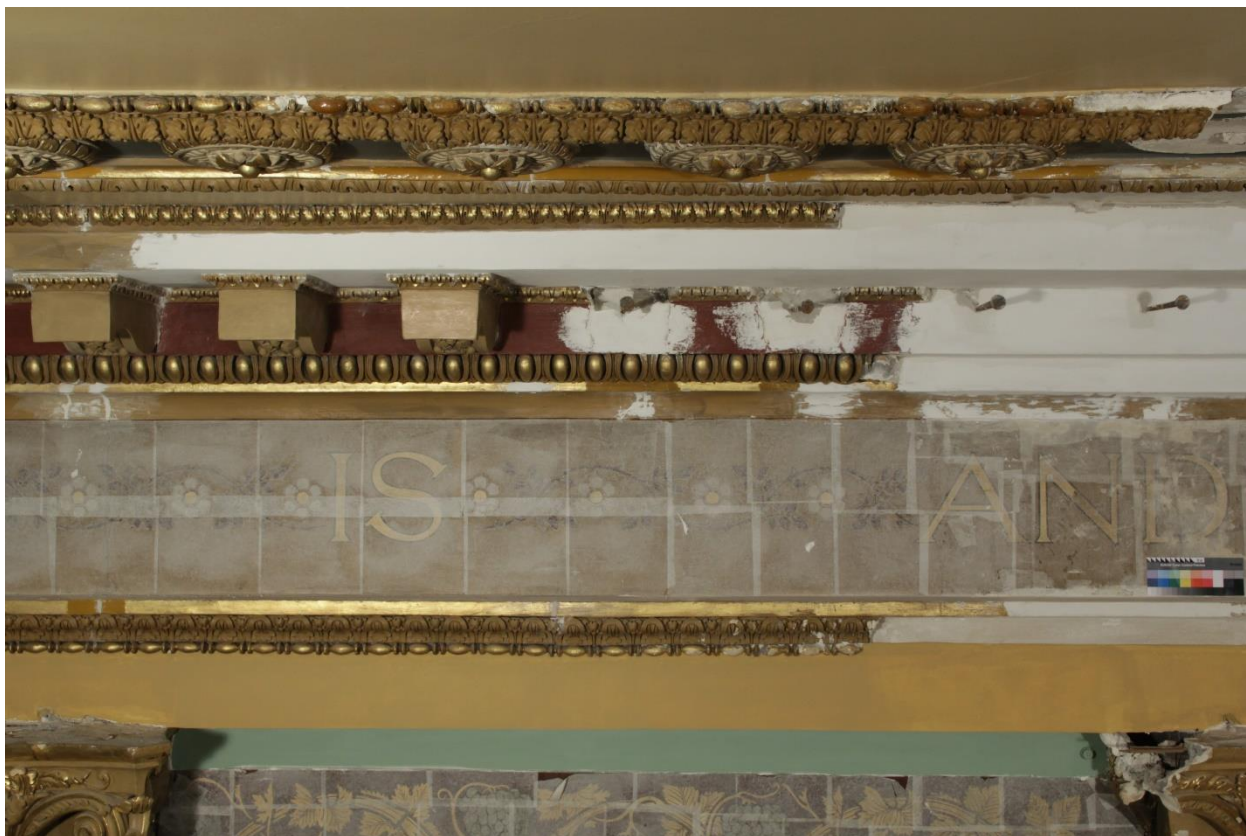
2.10 Фрагмент №1 до начала реставрации. Прямое освещение
