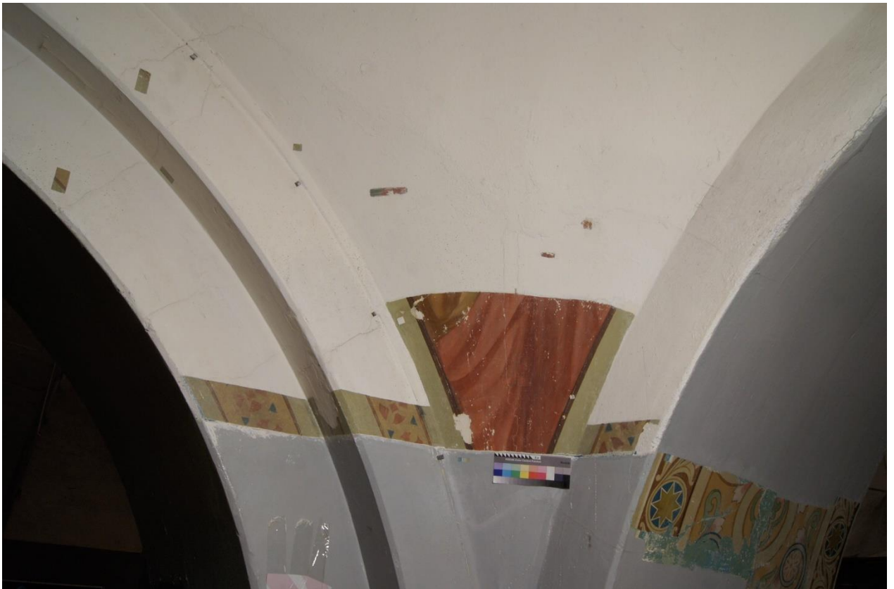
2.11 Фрагмент №1 в процессе реставрации. В процессе удаления малярной побелки с поверхности живописного слоя. Прямое освещение
