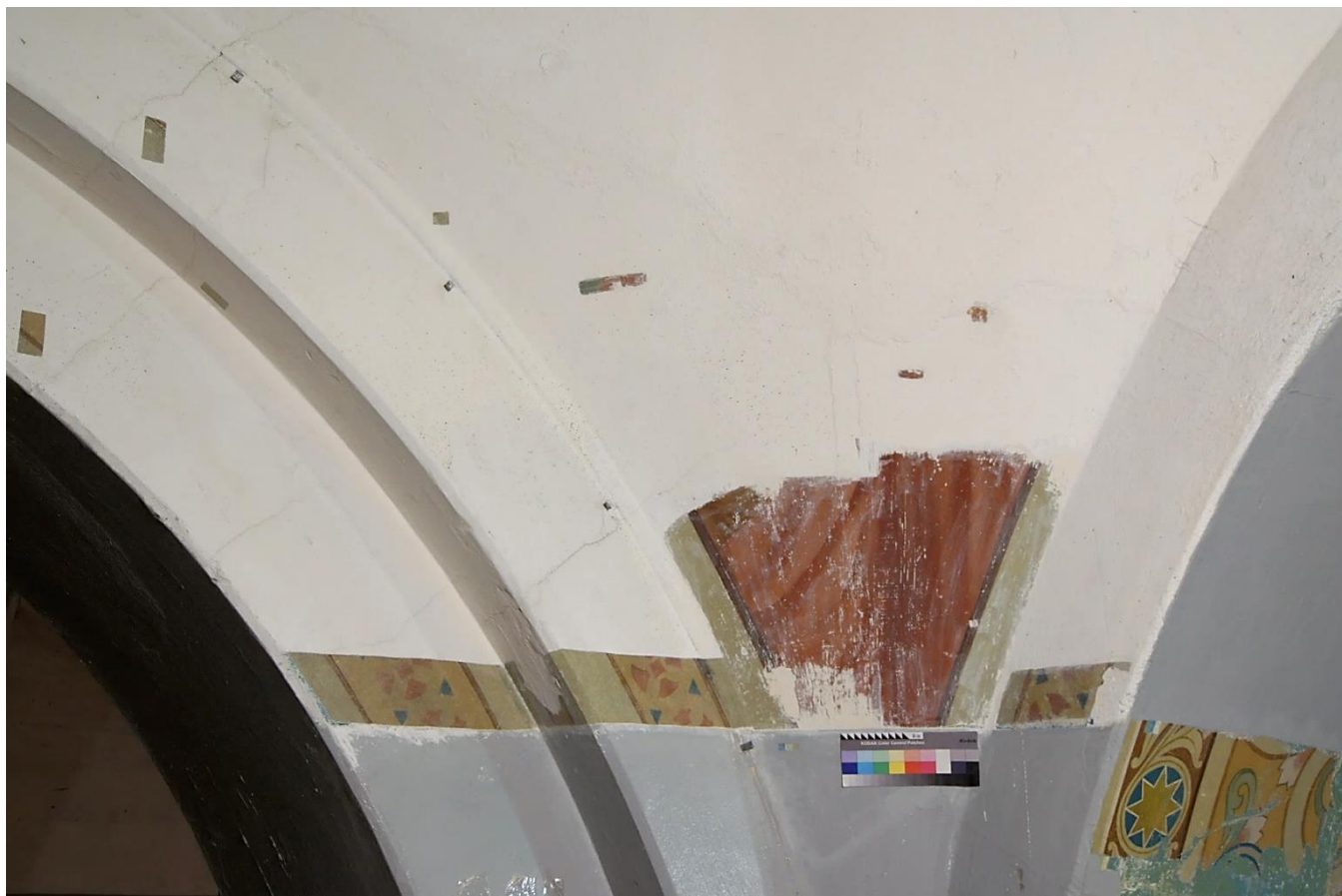
2.9 Фрагмент №1 в процессе реставрации. В процессе удаления малярной побелки с поверхности живописного слоя. Прямое освещение
