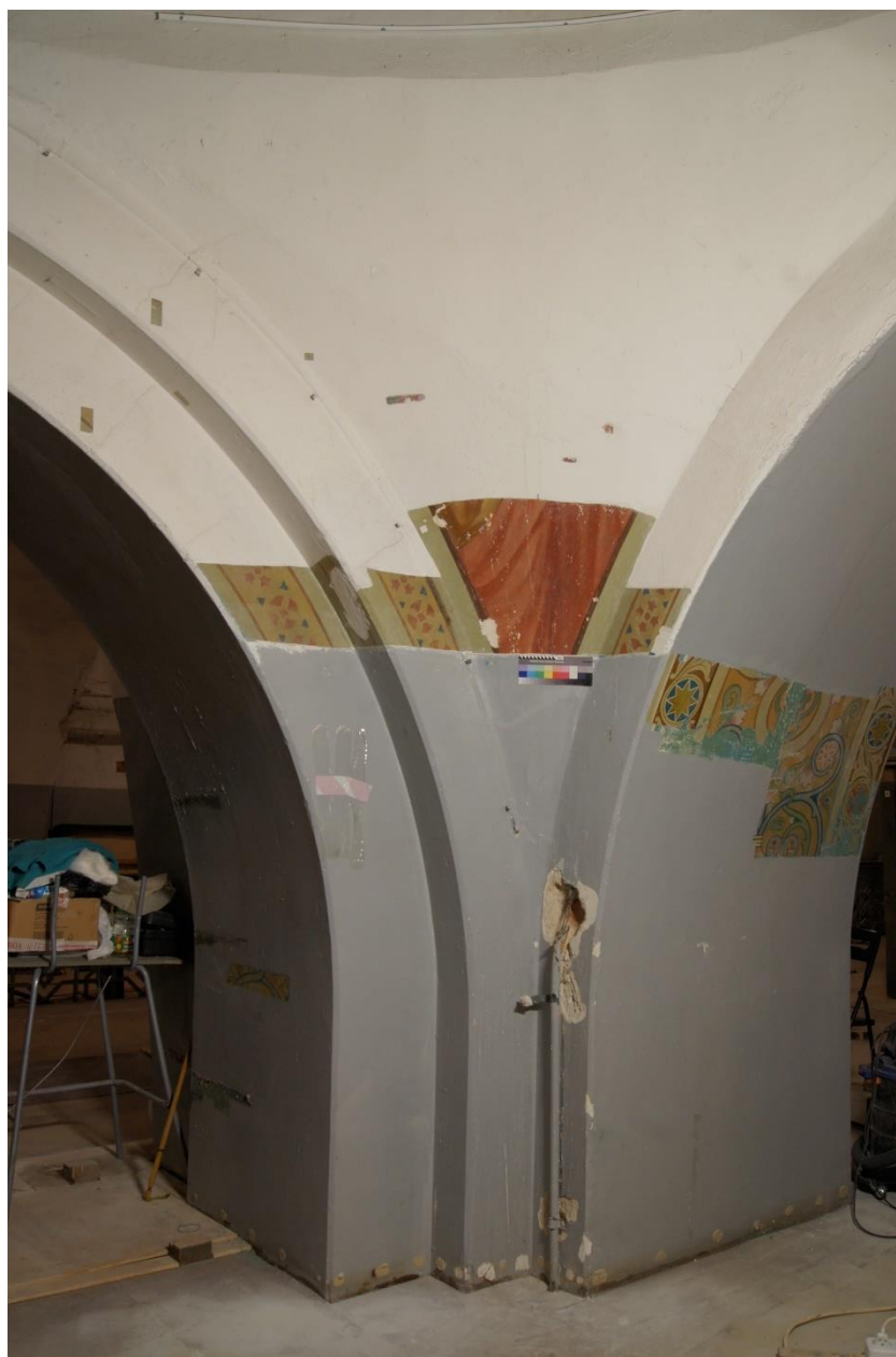
2.4 Общий вид северо-западного малого паруса с арками в процессе реставрации. В процессе удаления малярной побелки с поверхности живописного слоя. Прямое освещение
