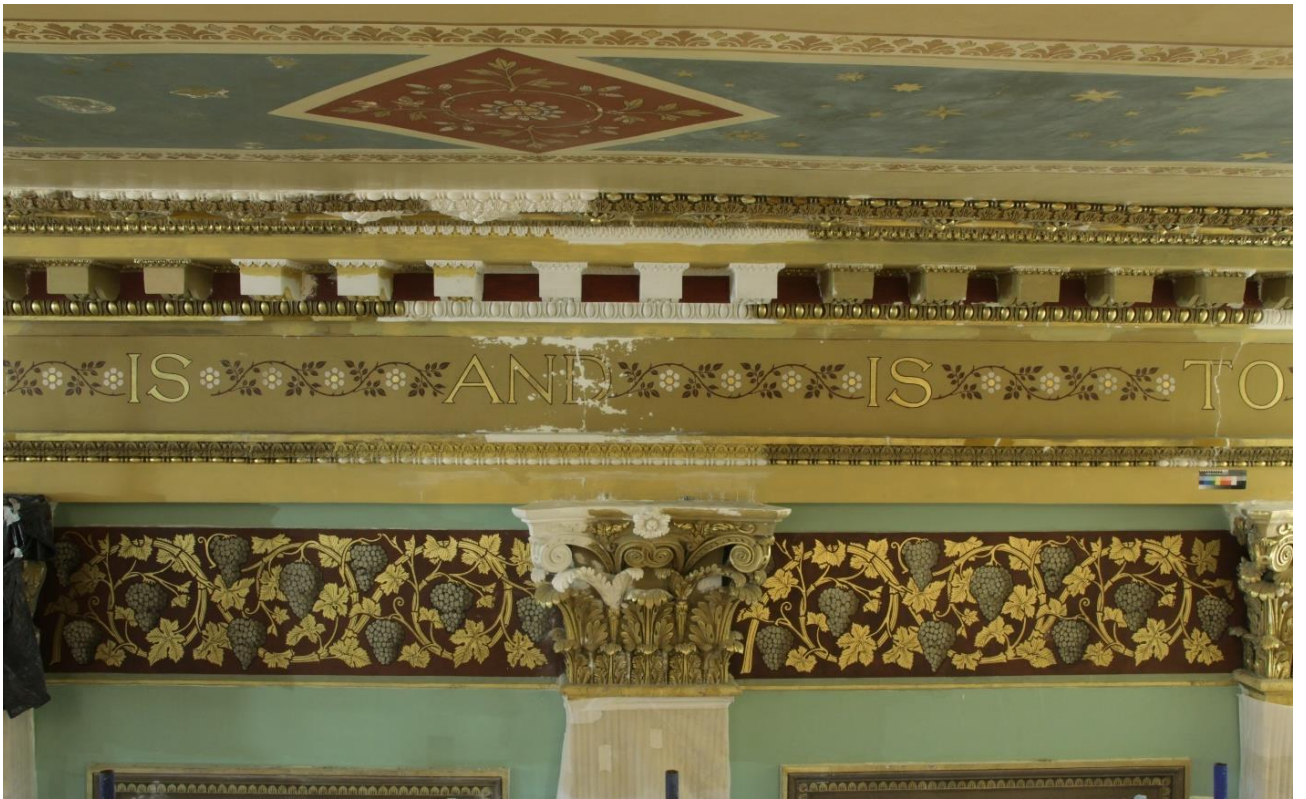
2.8 Общий вид фрагмента северного фриза в процессе реставрации. Трещины проинъектированы, подведён реставрационный грунт. Прямое освещение
