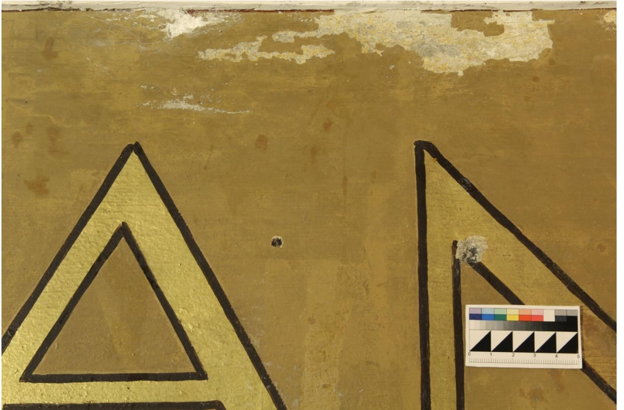
2.73 Фрагмент №9 в процессе реставрации. После укрепления штукатурной накрывки методом инъектирования с помощью известкового раствора для инъекций. После укрепления отставаний и шелушений красочного слоя. Прямое освещение
