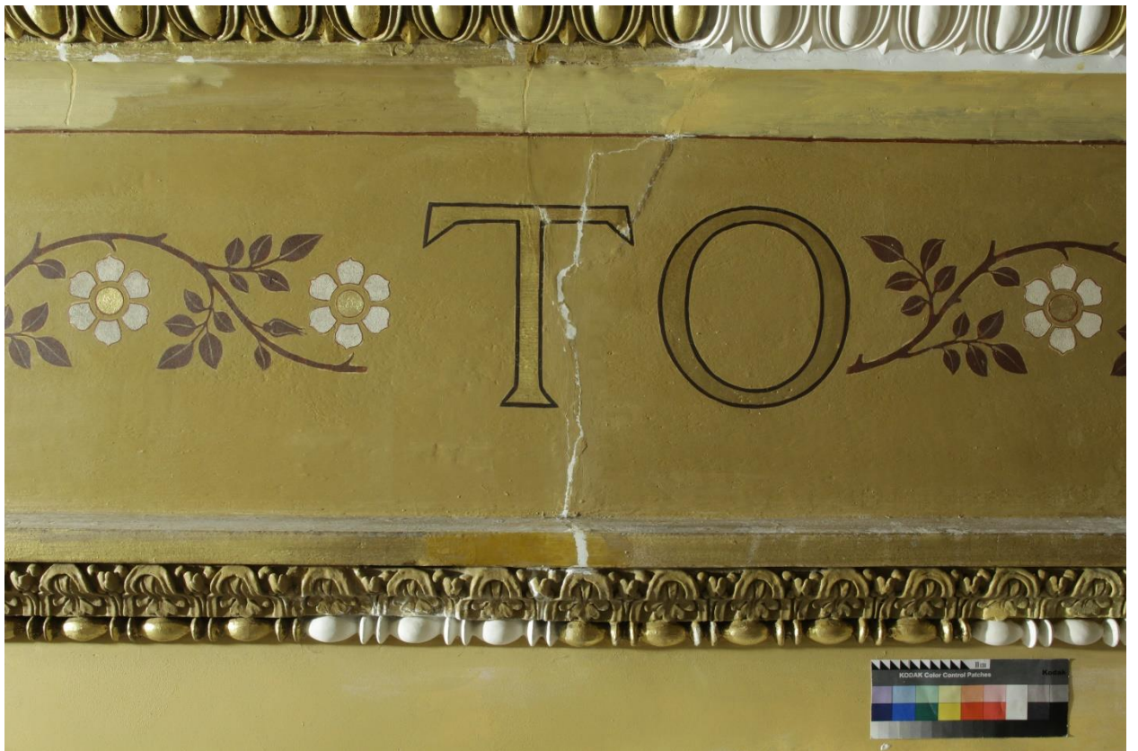
2.85 Фрагмент №11 в процессе реставрации. Трещины проинъецированы, подведён реставрационный грунт. Удалены загрязнения. Боковое освещение
