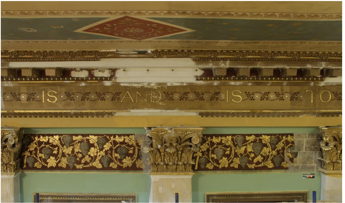
2.6 Общий вид фрагмента северного фриза в процессе реставрации. После укрепления отставаний и шелушений красочного слоя, в процессе удаления загрязнений. Прямое освещение
