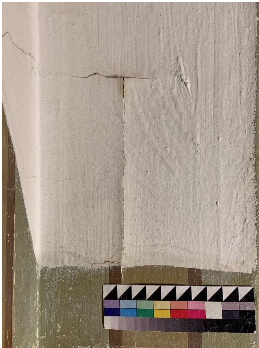
2.27 Фрагмент №4 в процессе реставрации. До укрепления отставаний красочного слоя вместе со штукатурной накрывкой. Прямое освещение
