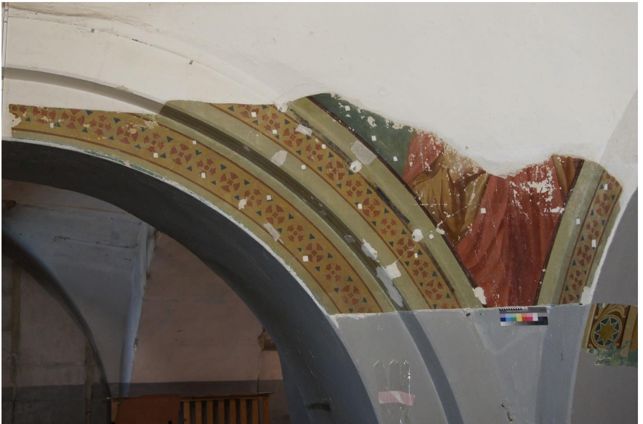
2.19 Фрагмент №1 в процессе реставрации. В процессе удаления малярной побелки с поверхности живописного слоя. Прямое освещение
