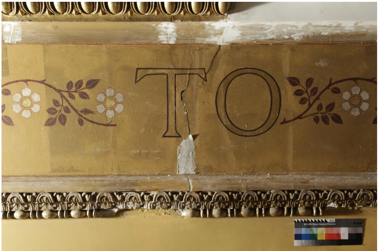
2.81 Фрагмент №11 в процессе реставрации. После удаления заклейки из папиросной бумаги. До начала укрепления шелушений и отставаний красочного слоя. Боковое освещение
