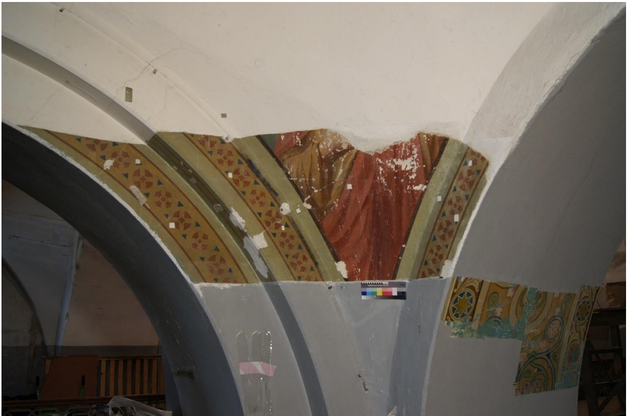
2.16 Фрагмент №1 в процессе реставрации. В процессе удаления малярной побелки с поверхности живописного слоя. Прямое освещение
