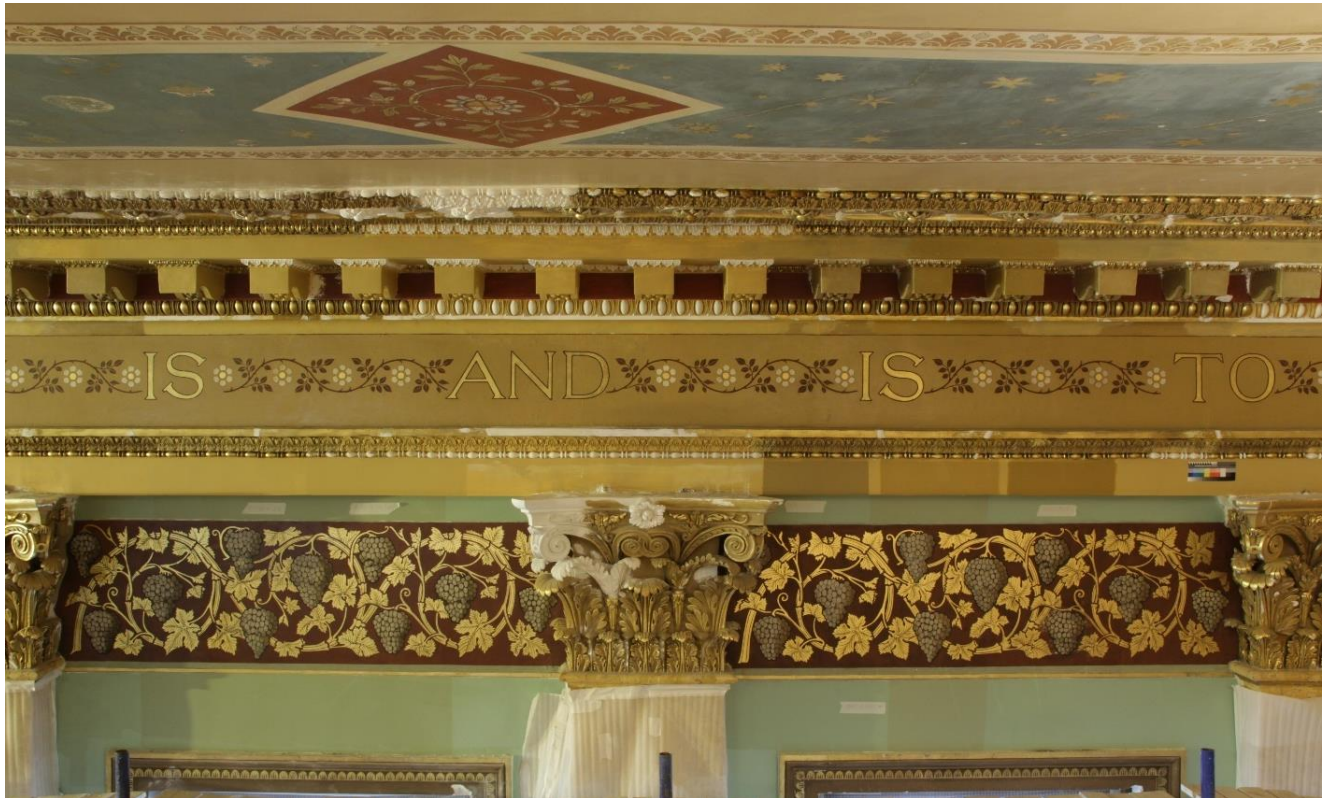
2.9 Общий вид фрагмента северного фриза после реставрации. После восполнения утрат красочного слоя. Прямое освещение
