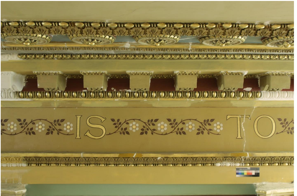
2.20 Фрагмент №2 в процессе реставрации. Трещины проинъектированы, подведён реставрационный грунт. Прямое освещение
