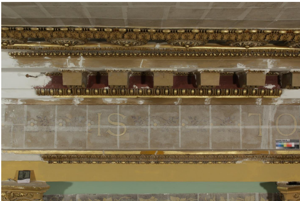
2.16 Фрагмент №2 до начала реставрации. Прямое освещение
