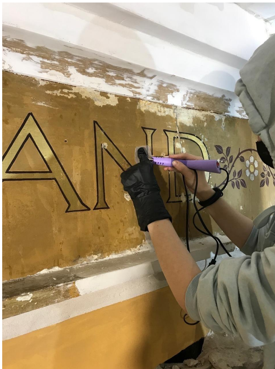
2.32 Фрагмент №4 в процессе реставрации. В процессе укрепления шелушений и отставаний красочного слоя. Прямое освещение
