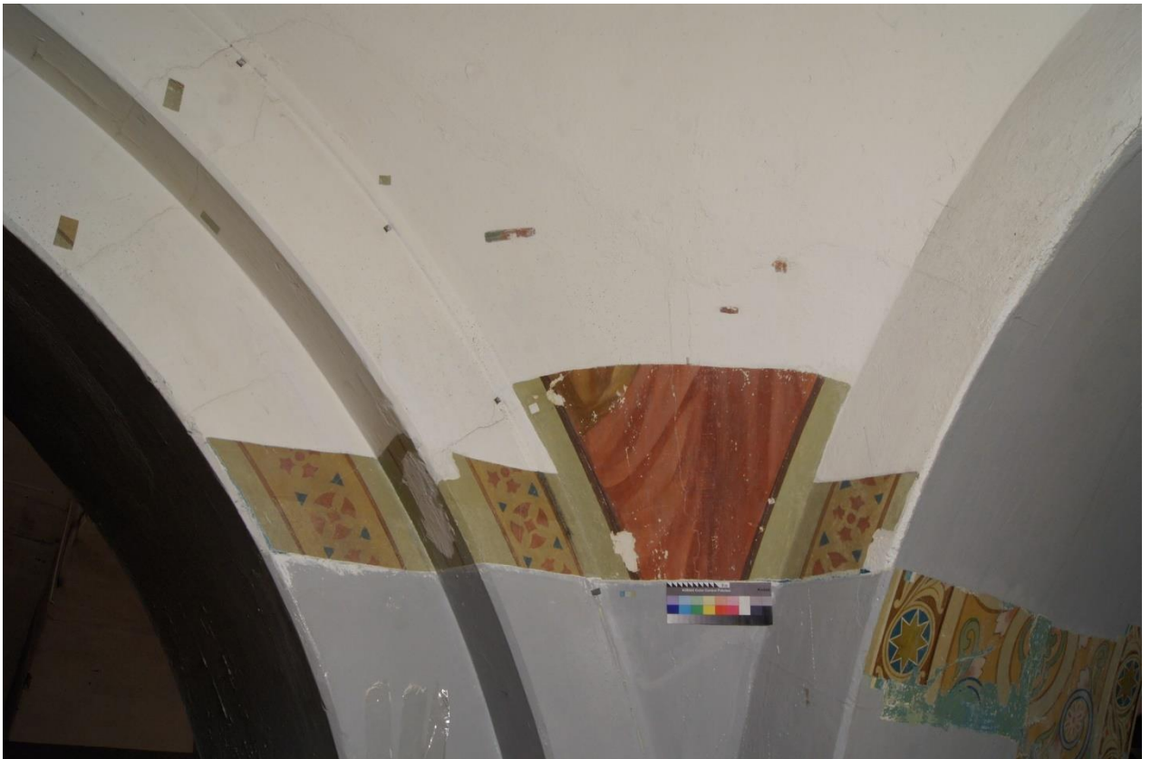
2.12 Фрагмент №1 в процессе реставрации. В процессе удаления малярной побелки с поверхности живописного слоя. Прямое освещение
