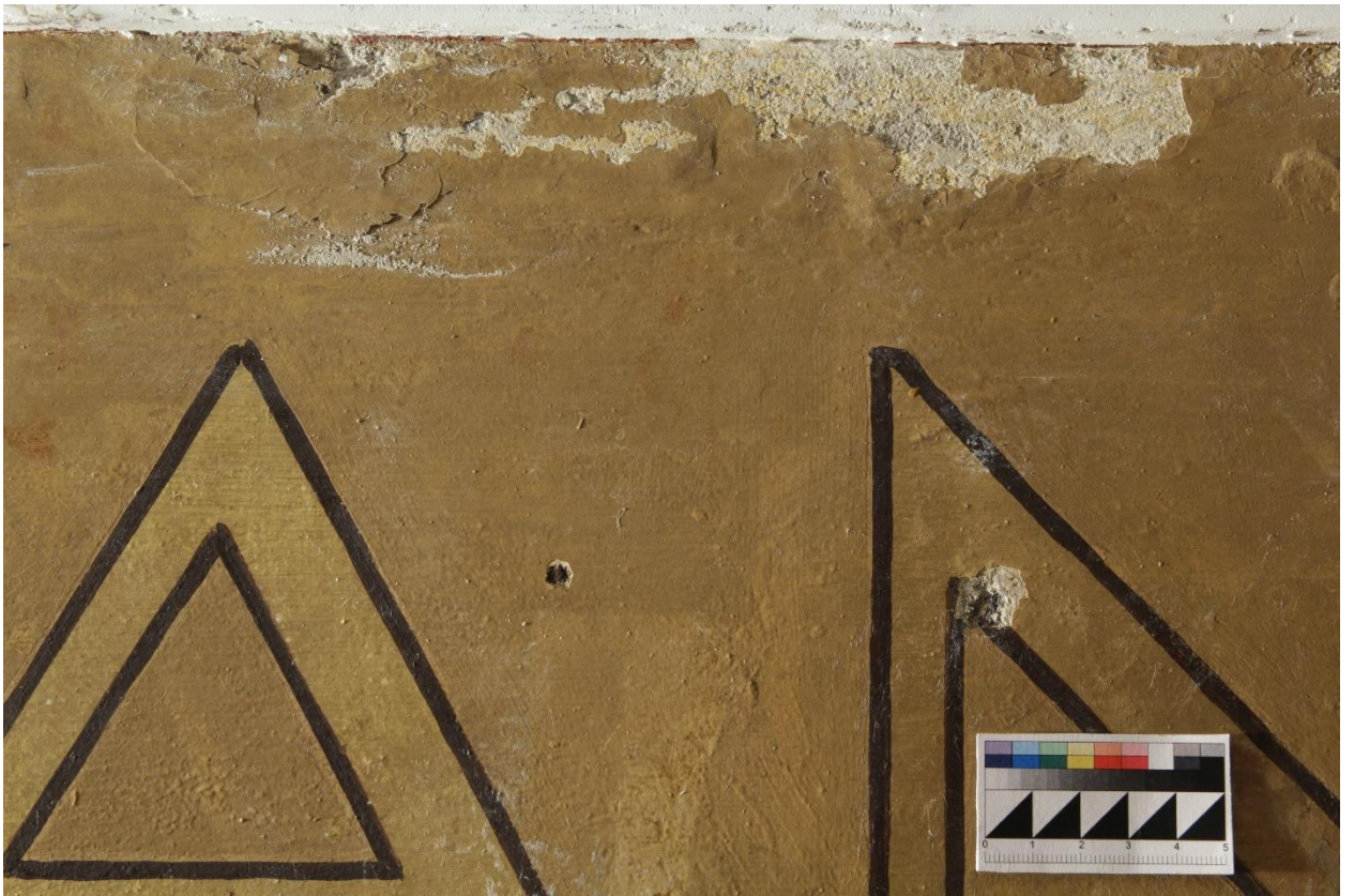
2.72 Фрагмент №9 в процессе реставрации. До начала укрепления шелушений и отставаний красочного слоя. Область отставаний штукатурной накрывки вместе с живописными слоями в верхней левой части фрагмента. Боковое освещение
