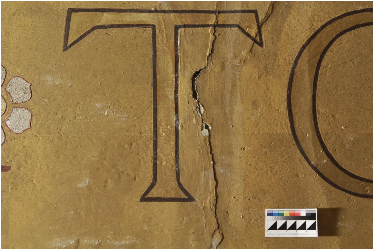
2.88 Фрагмент №12 в процессе реставрации. После удаления заклейки из папиросной бумаги. До начала укрепления шелушений и отставаний красочного слоя. Боковое освещение
