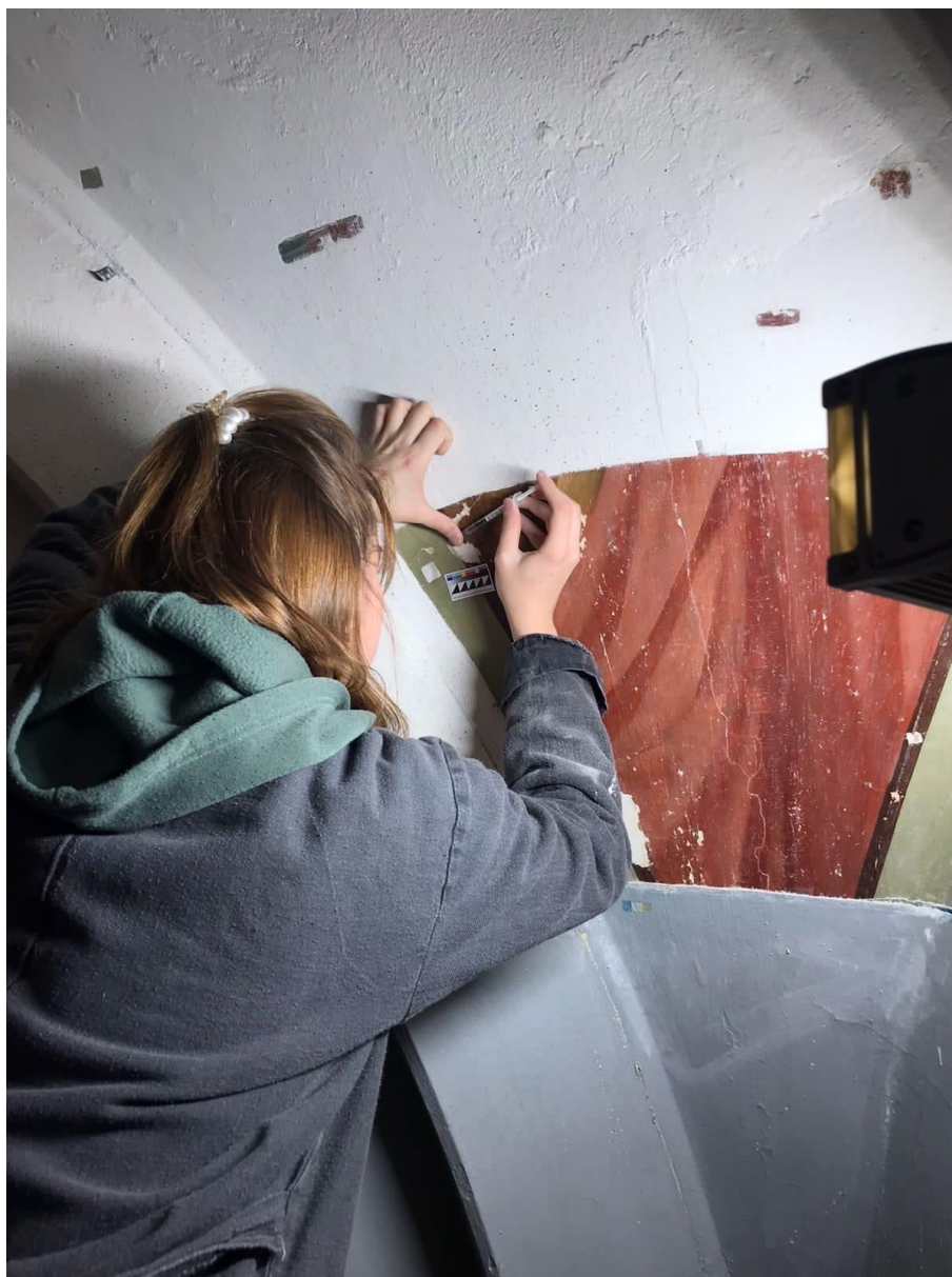
2.26 Фрагмент малого паруса в процессе реставрации. В процессе укрепления отставаний красочного слоя. Прямое освещение
