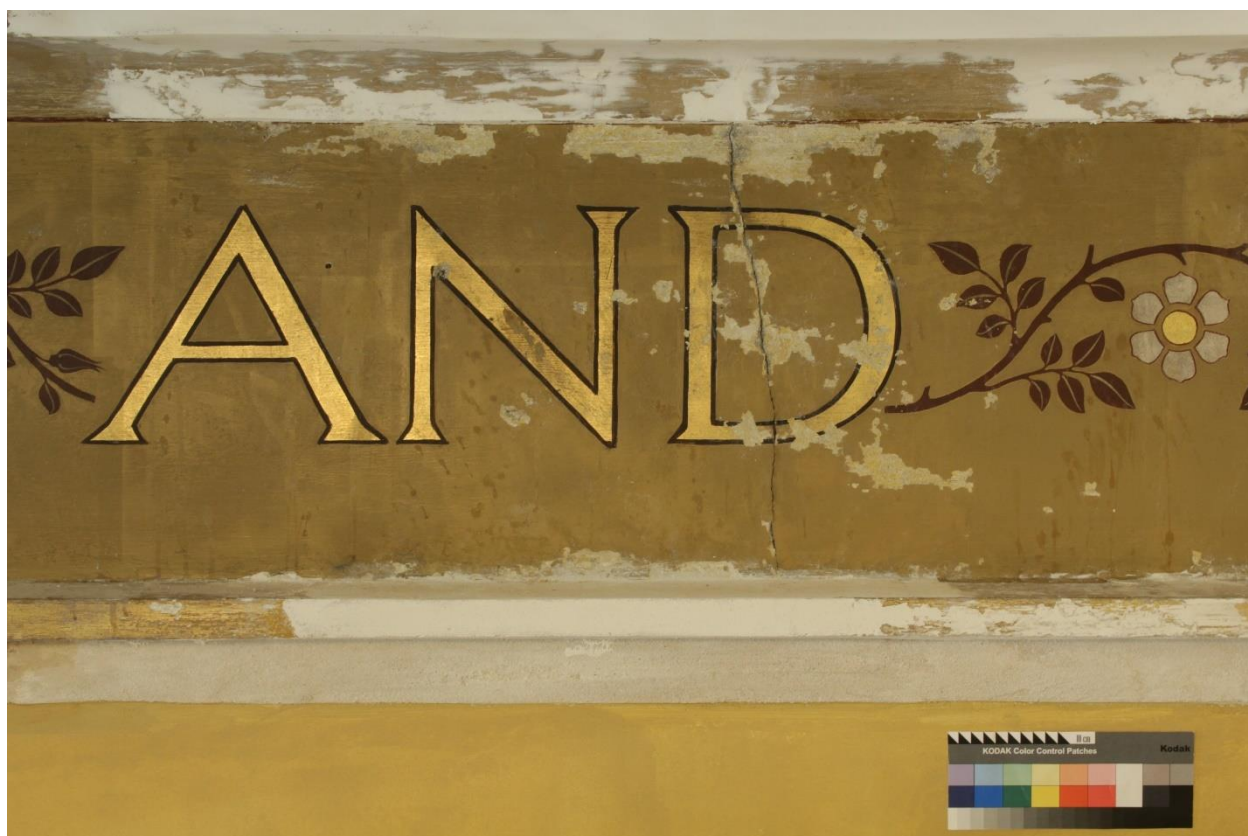
2.30 Фрагмент №4 в процессе реставрации. До начала укрепления шелушений и отставаний красочного слоя. Прямое освещение
