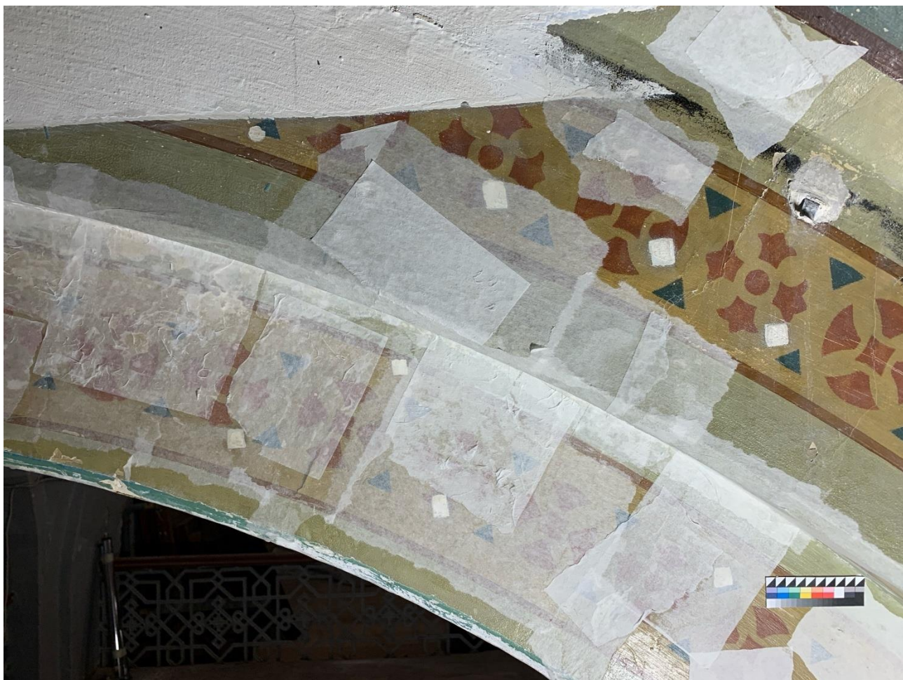
2.46 Фрагмент №13 в процессе реставрации. В процессе удаления солей из структуры живописи с помощью увлажненных водой компрессов из микалентной и фильтровальной бумаг. Прямое освещение
