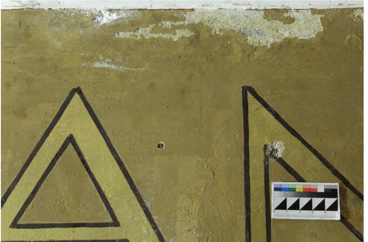
2.74 Фрагмент №9 в процессе реставрации. После укрепления штукатурной накрывки методом инъектирования с помощью известкового раствора для инъекций. После укрепления отставаний и шелушений красочного слоя. Боковое освещение
