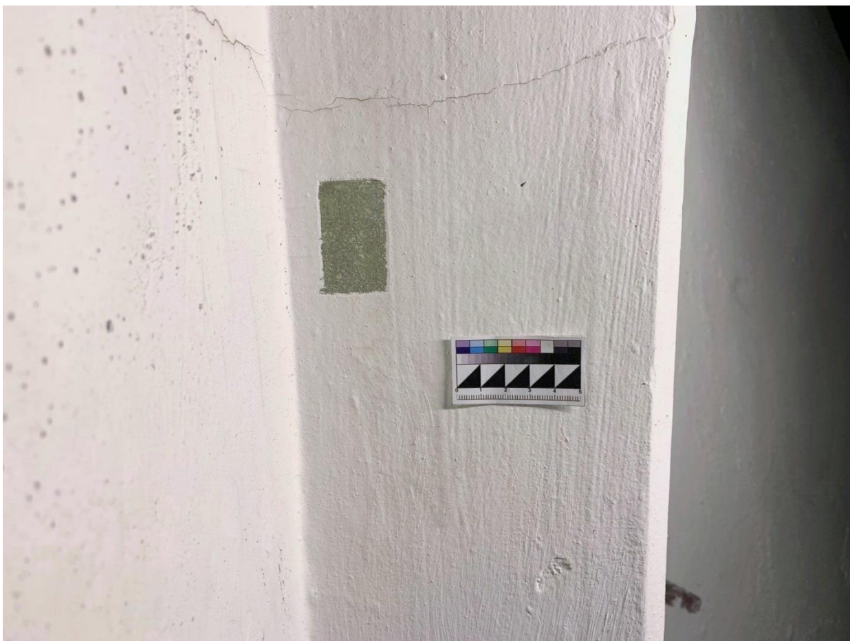
1.3 Исследование в виде пробной расчистки на обнаружение авторского живописного слоя. Фрагмент арки южного малого свода. Прямое освещение. Исследование показало наличие живописного слоя под малярной побелкой
