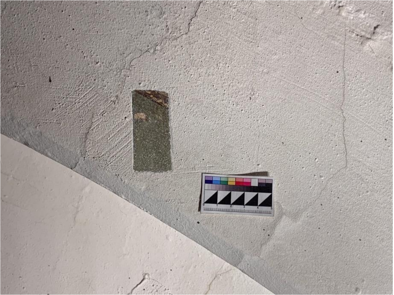
1.1 Исследование в виде пробной расчистки на обнаружение авторского живописного слоя. Фрагмент северо-западной арки южного малого свода. Прямое освещение.
