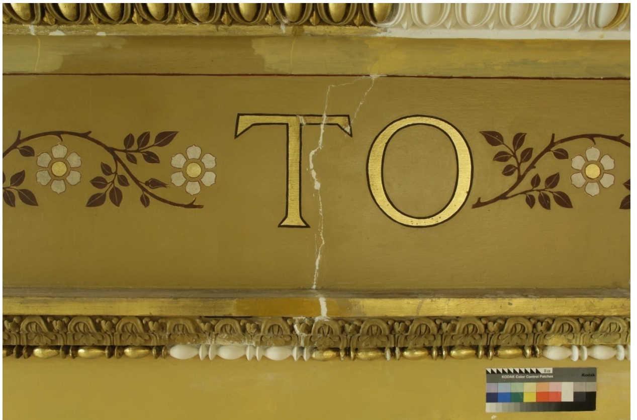
2.84 Фрагмент №11 в процессе реставрации. Трещины проинъектированы, подведён реставрационный грунт. Удалены загрязнения. Прямое освещение
