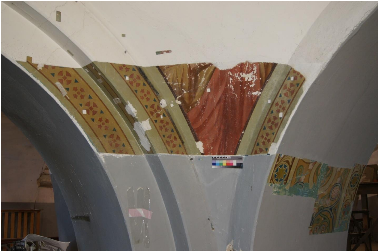
2.15 Фрагмент №1 в процессе реставрации. В процессе удаления малярной побелки с поверхности живописного слоя. Прямое освещение
