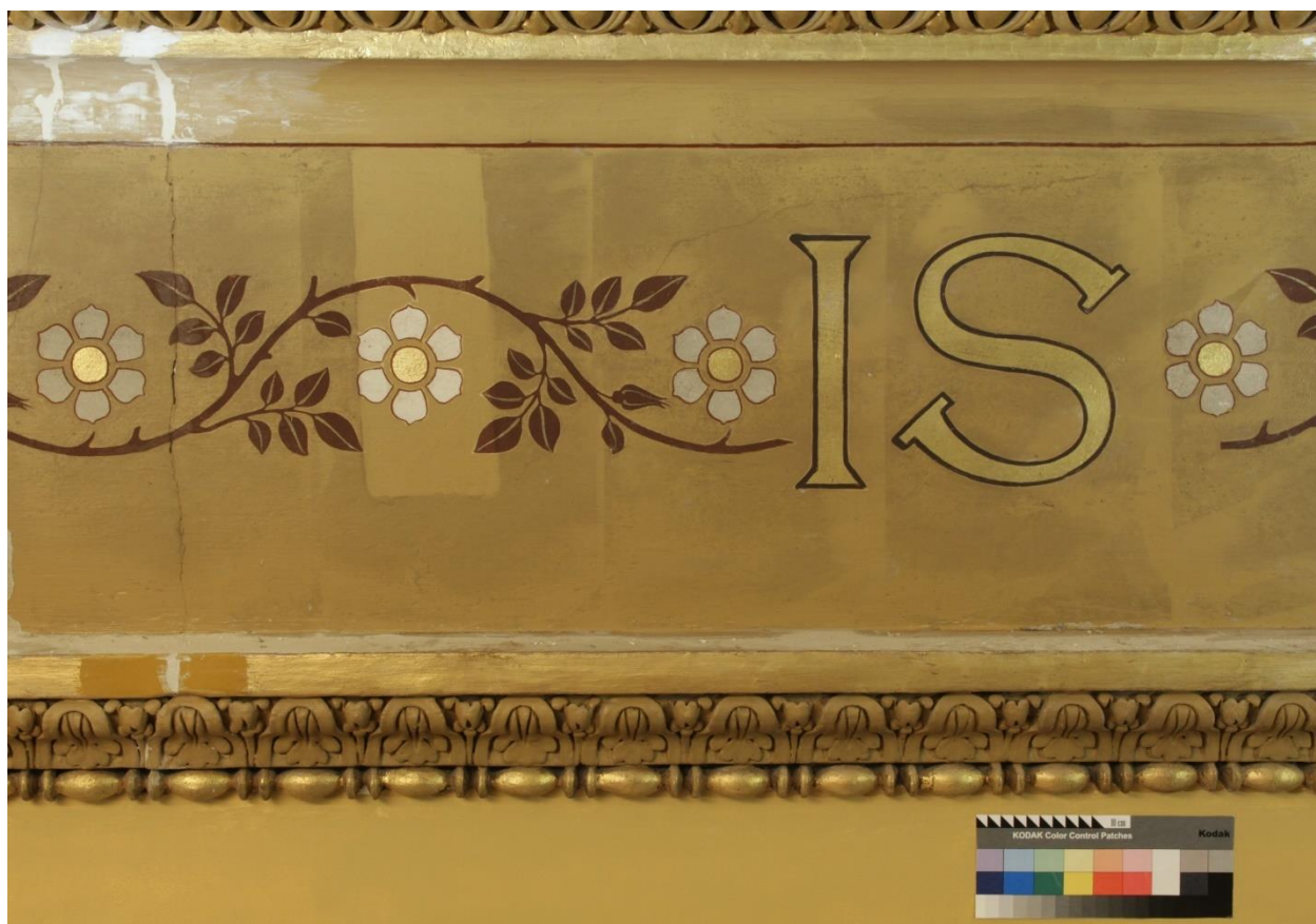
2.22 Фрагмент №3 в процессе реставрации. После удаления заклеек из папиросной бумаги. Выполнены пробы на удаление загрязнений. Прямое освещение
