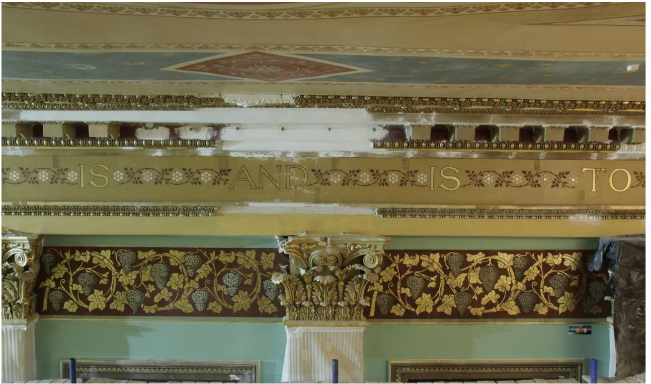
2.7 Общий вид фрагмента северного фриза в процессе реставрации. После удаления загрязнений. Прямое освещение
