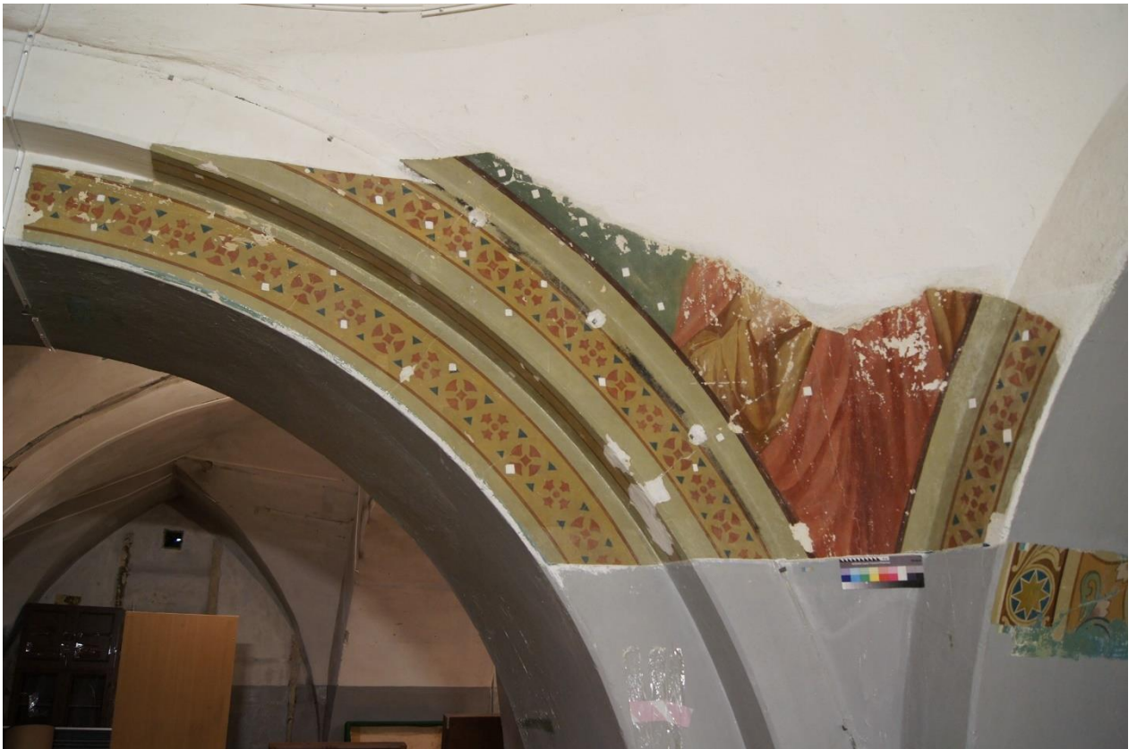
2.20 Фрагмент №1 в процессе реставрации. В процессе удаления малярной побелки с поверхности живописного слоя. Прямое освещение
