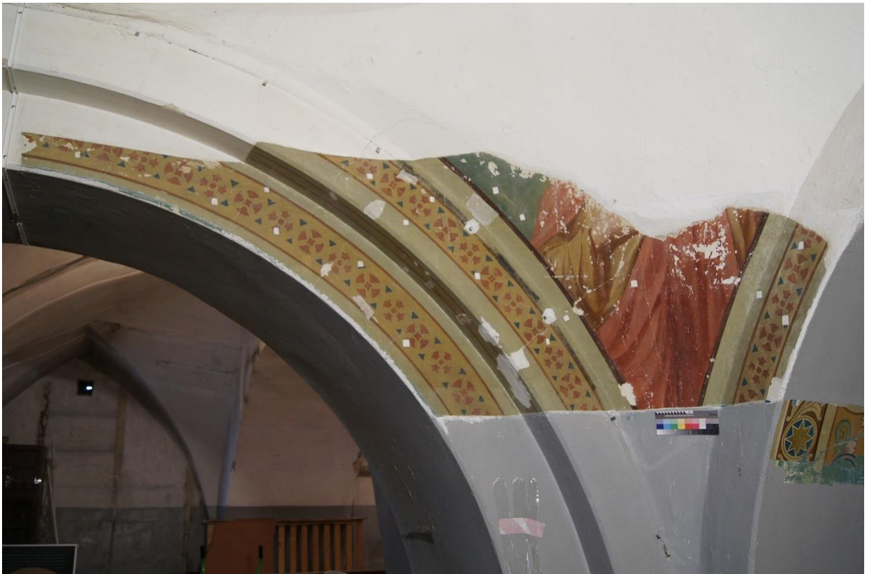
2.18 Фрагмент №1 в процессе реставрации. В процессе удаления малярной побелки с поверхности живописного слоя. Прямое освещение
