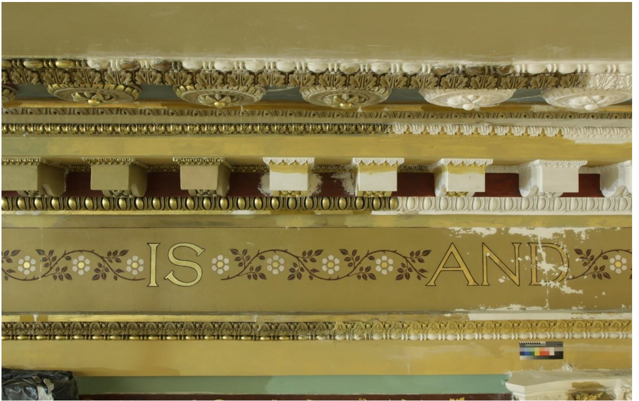
2.14 Фрагмент №1 в процессе реставрации. Трещины проинъектированы, подведён реставрационный грунт. Прямое освещение
