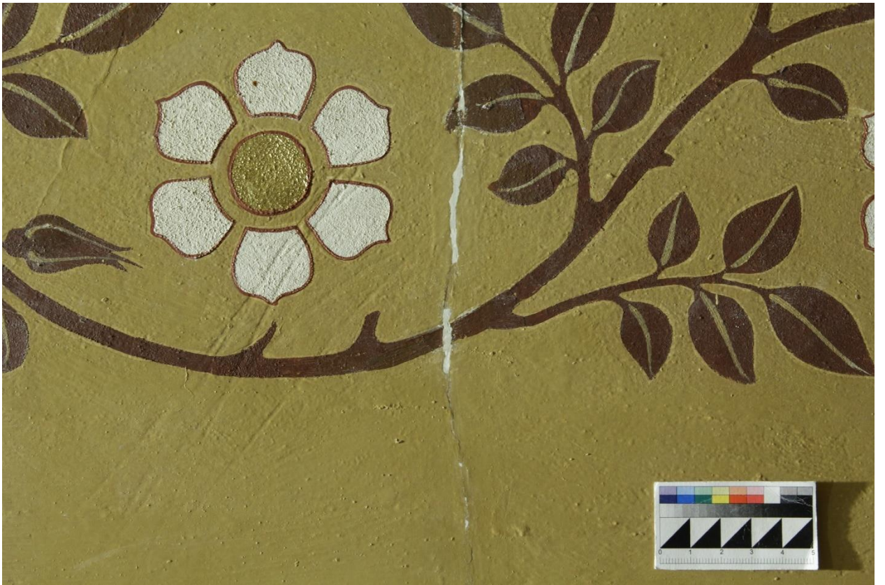
2.45 Фрагмент №5 в процессе реставрации. Трещины проинъектированы, подведён реставрационный грунт. Боковое освещение
