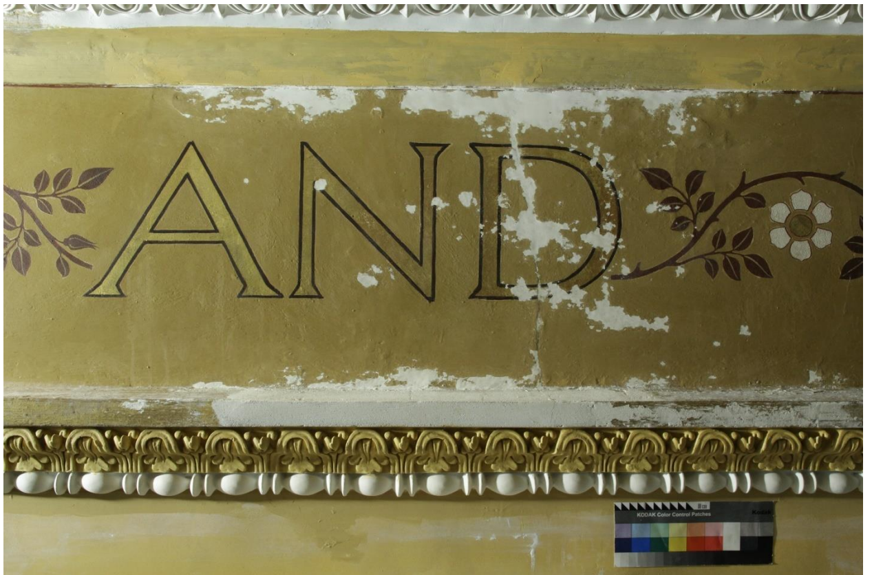
2.38 Фрагмент №4 в процессе реставрации. Трещины проинъектированы, подведён реставрационный грунт. Боковое освещение
