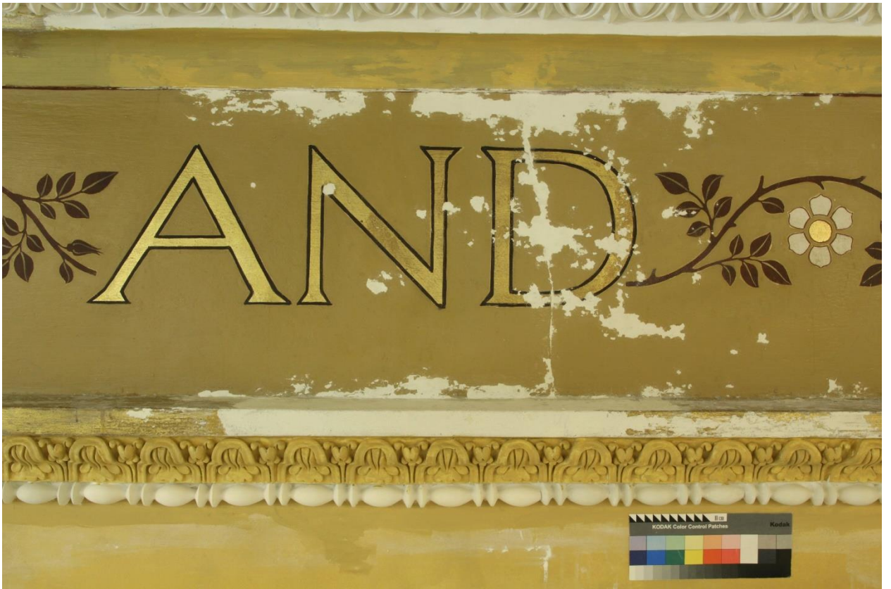
2.37 Фрагмент №4 в процессе реставрации. Трещины проинъектированы, подведён реставрационный грунт. Прямое освещение
