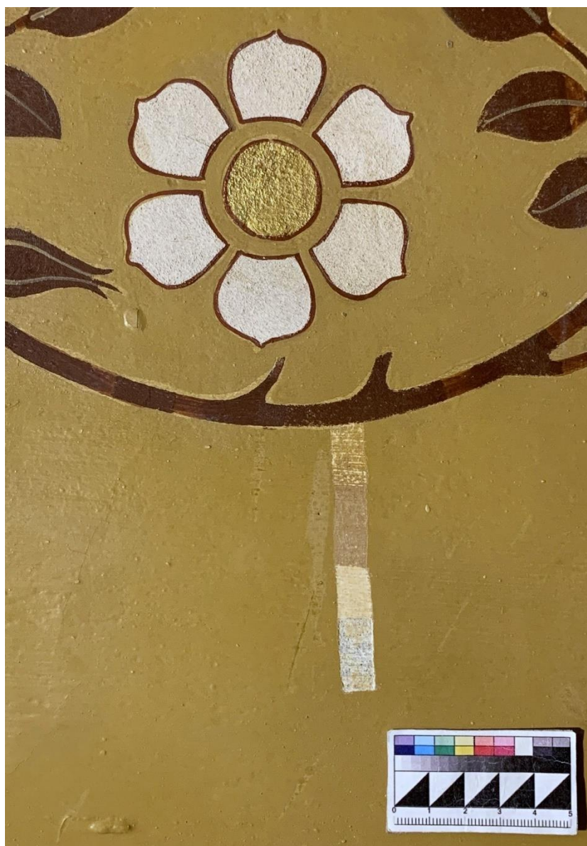
1.7 Послойная расчистка на определение количества поздних живописных слоёв
