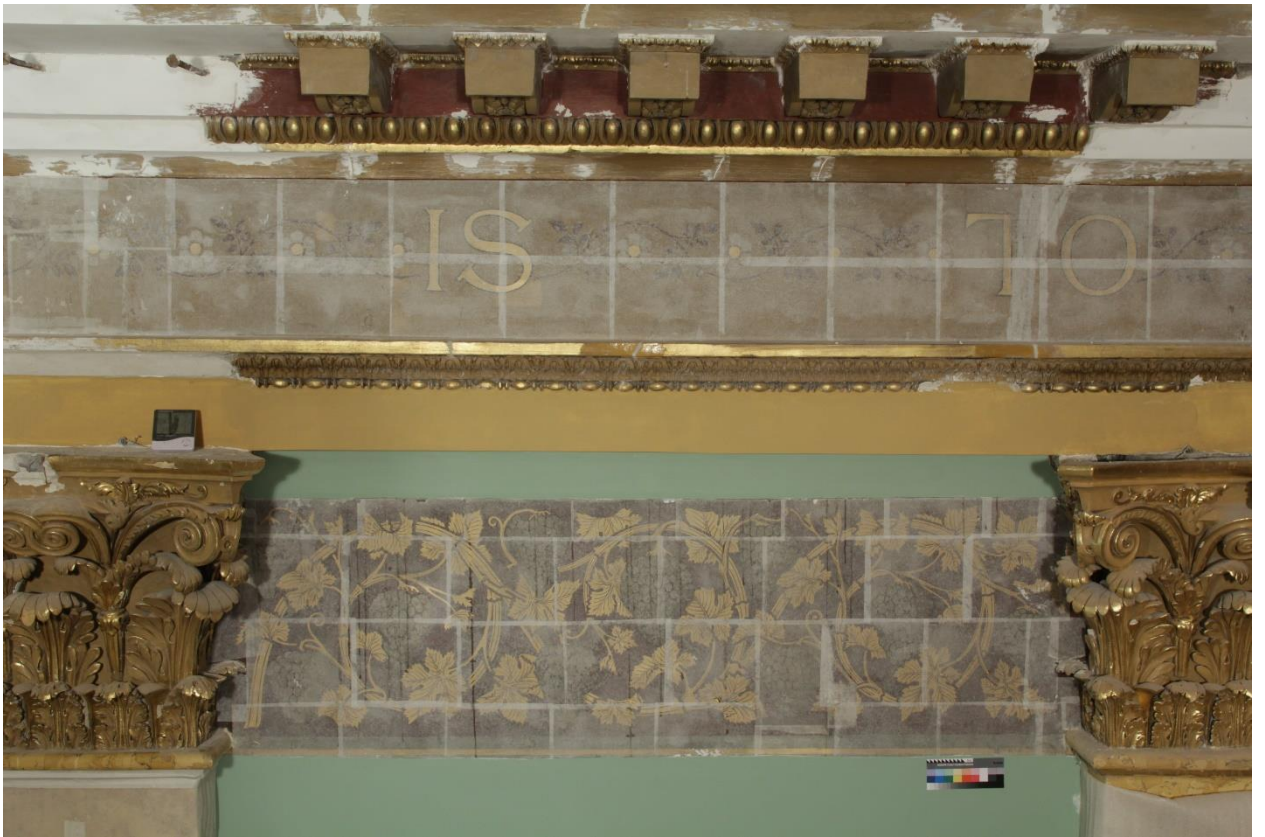
2.3 Фрагмент правой половины реставрируемого участка северного фриза до начала реставрации. Прямое освещение
