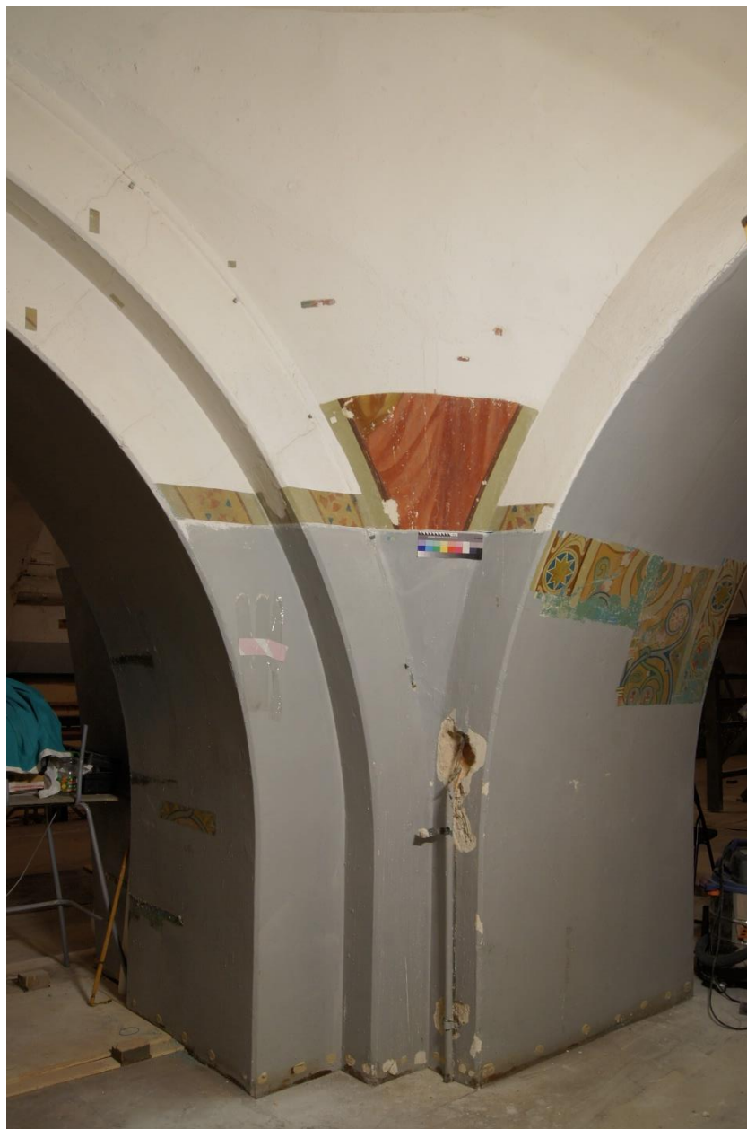
2.3 Общий вид северо-западного малого паруса с арками в процессе реставрации. Выполнены пробные расчистки на обнаружение живописного слоя. Прямое освещение
