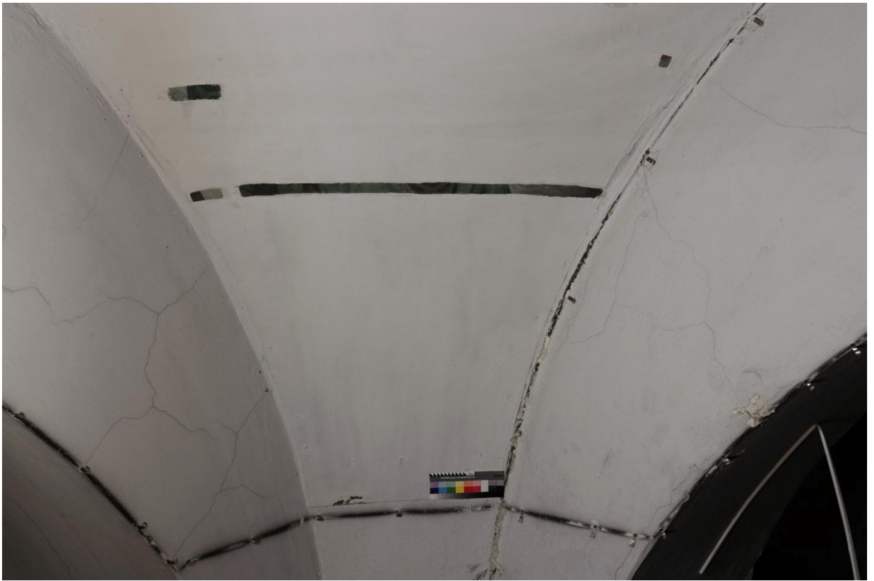
2.33 Фрагмент №2. Прямое освещение В процессе реставрации. Выполнены пробные и ленточная расчистки.
