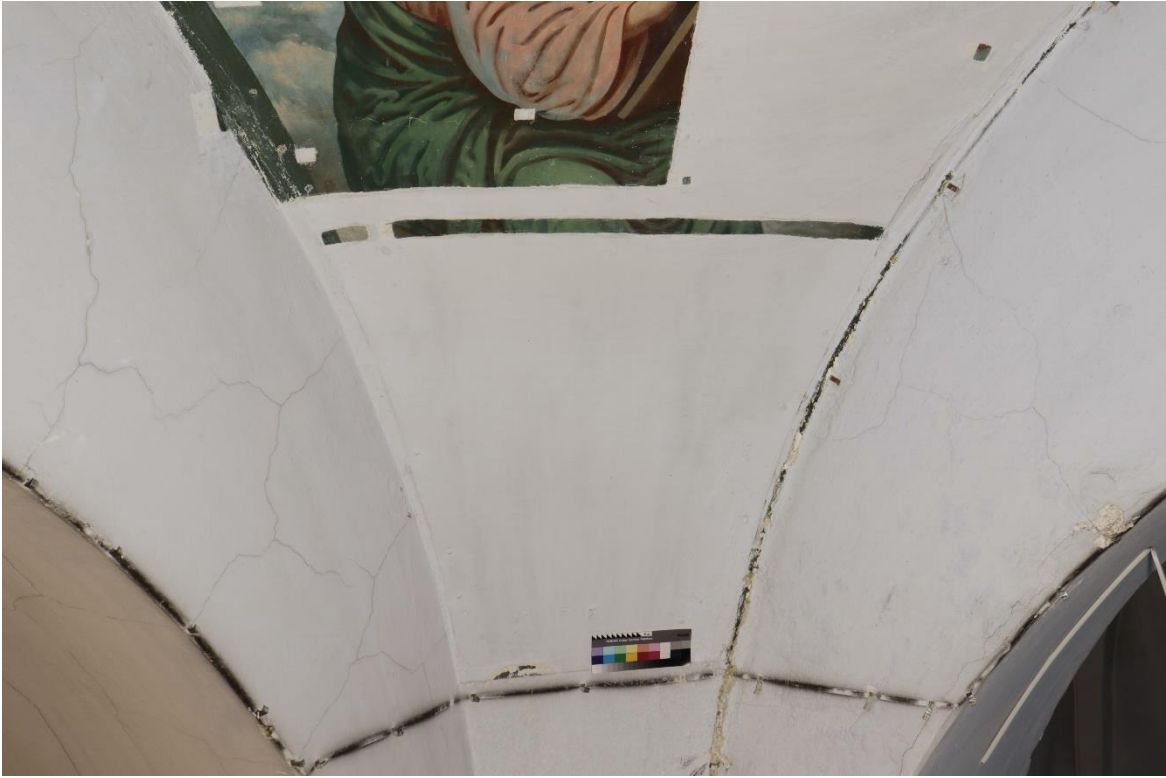
2.35 Фрагмент №2. Прямое освещение. В процессе реставрации. В процессе удаления малярных закрасок с поверхности живописи
