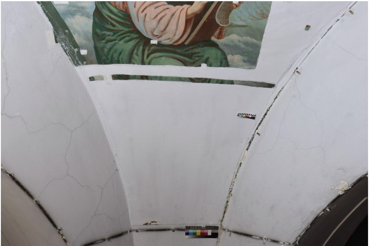
2.36 Фрагмент №2. Прямое освещение. В процессе реставрации. В процессе удаления малярных закрасок с поверхности живописи
