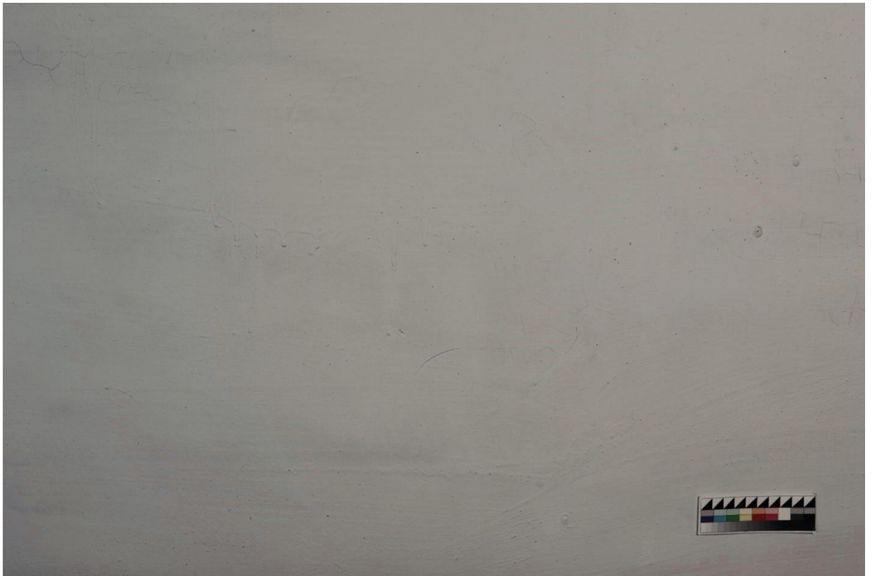
2.11 Фрагмент №5 реставрируемого участка северного паруса. Прямое освещение. До реставрации.
