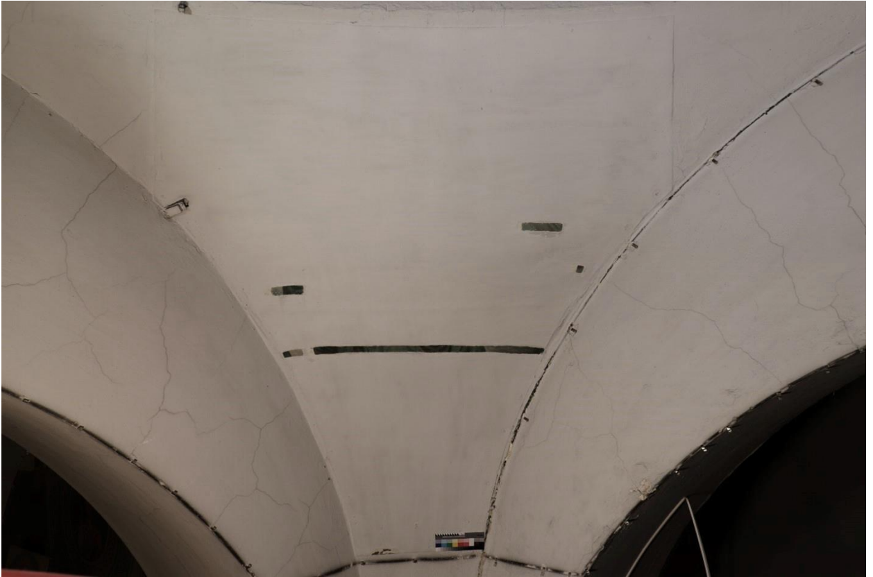
2.18 Общий вид северного паруса. Прямое освещение. В процессе реставрации. В процессе удаления малярных закрасок с поверхности живописи.
