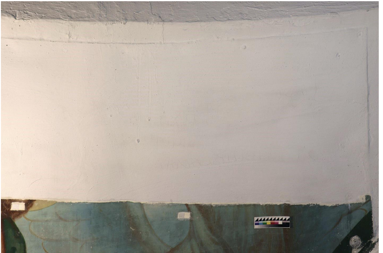
2.66 Фрагмент №6. Прямое освещение. В процессе реставрации. В процессе удаления малярных закрасок с поверхности живописи.
