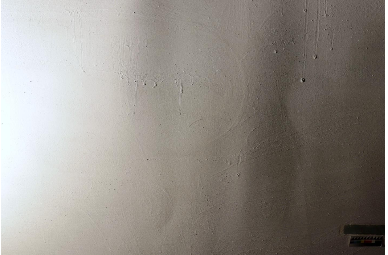
2.10 Фрагмент №4 реставрируемого участка северного паруса. Боковое освещение. До реставрации. В центральной части явно видна фактура нимба, что свидетельствует о наличии изображения под закрасками.
