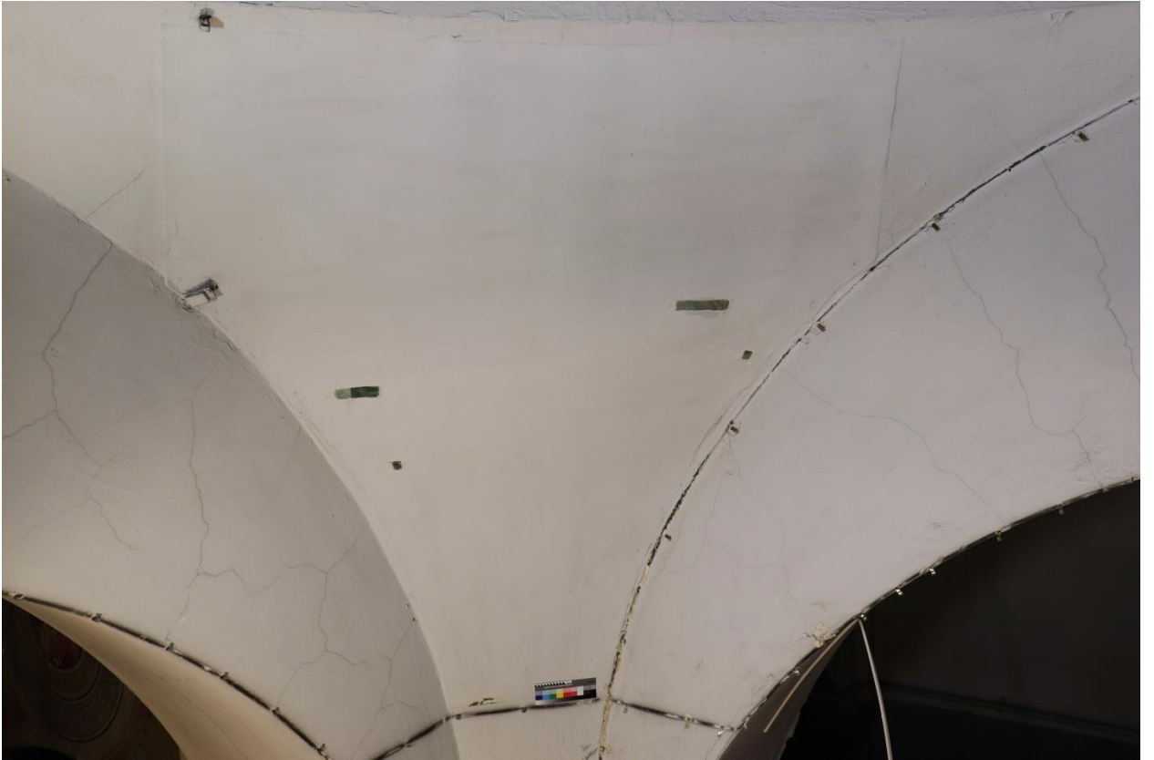
2.4 Общий вид северного паруса. Прямое освещение.
