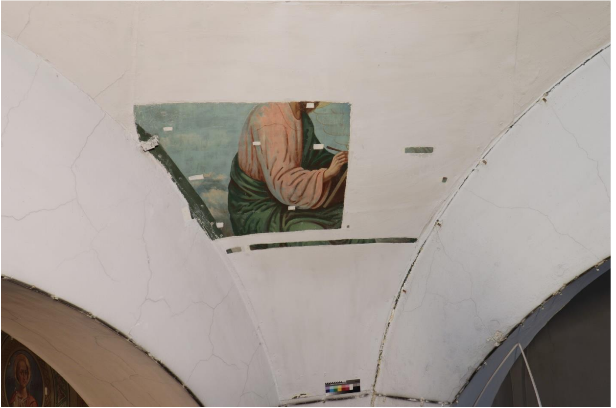
2.20 Общий вид северного паруса. Прямое освещение. В процессе реставрации. В процессе удаления малярных закрасок с поверхности живописи
