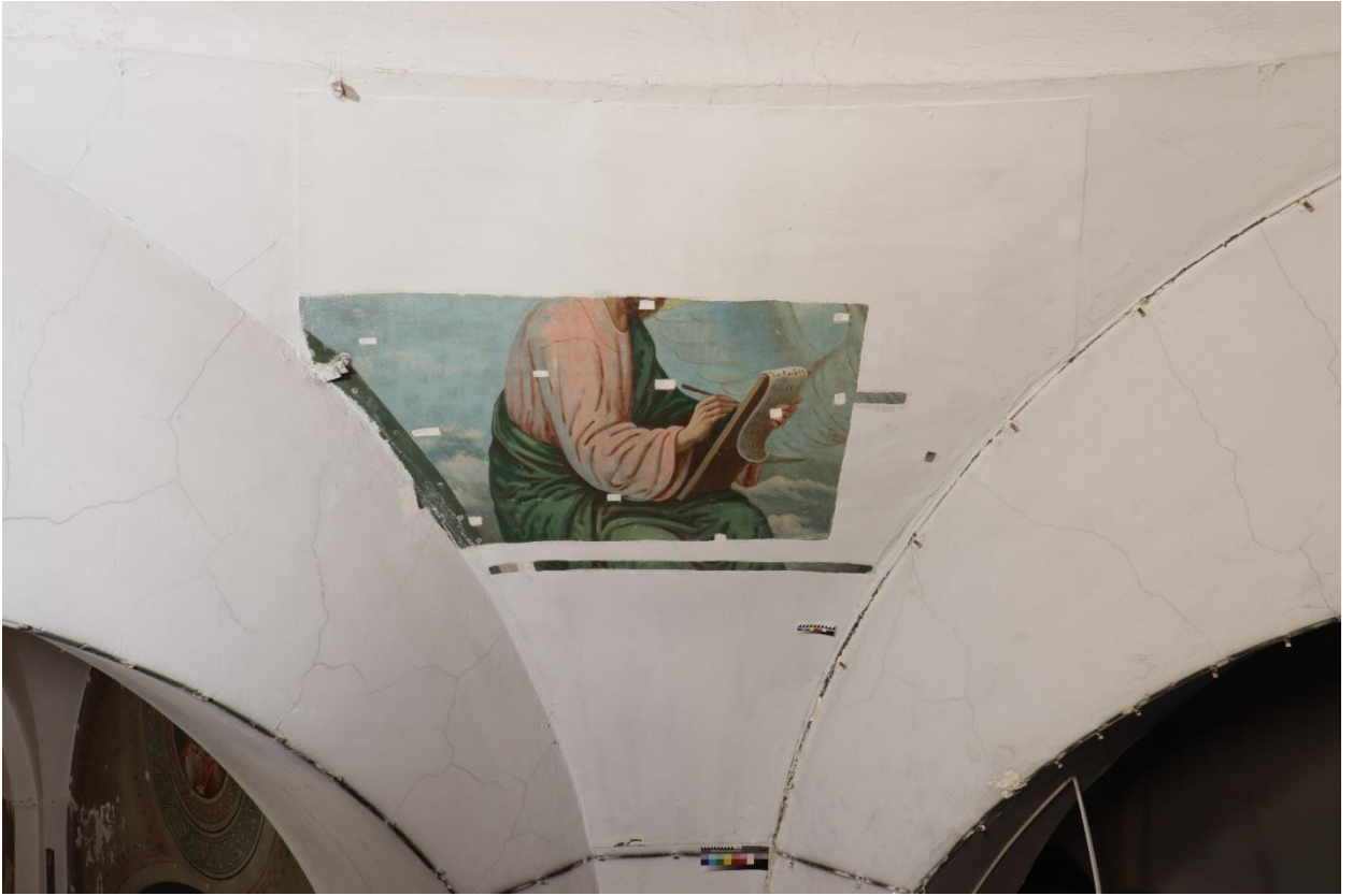
2.21 Общий вид северного паруса. Прямое освещение. В процессе реставрации. В процессе удаления малярных закрасок с поверхности живописи
