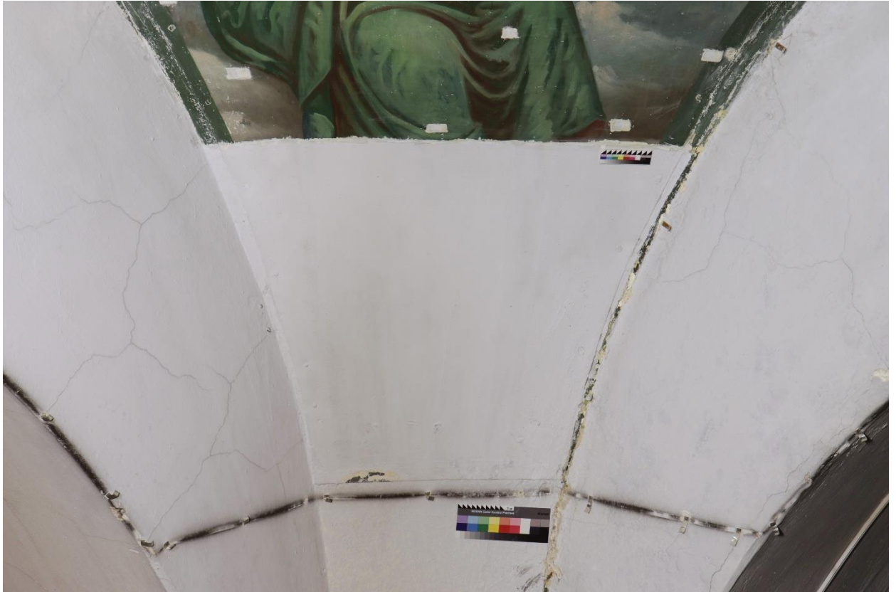
2.38 Фрагмент №2. Прямое освещение. В процессе реставрации. В процессе удаления малярных закрасок с поверхности живописи
