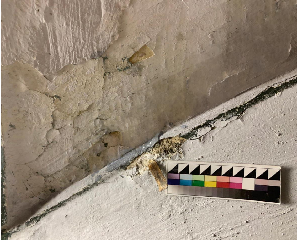
Фрагмент №8 верхней правой части реставрируемого участка после укрепления всех красочных слоев и удаления верхнего слоя побелки. Боковое освещение.
