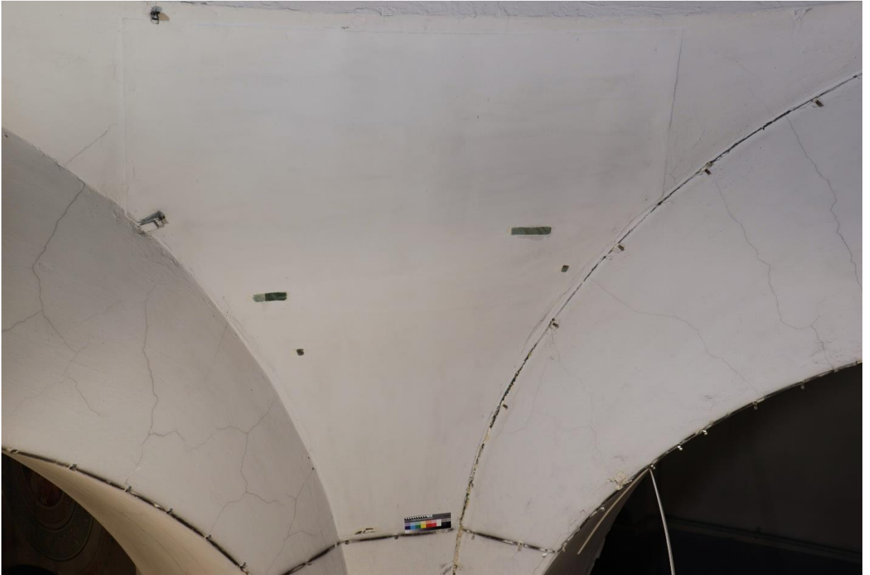
2.17 Общий вид северного паруса. Прямое освещение. До реставрации
