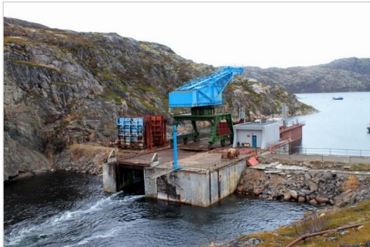
*Рисунок 16. Кислогубская приливная электростанция.*
