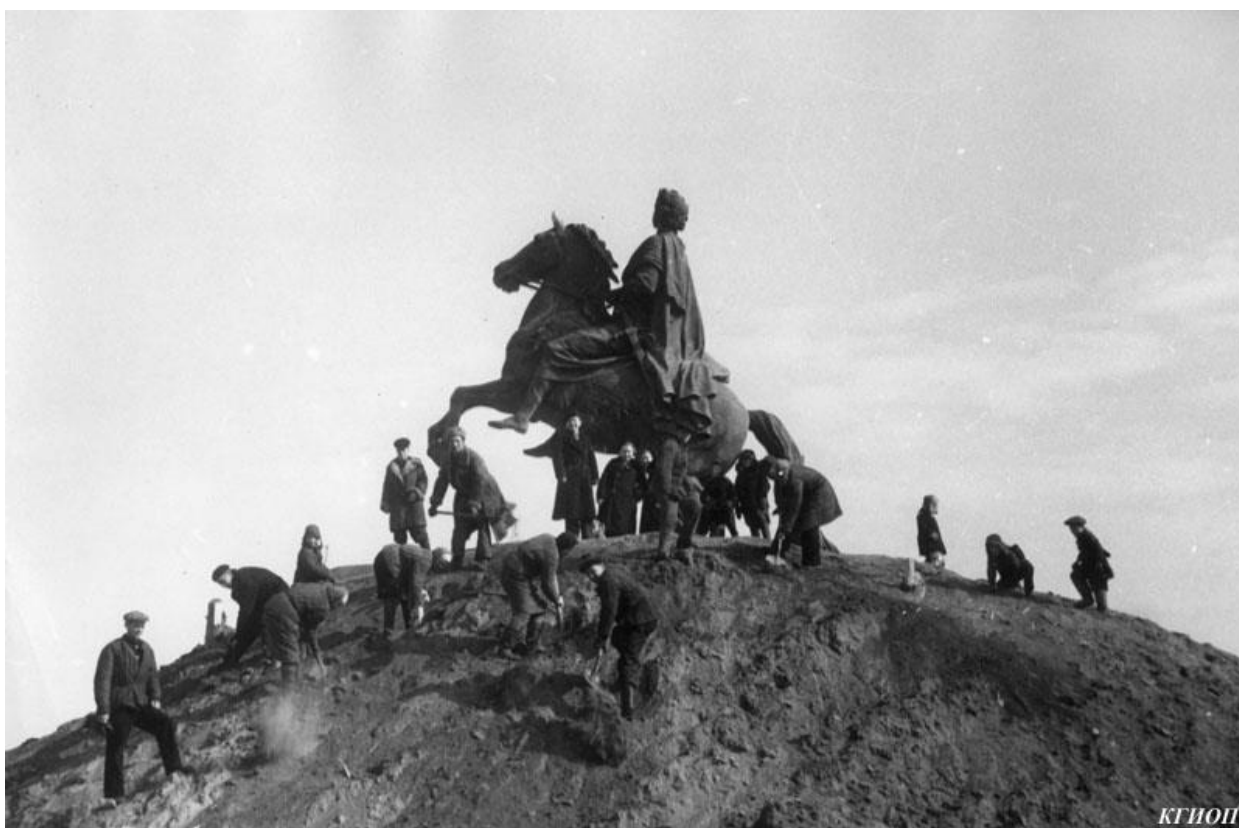
Снятие защитного сооружения с памятника Петру I (Медного всадника),
