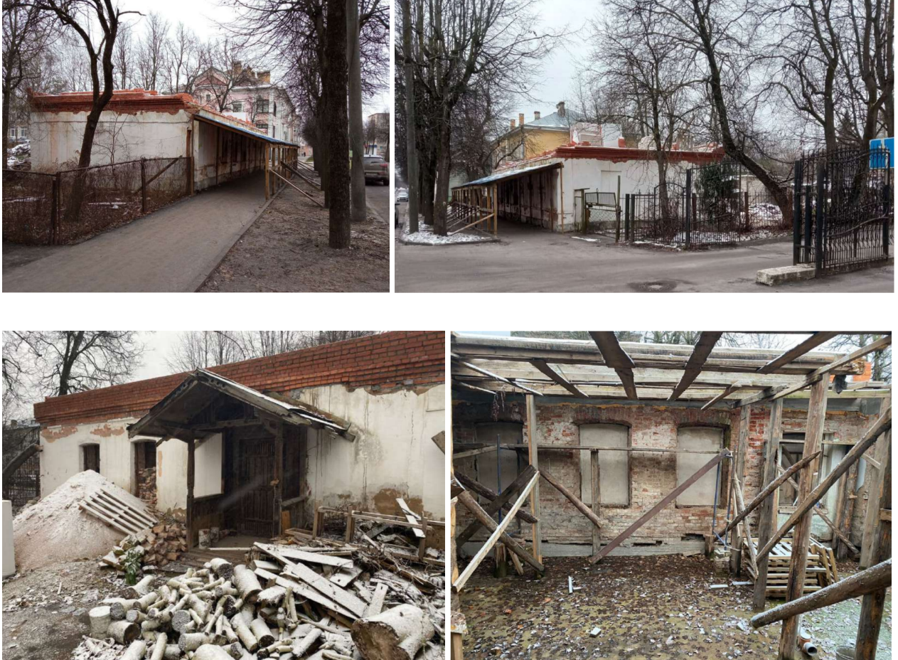
Рис. 1.3.7 Фото текущего состояния проектируемой территории
