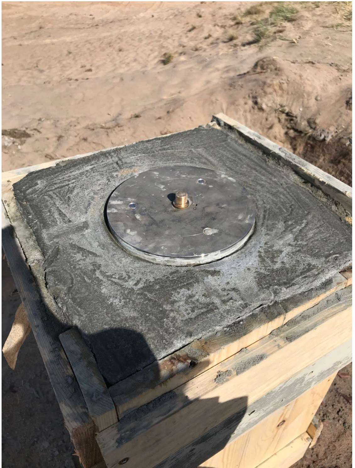
Рисунок 23 – Установка устройства принудительного центрирования
