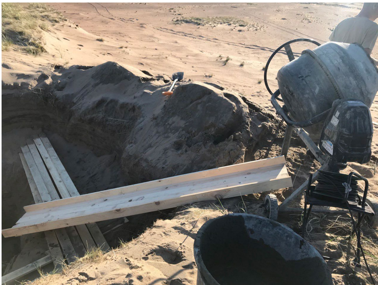
Рисунок 22 – Заливка якоря
