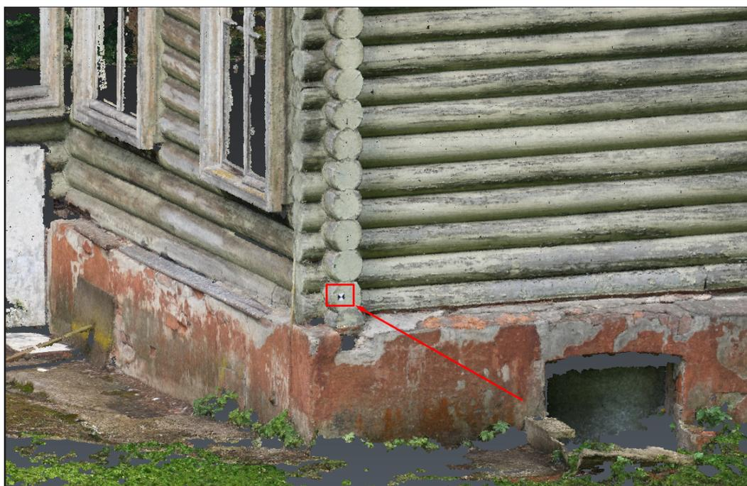
**Рис. 8:** Марка на облаке точек, полученным методом цифровой фотограмметрии
