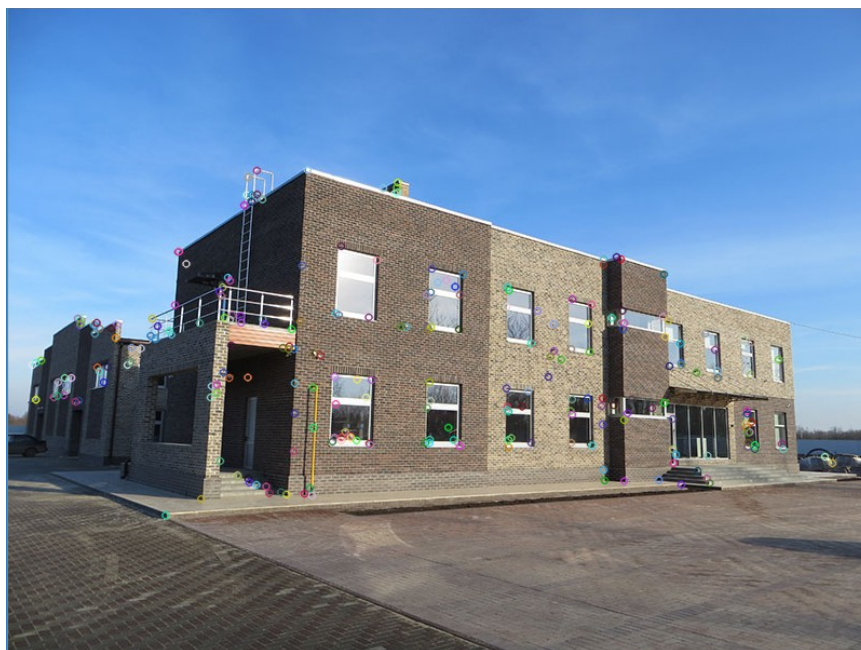
рис. 2.6.1. Особые точки, найденные методом BRISK на фотографии здания.
