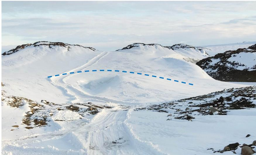
Рис. 3: Фотография дороги, соединяющей станцию и аэродром. Пунктиром обозначается место, где на радарограммах были обнаружены дифракции.
