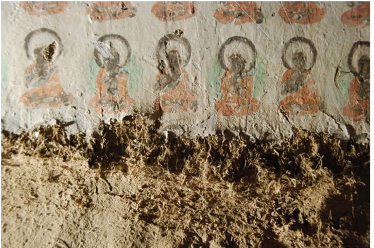
Рис. 1.1.11. Пещера Дунхуа. Китай. Разрушения, вызванные образованием солей на поверхности красочного слоя.
