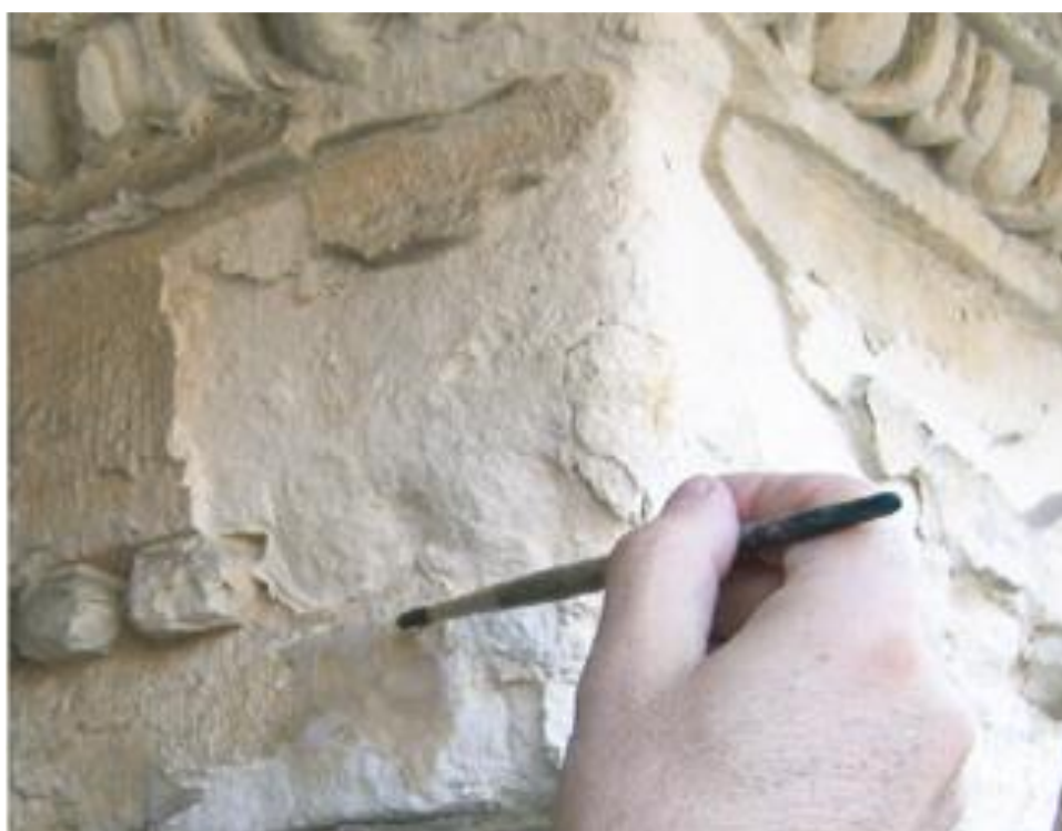
Рис.2.3.12. Нанесение укрепляющей нанодисперсии с помощью кисти. Ка' Гранда, Милан, Италия.
