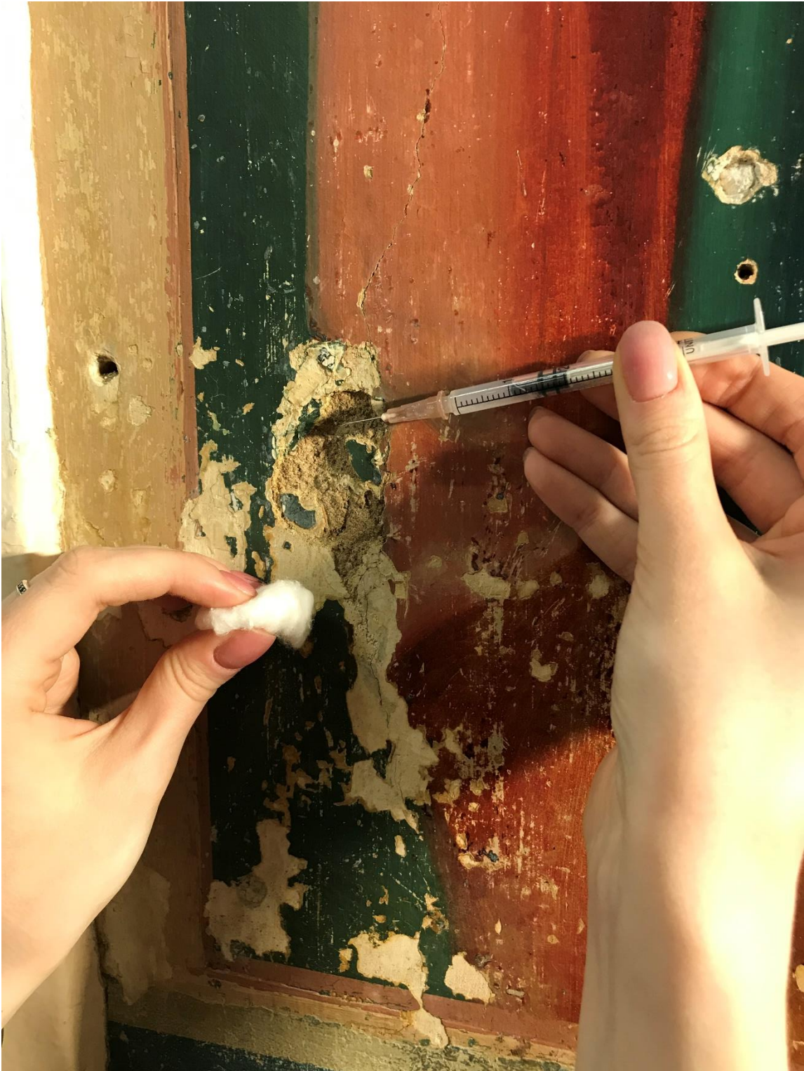
Рис. 3.3.4. В процессе укрепления области деструкции штукатурного слоя спиртовым раствором наноизвестки Nanorestore Plus® Ethanol 5.
