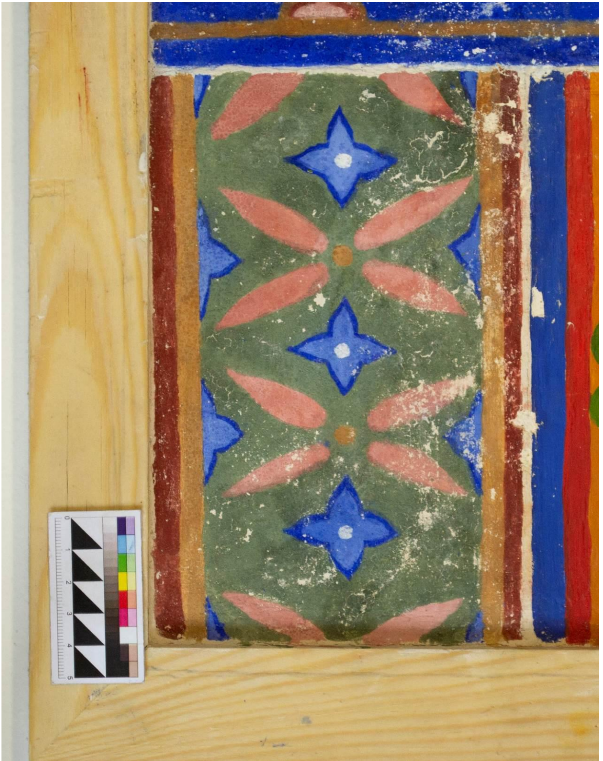
Рис. 3.2.29. После полного высыхания, после проведения процессов обессоливания и укрепления структуры живописи спиртовым раствором наноизвести Nanorestore Plus® Ethanol 5. Прямое освещение.
