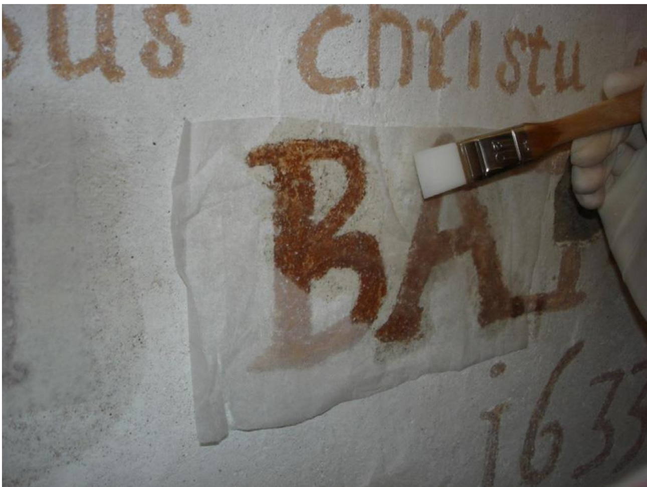
Рис.2.3.18. Применение дисперсии nanoизвести в спирте (2-пропаноле) кистью через лист японской бумаги на поверхности надписи.
