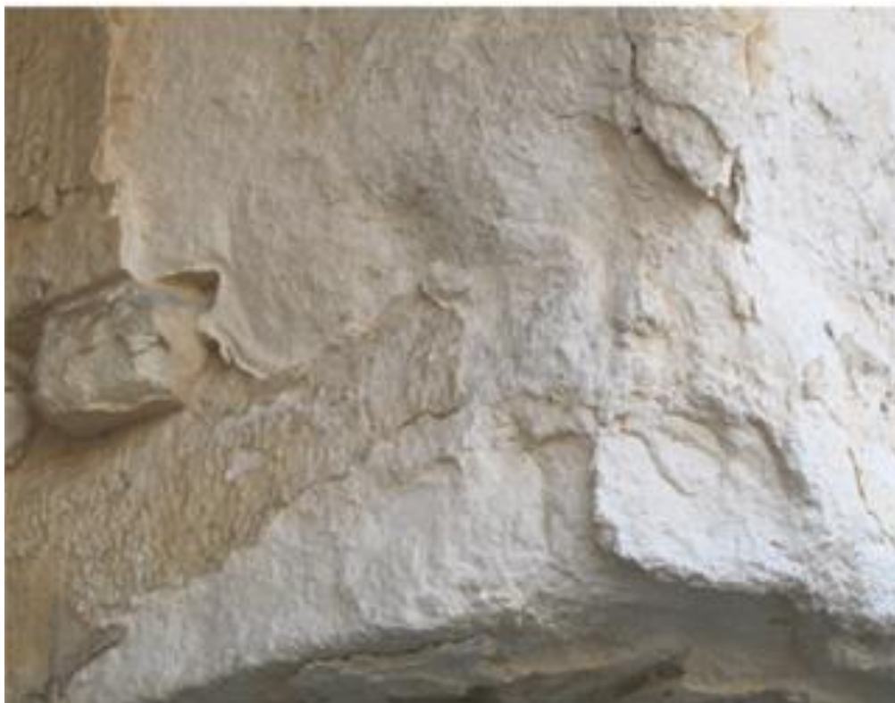
Рис.2.3.11. Необработанная и разрушающаяся часть камня Пьетра Д'Ангера в Ка' Гранда, Милан, Италия.
