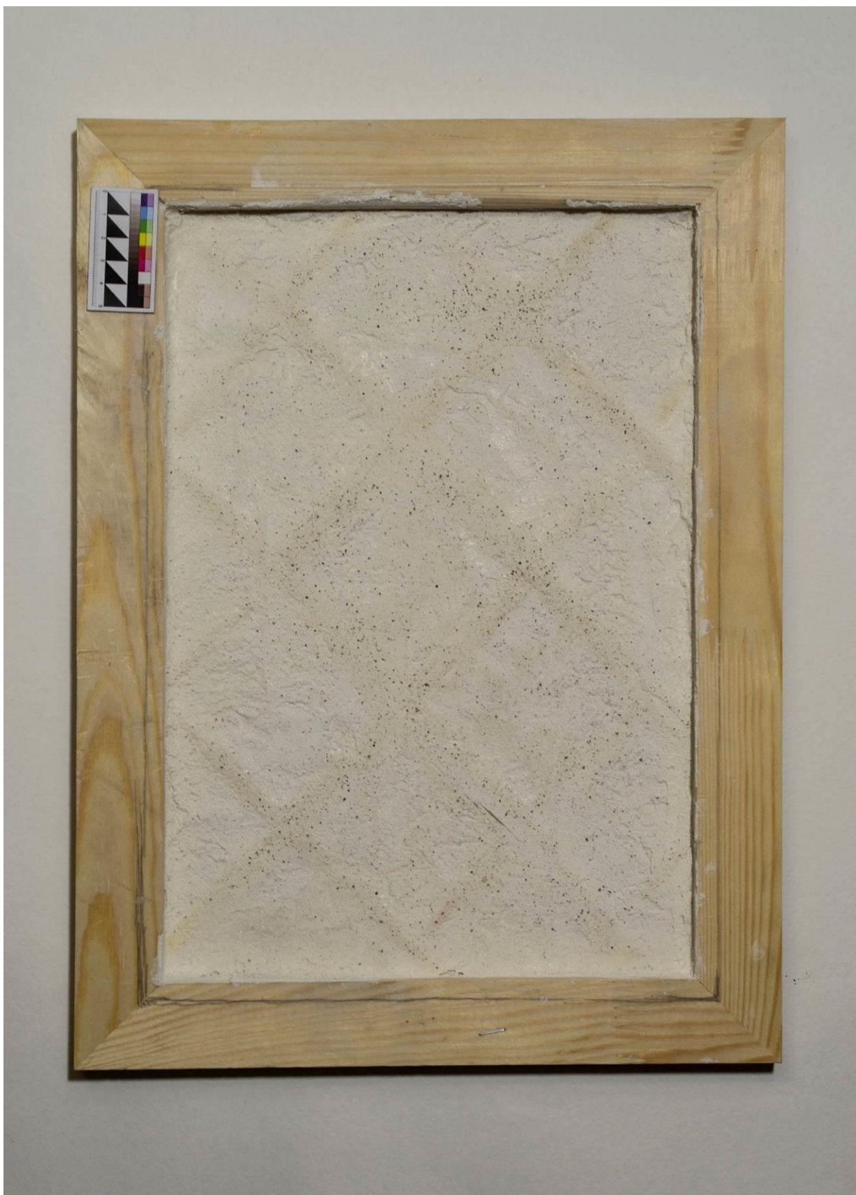
Рис. 3.2.3. Нанесен первый слой штукатурки с песком (набрызг). Прямое освещение
