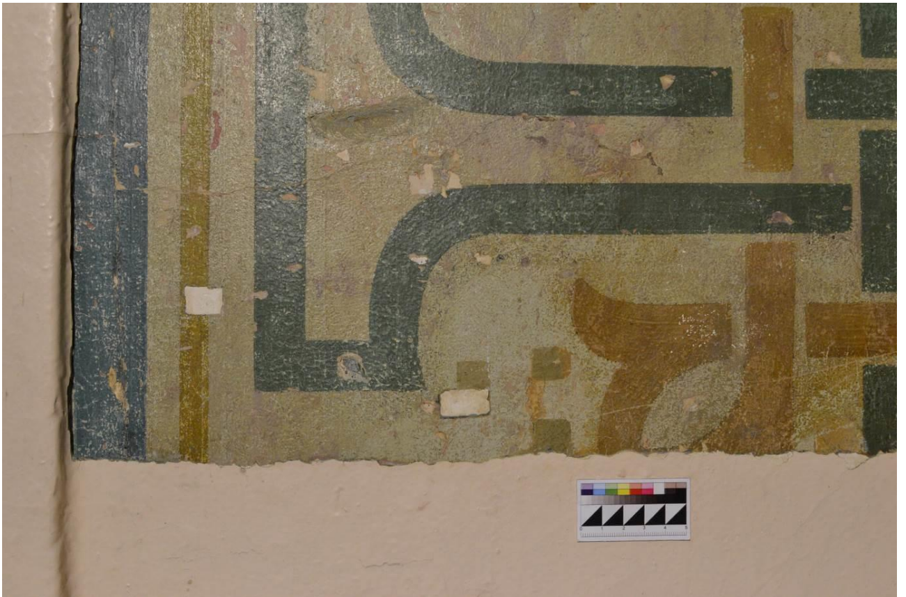
Рис. 1.1.17. Фрагмент живописи в храме Благовещения Пресвятой Богородицы г. Санкт – Петербург. В верхней части видна вмятина, предположительно от сильного механического воздействия.
