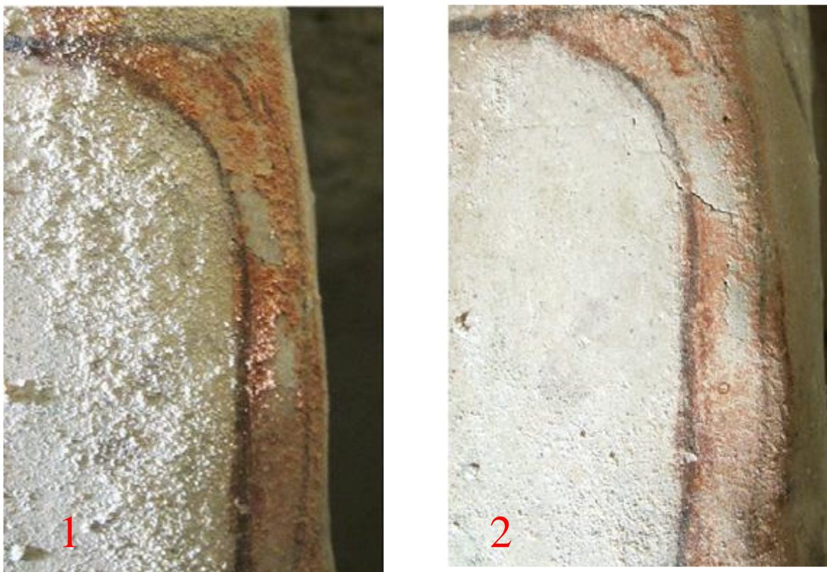
Рис.2.3.5. 1). Фото фрагмента в боковом свете. Образование соли на поверхности привело к осыпанию красочного слоя и потере пигмента.
