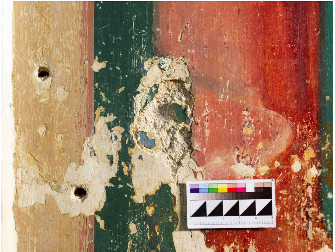
Рис. 3.3.5. После укрепления деструкции штукатурного слоя спиртовым раствором наноизвестки Nanorestore Plus® Ethanol 5.
