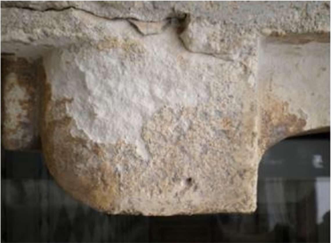
Рис.2.3.7. Типичные разрушения Пьетра д'Анжера. Видны утраты.
