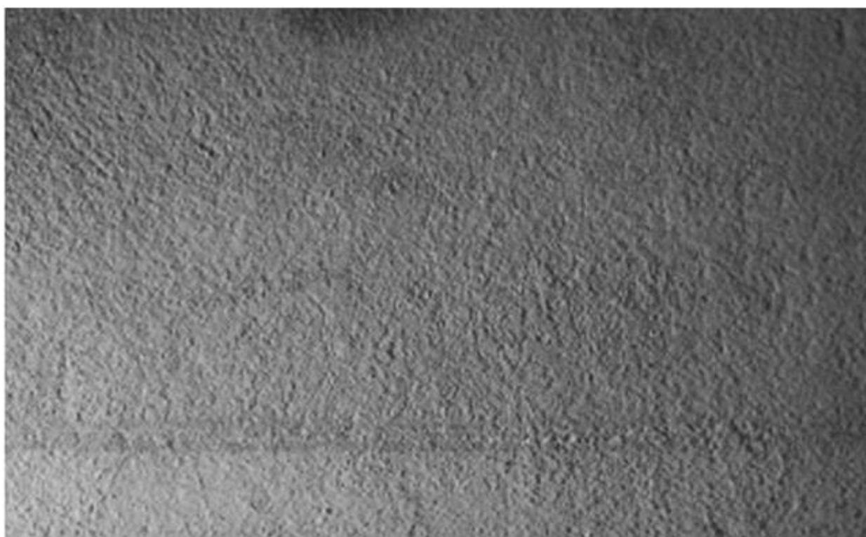
Рис.2.3.27. Фрагмент 2 разрушенной области стены в католическом монастыре Святых Джуда и Симоне Клоистера («SS. Giuda and Simone Cloister») после укрепления.
