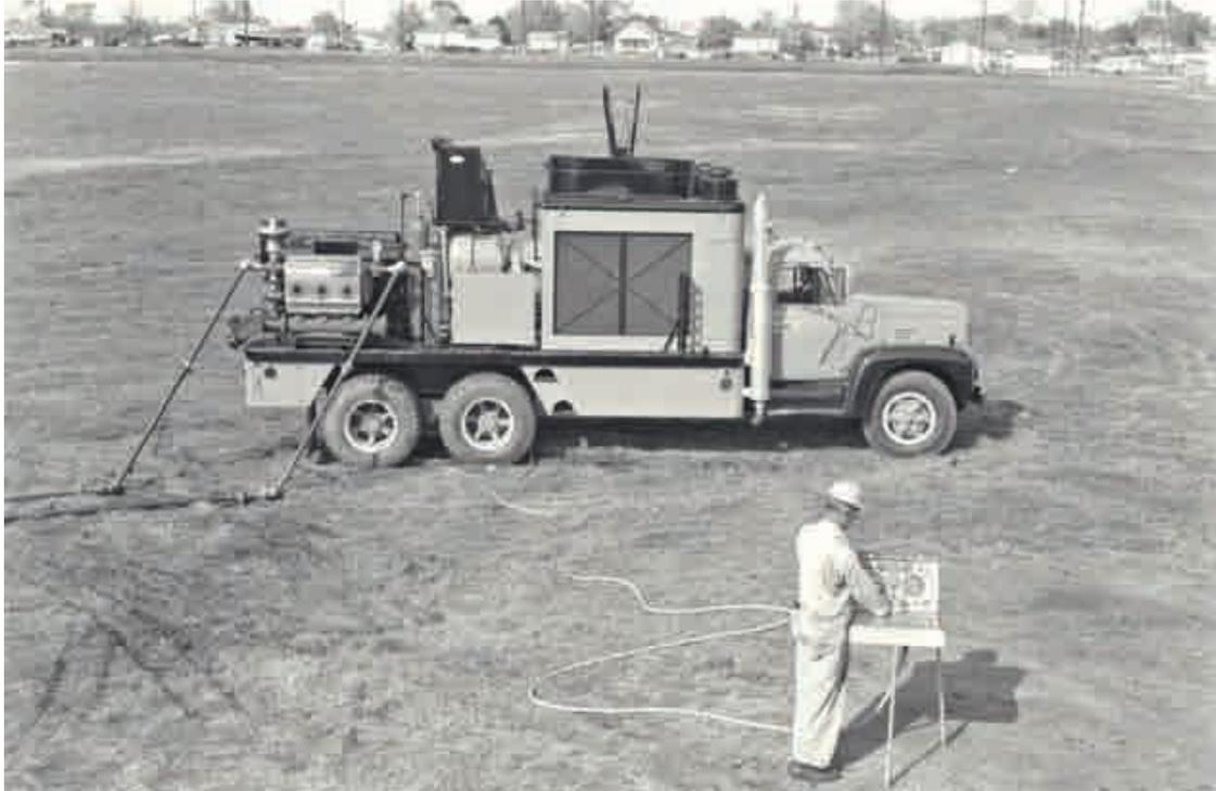
Рисунок 2.3. Машина откачки/миксер для ГРП [9]
