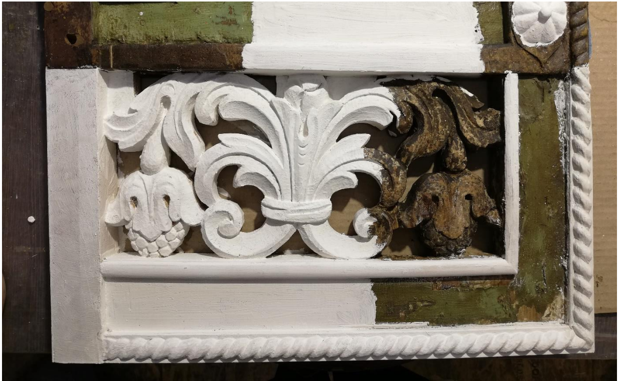
Рис. 22 Правая створка царских врат иконостаса Успенского собора г. Кемь. Фрагмент нижней секции. Подведен левкас в новодельных вставках. В процессе реставрации
