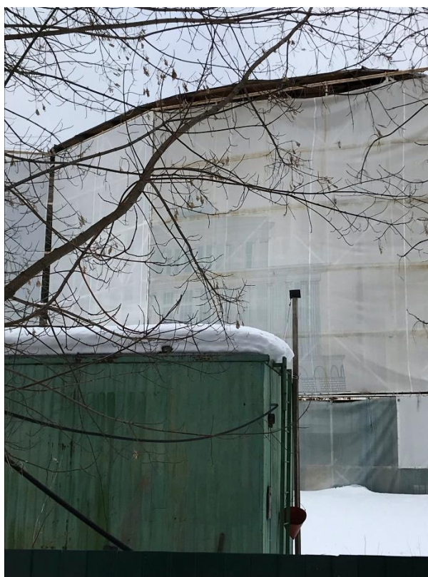
Фото 4. На строительной сетке заметны прежние очертания ансамбля Речного вокзала
