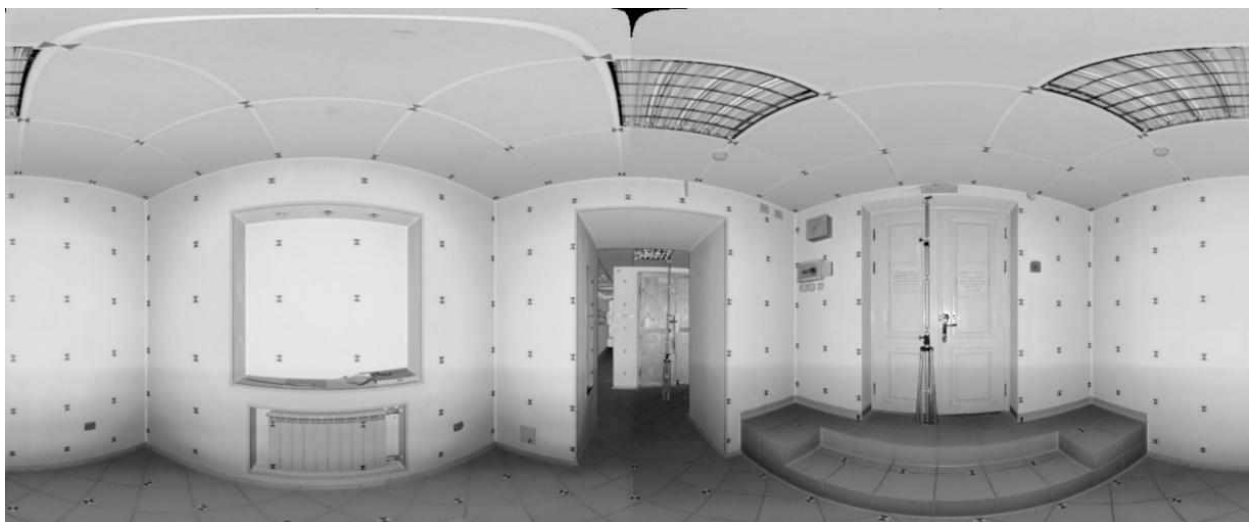
Рисунок 28. Развёртка скана 360^\circ на 180^\circ при разрешении 1/2 , выполненный лазерным сканером Faro Focus 3D X330 .
