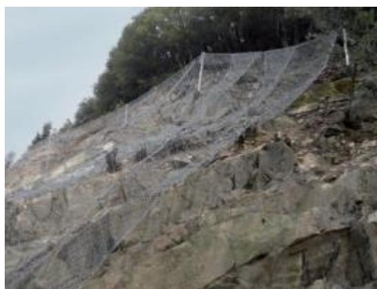
Рисунок 34 -Ряд гибридных барьеров. Установка одной линии гибридных барьеров с длинным шлейфом.
