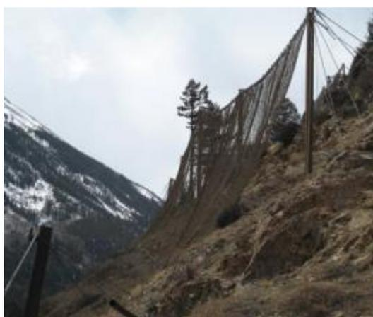
Рисунок 35 - Система гашения. Установка каскада гибридных барьеров с коротким шлейфом.
