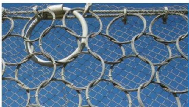
Рисунок 31 - Амортизирующий элемент на натяжном канате
