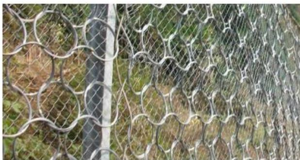
Рисунок 30 - Высокочечная стальная сеть в сочетании с мелкозернистой сетью, позволяющей сдерживать обломки породы мелкого диаметра
