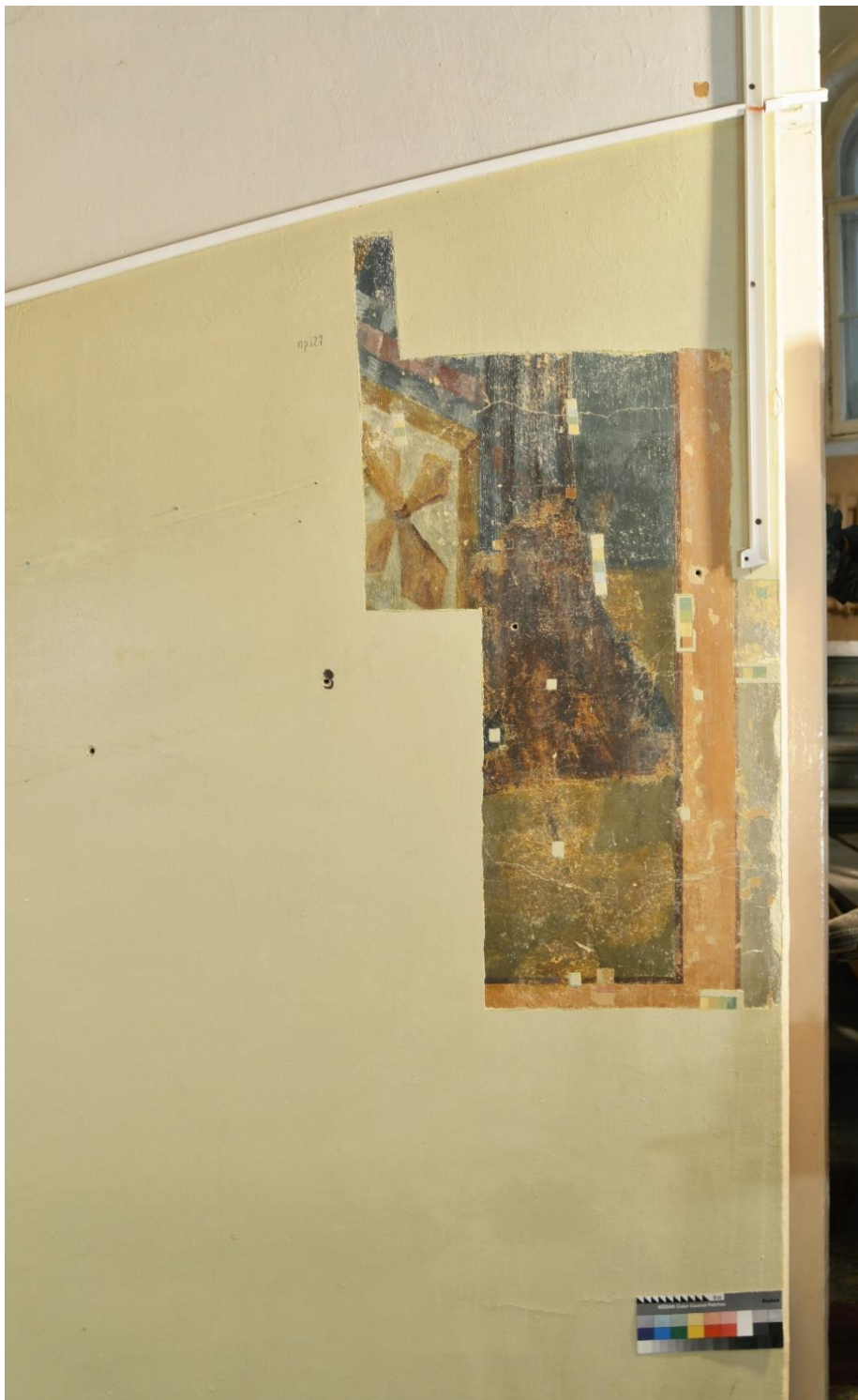
2.33 Фрагмент №5 арки. В процессе удаления поздних малярных поновлений. Прямое освещение
