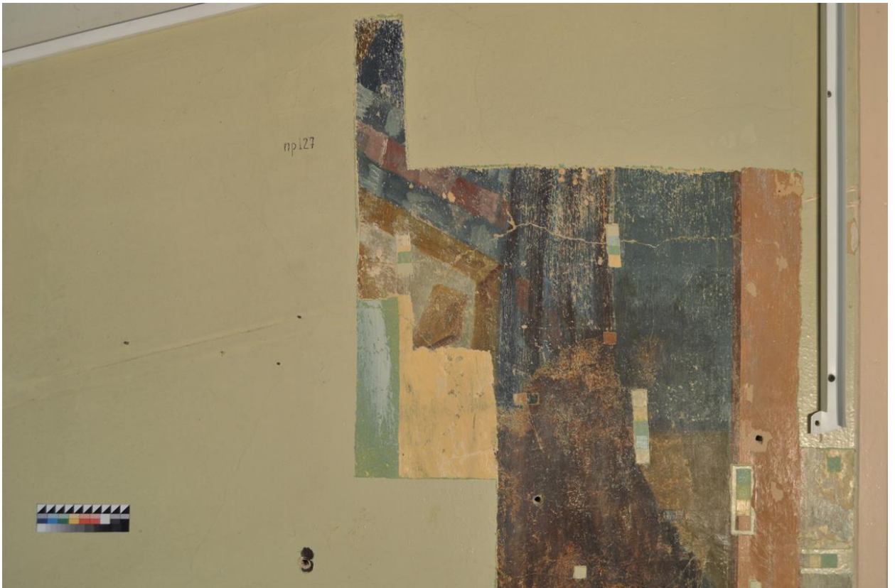
2.21 Фрагмент №4 арки. В процессе удаления поздних малярных поновлений. Прямое освещение
