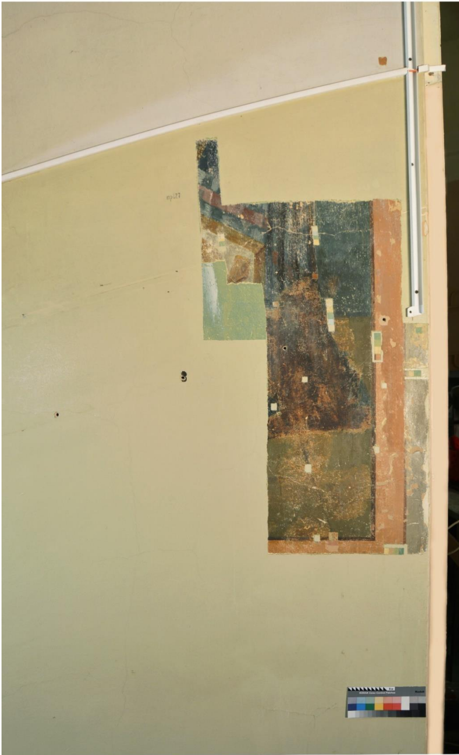
2.31 Фрагмент №5 арки. В процессе удаления поздних малярных поновлений. Прямое освещение
