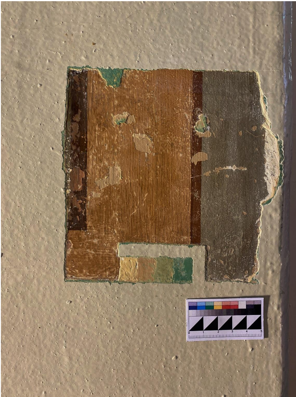
2.48 Фрагмент реставрируемого участка арки. В процессе удаления поздних малярных поновлений. Прямое освещение
