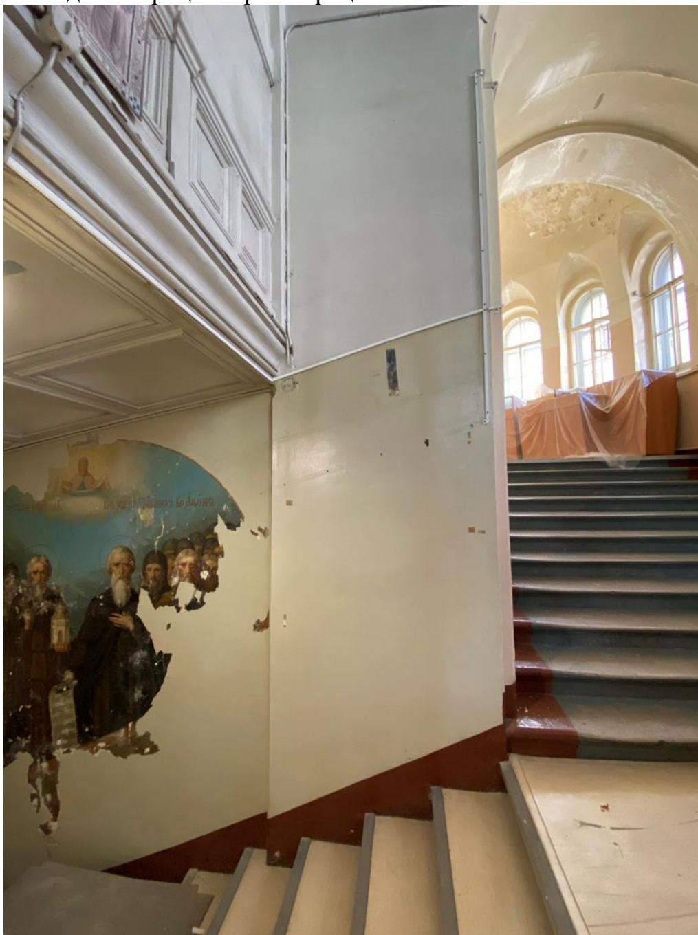
2.1 Общий вид арочного проема
