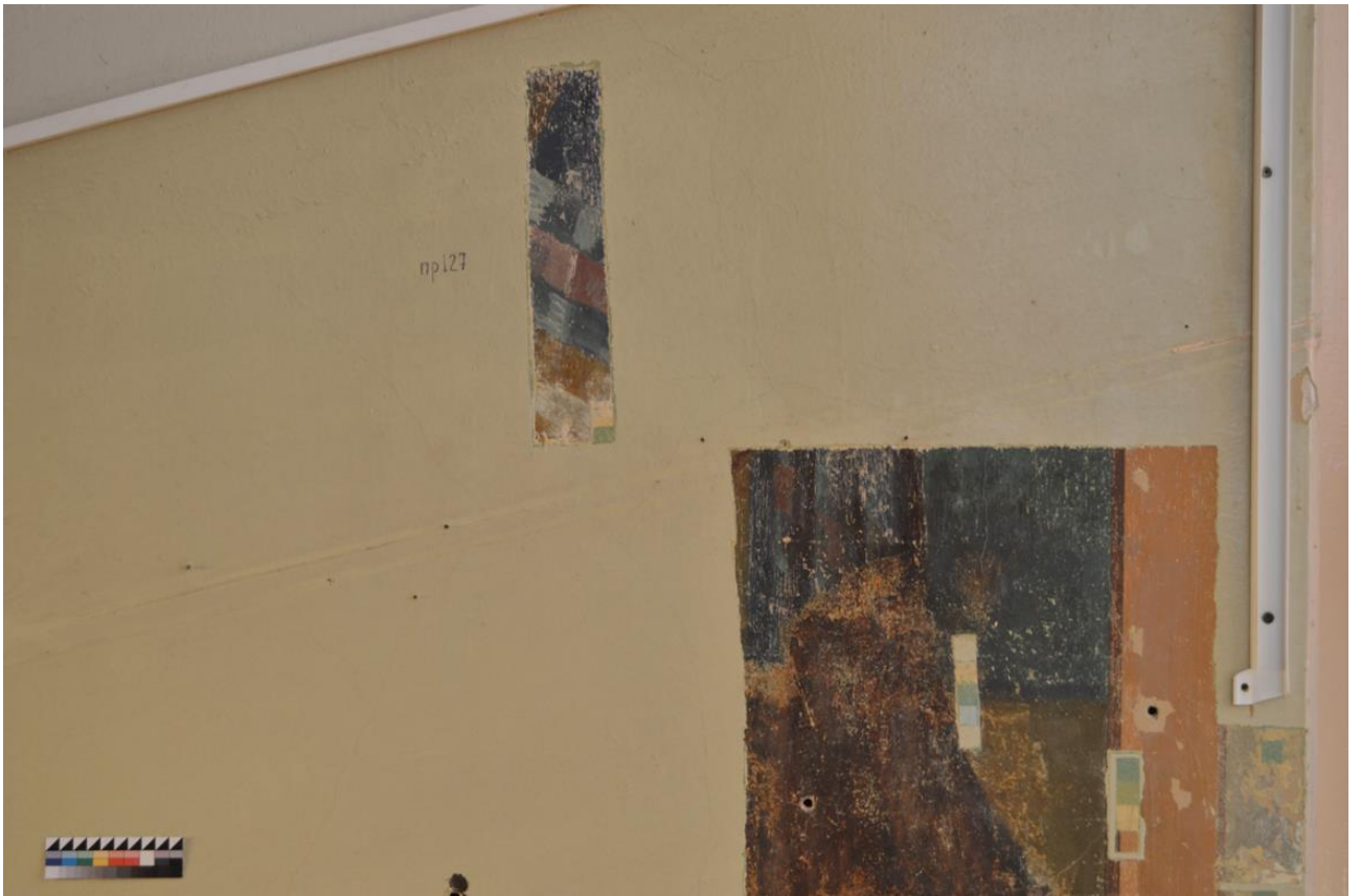
2.18 Фрагмент №4 арки. В процессе удаления поздних малярных поновлений. Прямое освещение
