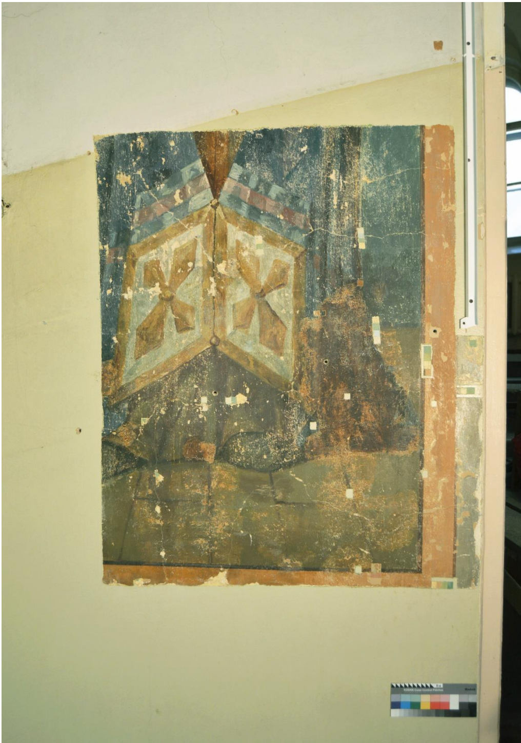
2.39 Фрагмент №5 арки. В процессе удаления поздних малярных поновлений. Прямое освещение
