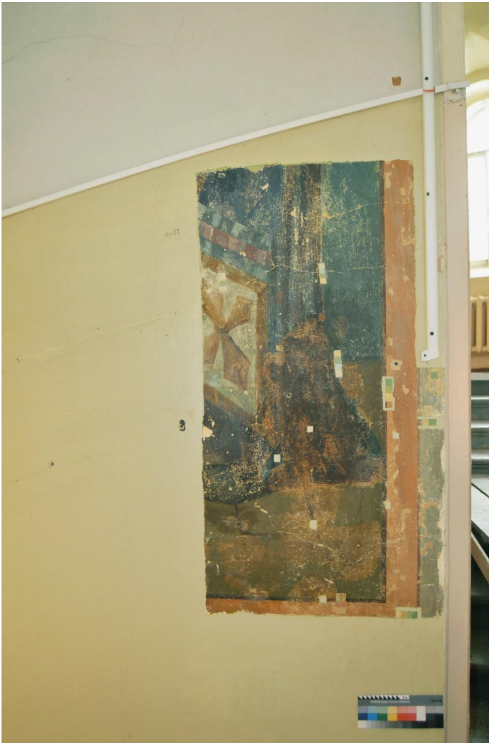
2.36 Фрагмент №5 арки. В процессе удаления поздних малярных поновлений. Прямое освещение
