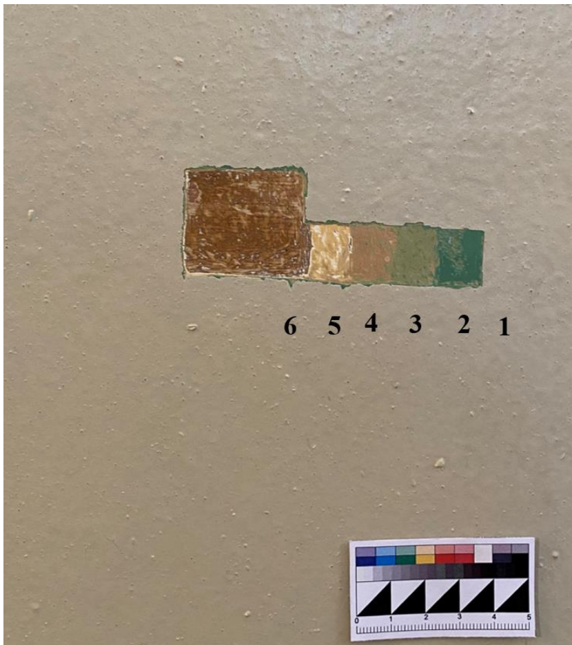
1.3 Исследование в виде послойной расчистки с указанием количества слоев на поверхности позднего живописного поновления
