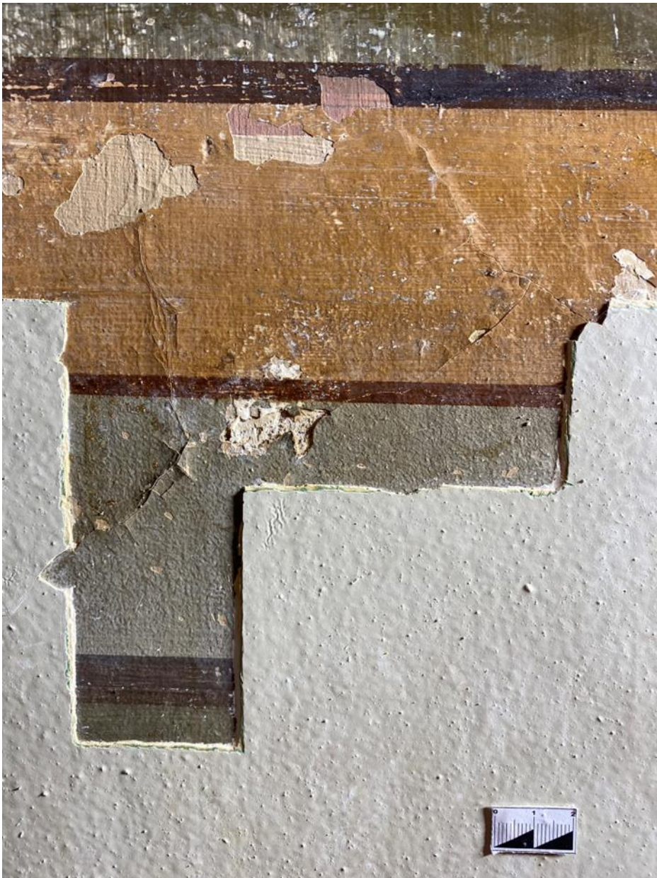
3.5 Фрагмент верхней части арочного проема в процессе реставрации до укрепления отставаний красочного слоя. Боковое освещение.
