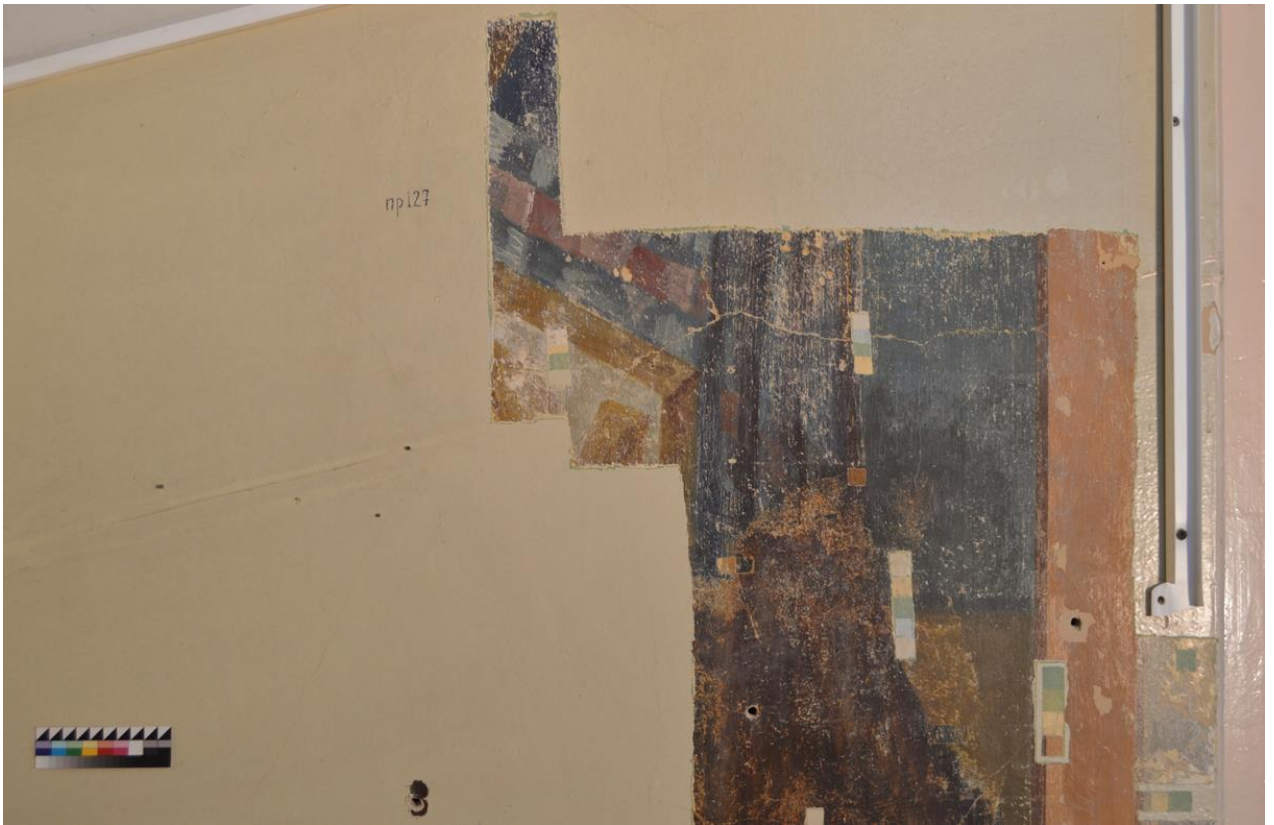
2.19 Фрагмент №4 арки. В процессе удаления поздних малярных поновлений. Прямое освещение
