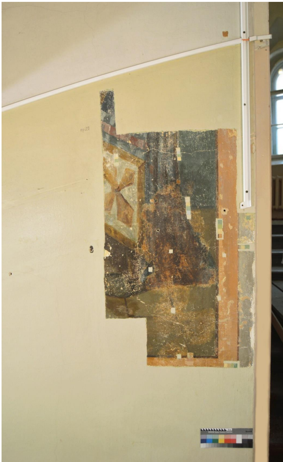
2.34 Фрагмент №5 арки. В процессе удаления поздних малярных поновлений. Прямое освещение
