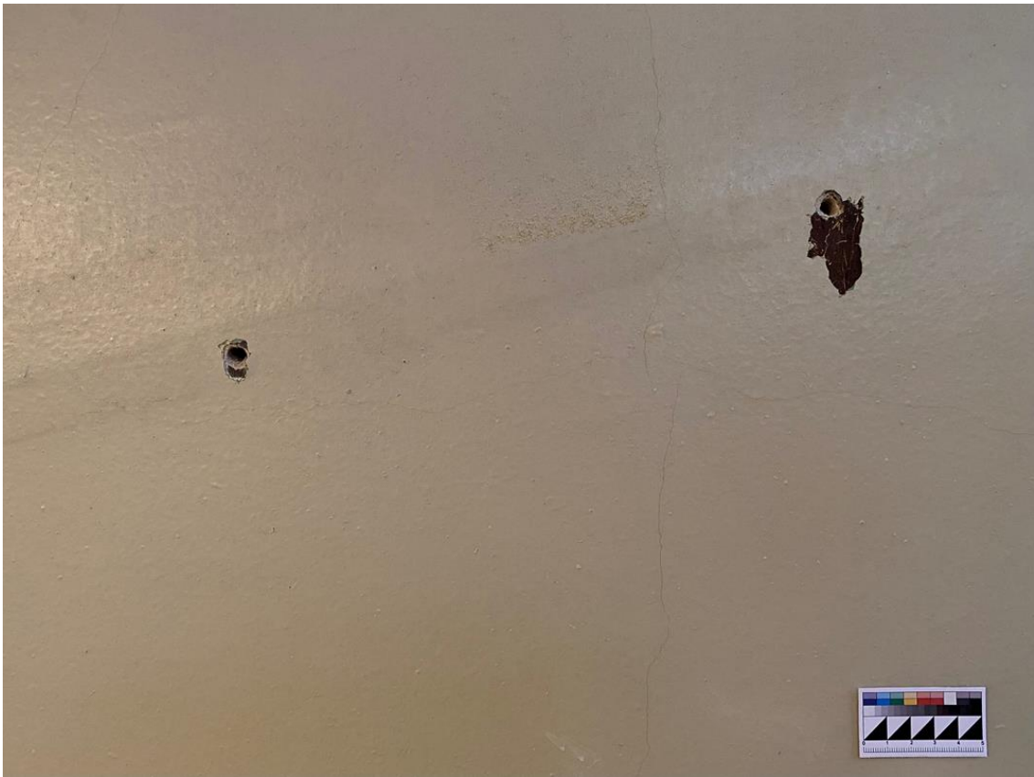
2.8 Фрагмент арки с утратами до основы в виде отверстий. Прямое освещение
