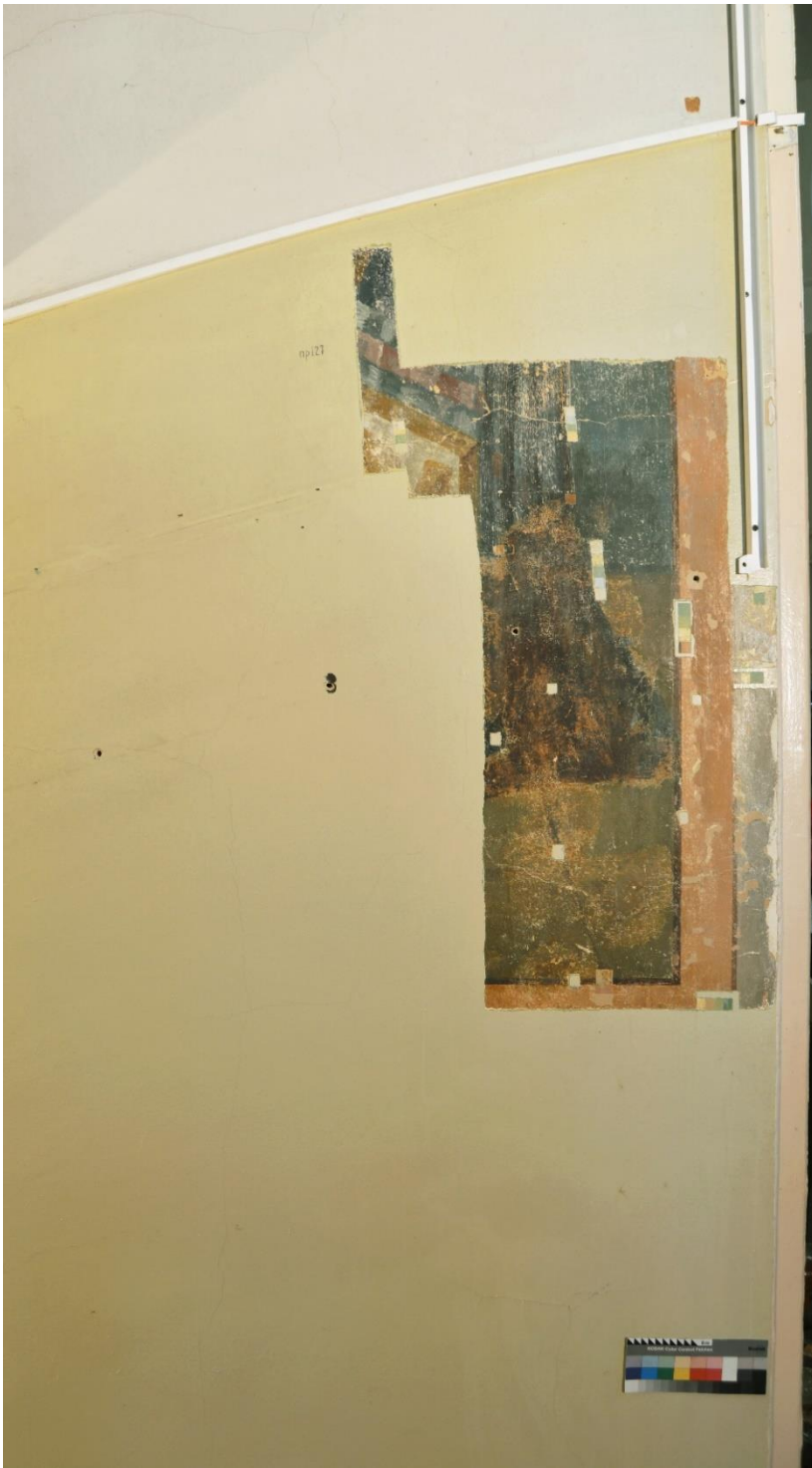
2.30 Фрагмент №5 арки. В процессе удаления поздних малярных поновлений. Прямое освещение
