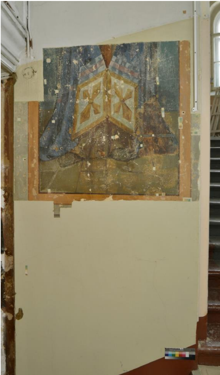
2.59 Общий вид арки после реставрации. Прямое освещение
