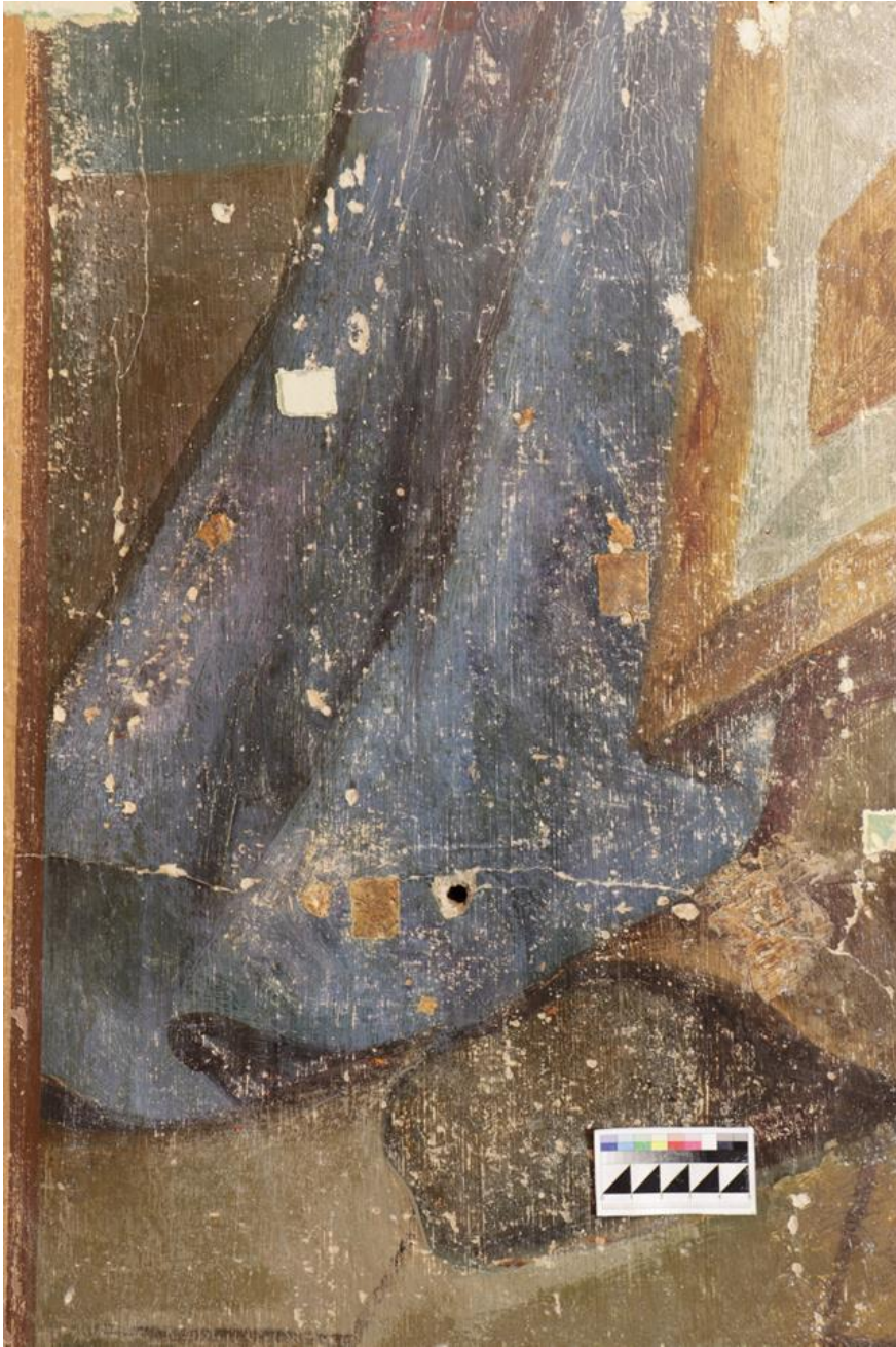
2.52 Фрагмент реставрируемого участка арки. После удаления бежевой шпаклевки с поверхности авторского красочного слоя. Прямое освещение
