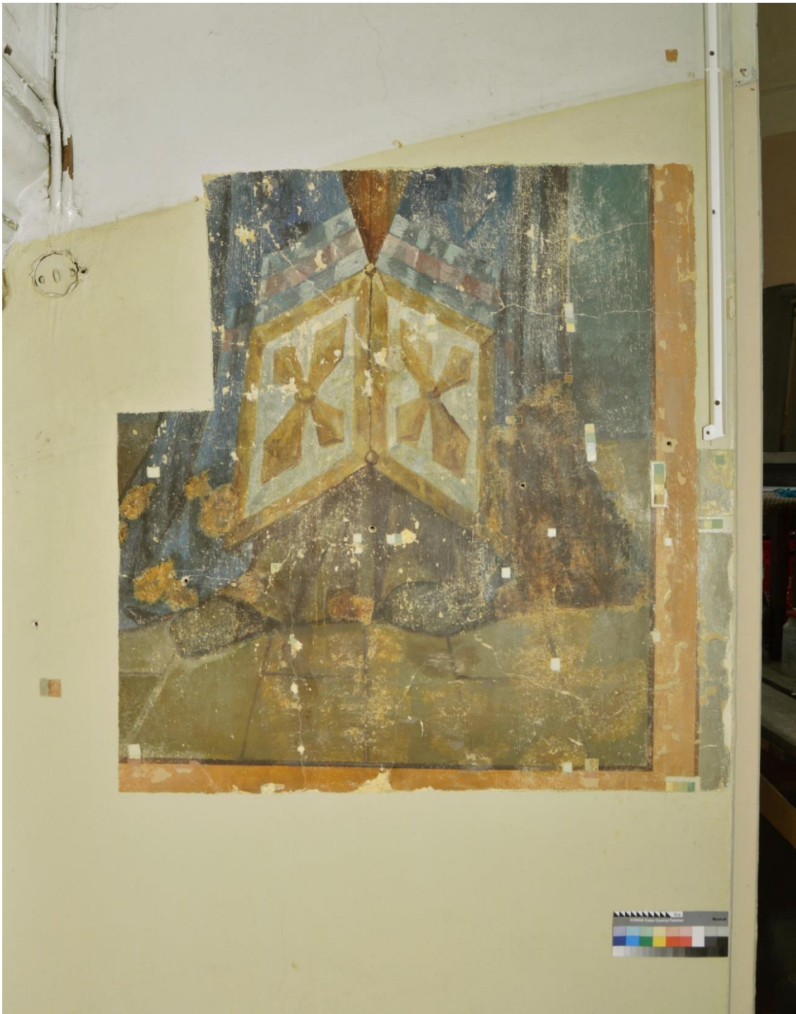
2.40 Фрагмент №5 арки. В процессе удаления поздних малярных поновлений. Прямое освещение
