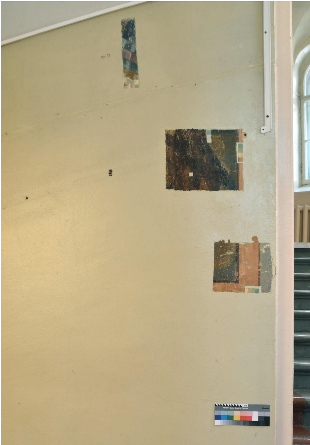
2.26 Фрагмент №5 арки. В процессе удаления поздних малярных поновлений. Прямое освещение
