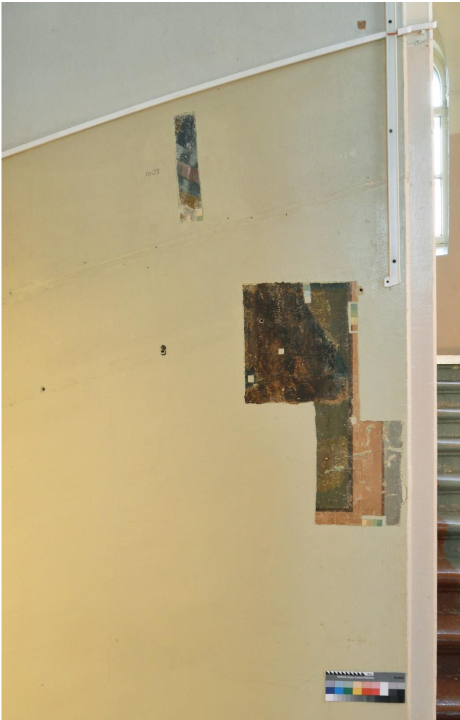
2.27 Фрагмент №5 арки. В процессе удаления поздних малярных поновлений. Прямое освещение
