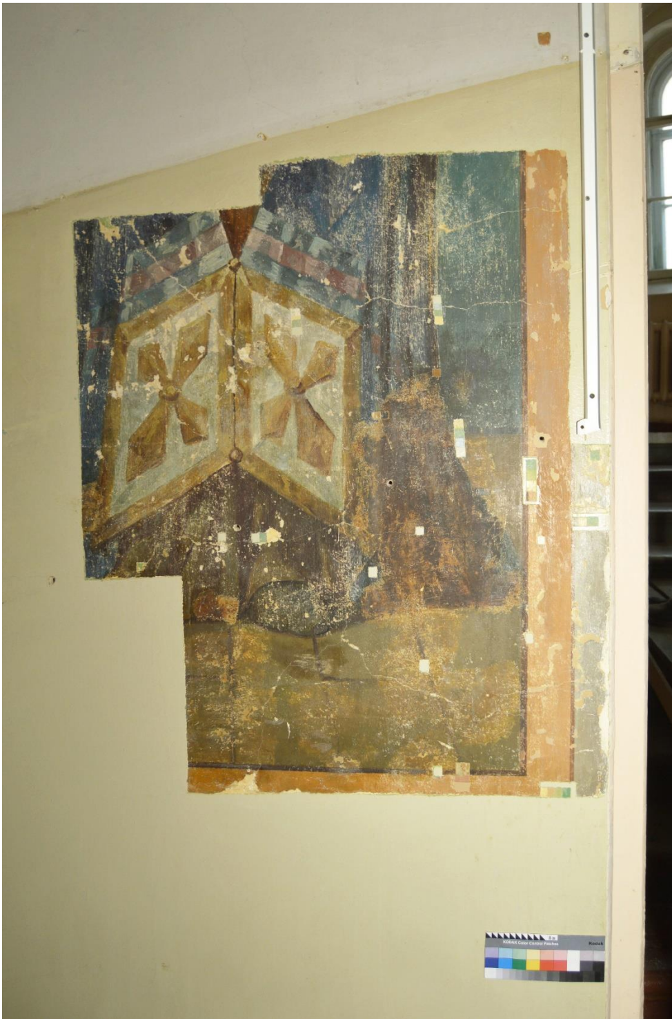
2.38 Фрагмент №5 арки. В процессе удаления поздних малярных поновлений. Прямое освещение
