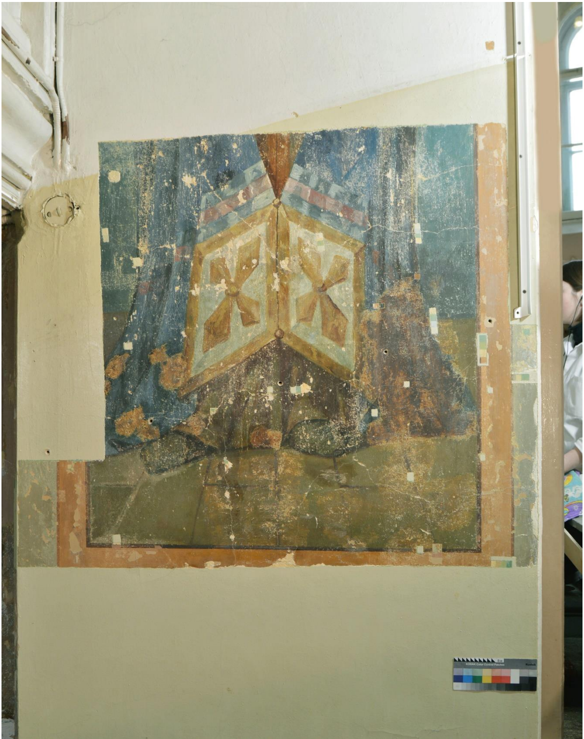
2.42 Фрагмент №5 арки. В процессе удаления поздних малярных поновлений. Прямое освещение
