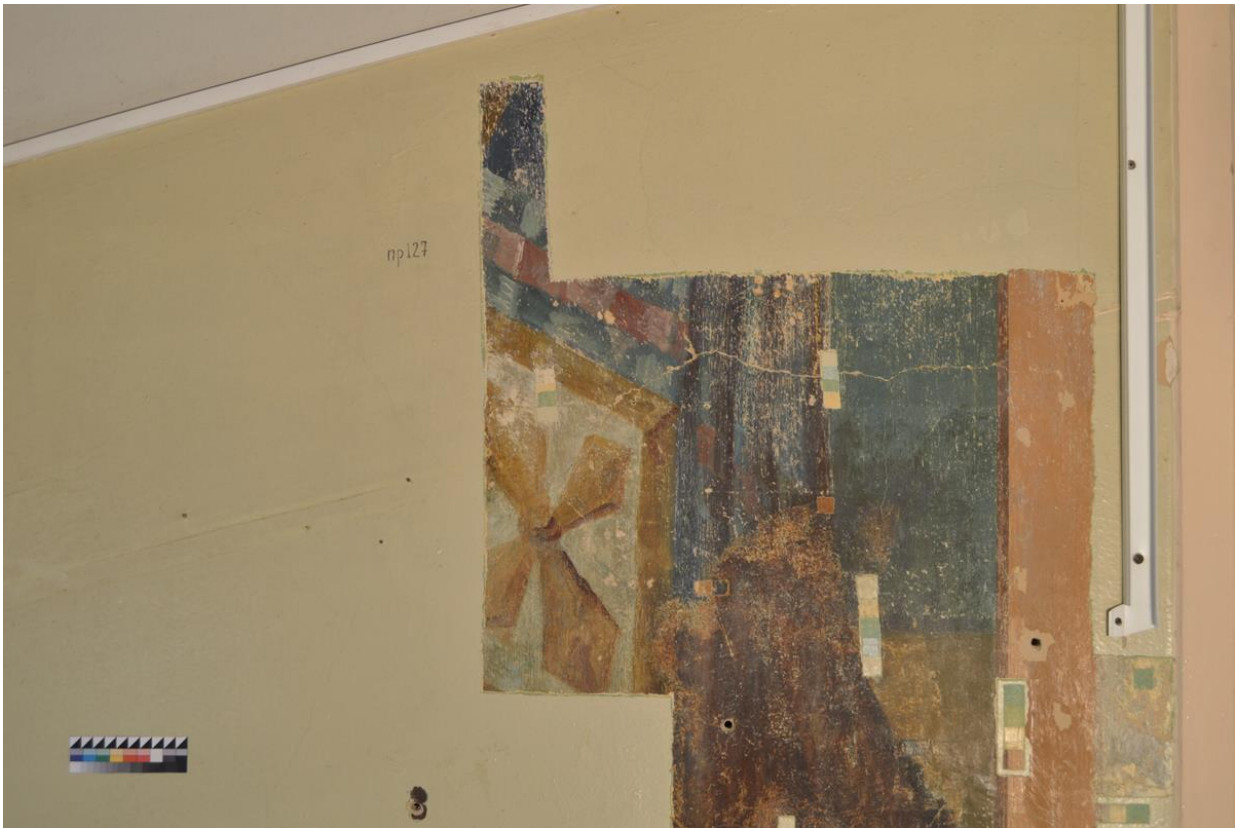
2.22 Фрагмент №4 арки. В процессе удаления поздних малярных поновлений. Прямое освещение
