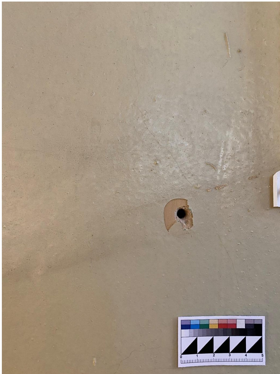
2.7 Фрагмент арки с утратами основы в виде отверстий. Прямое освещение
