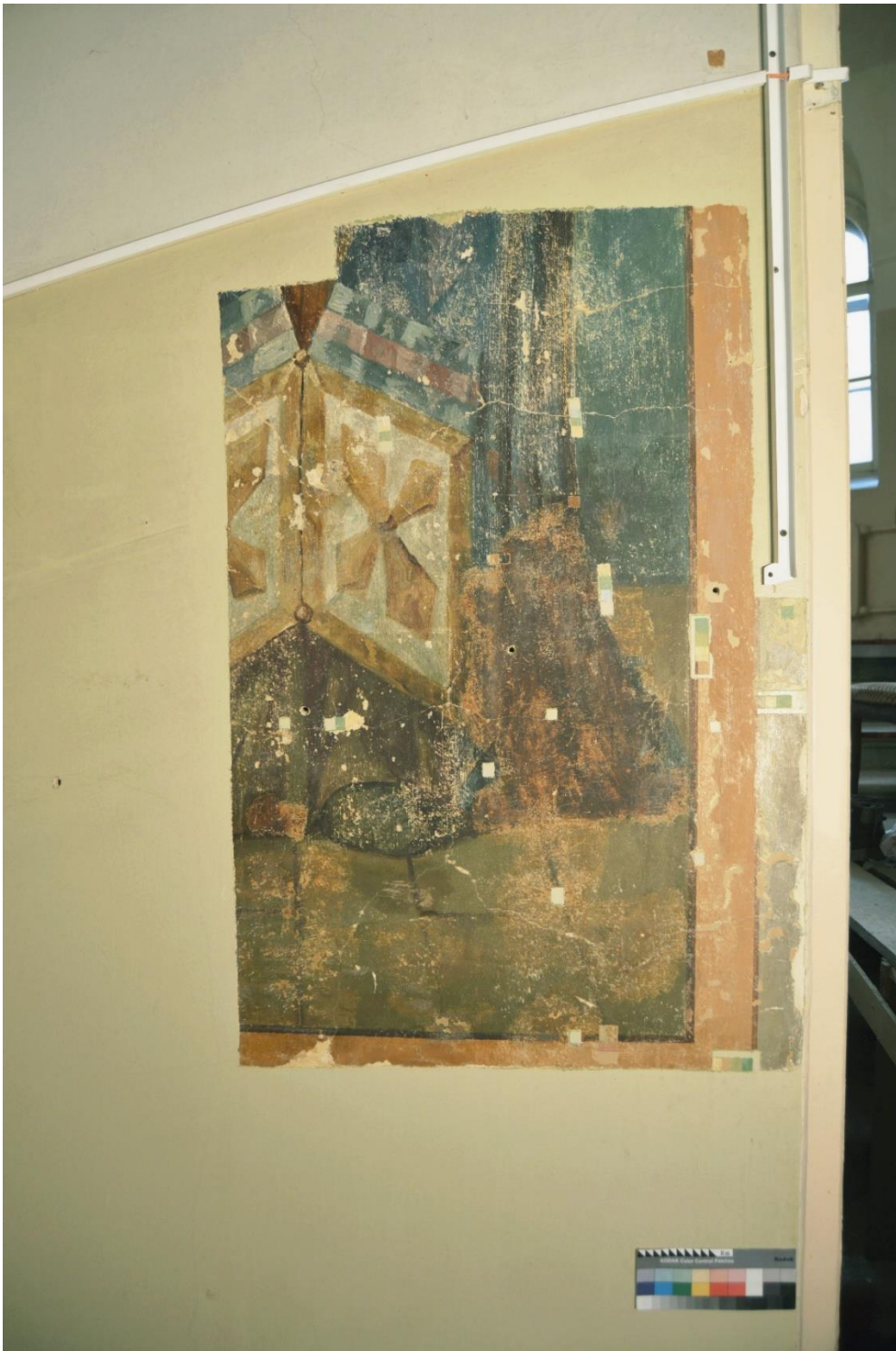
2.37 Фрагмент №5 арки. В процессе удаления поздних малярных поновлений. Прямое освещение
