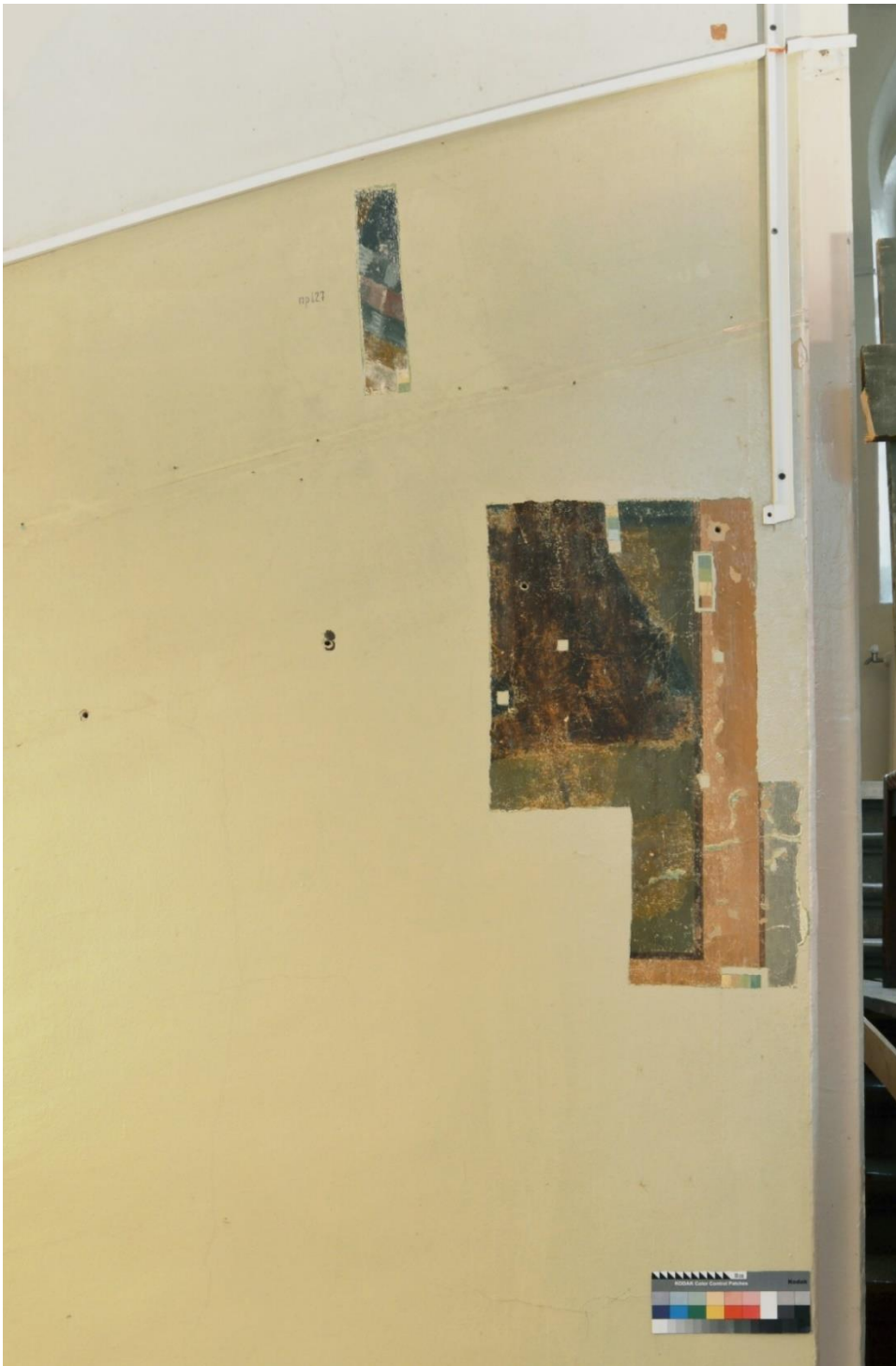
2.28 Фрагмент №5 арки. В процессе удаления поздних малярных поновлений. Прямое освещение
