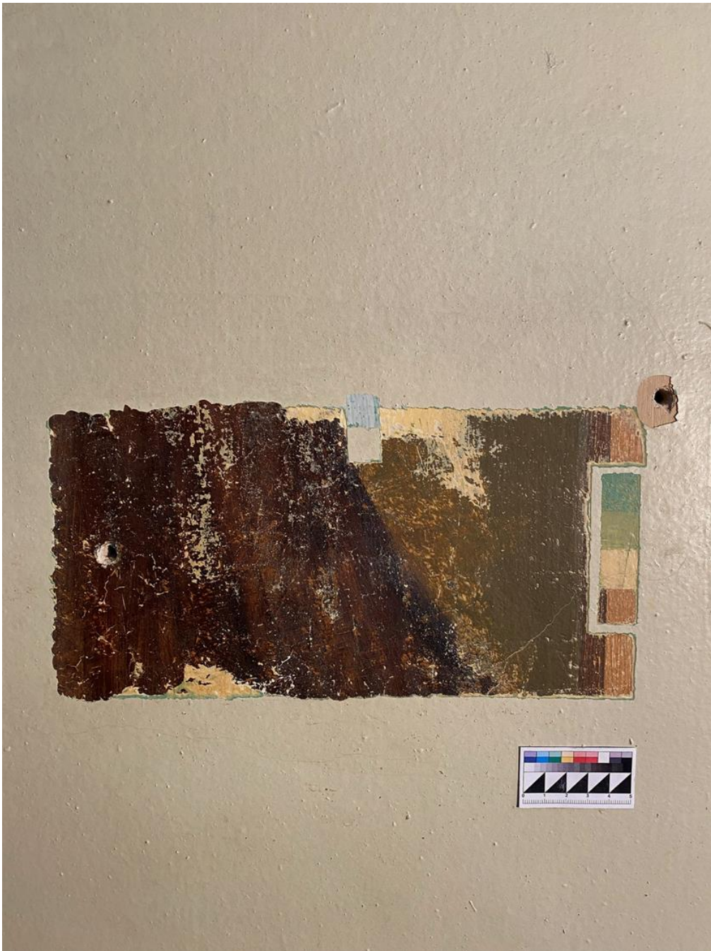
2.50 Фрагмент реставрируемого участка арки. В процессе удаления поздних малярных поновлений. Прямое освещение
