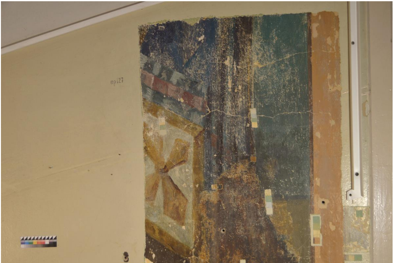
2.23 Фрагмент №4 арки. В процессе удаления поздних малярных поновлений. Прямое освещение
