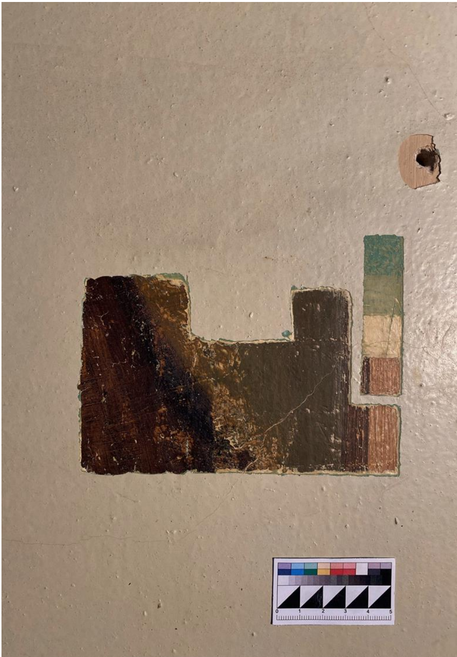
2.49 Фрагмент реставрируемого участка арки. В процессе удаления поздних малярных поновлений. Прямое освещение
