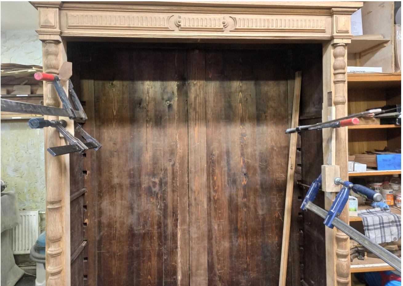
Фото №32: Проклейка фанеровки в местах отхода от основы фасадной стороны.
