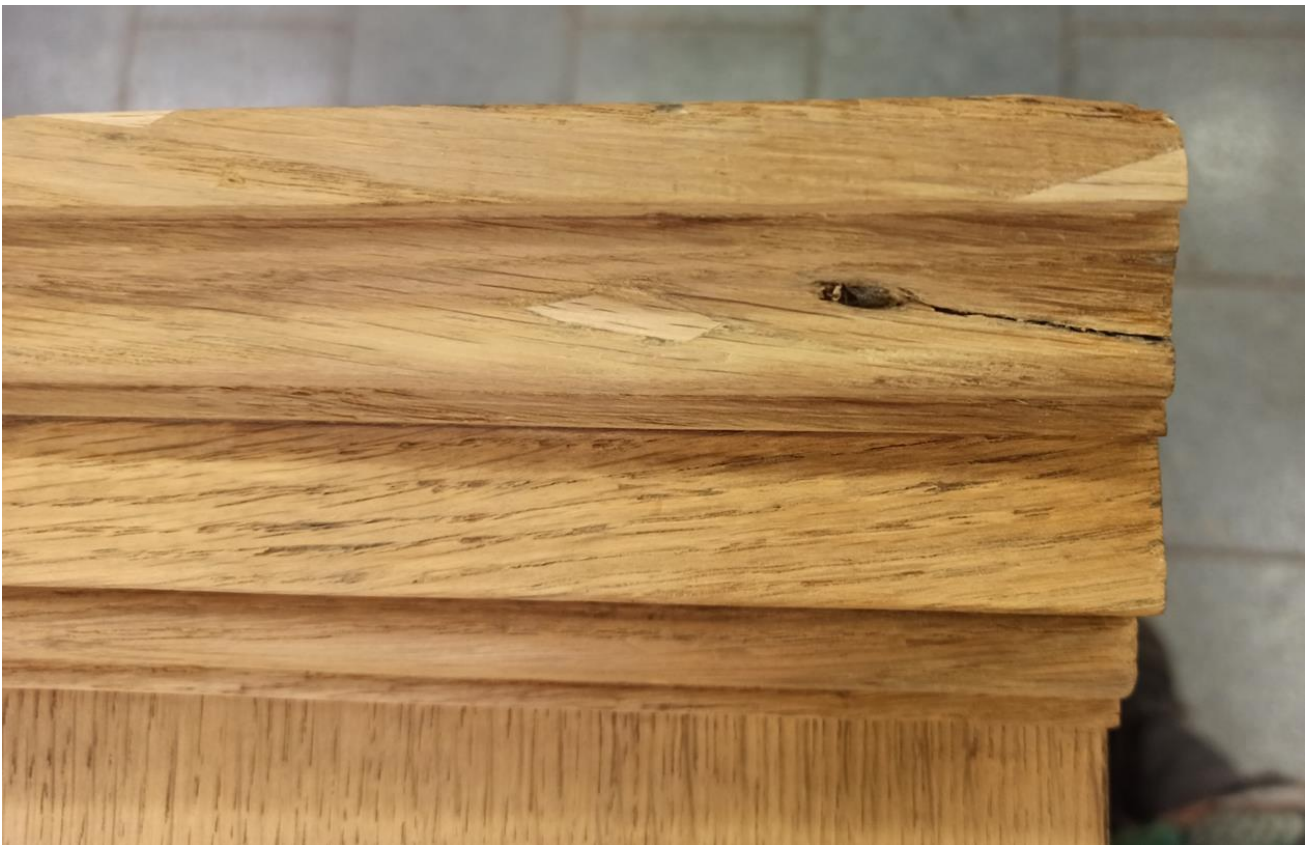
Фото №38: Изготовление вставки в места утрат массива карниза.
