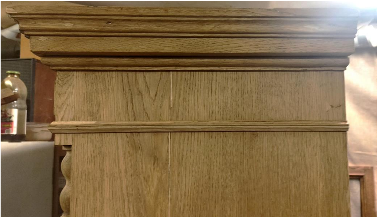
Фото №43: Изготовление и установка утерянного профиля правой боковой стенки
