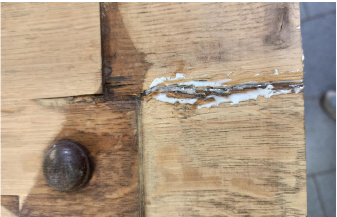
Фото №64: Процесс зареивания филенок дверей.
