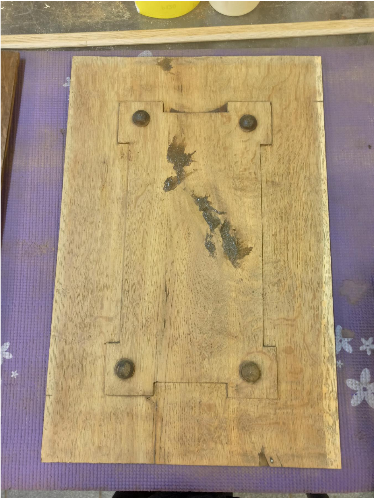
Фото №65: Процесс шпаклевки филенок дверей.
