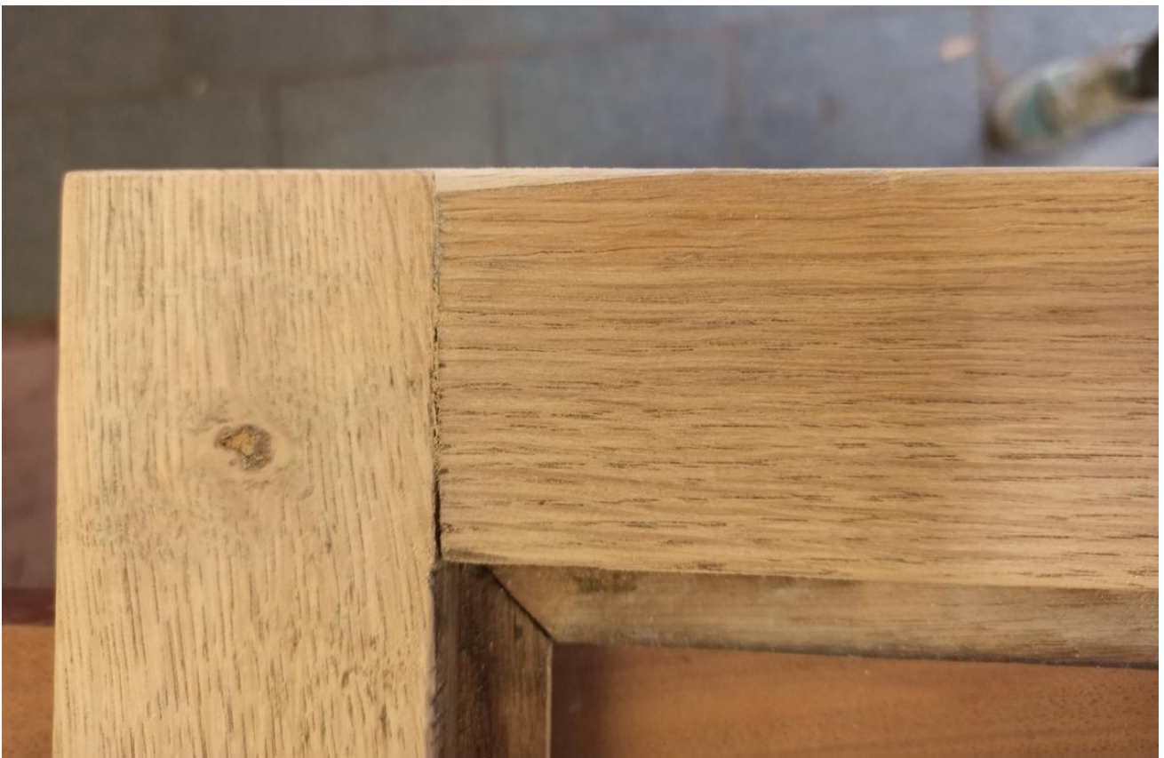
Фото №55: Изготовление вставки в место утраты фанеровки левой дверцы.
