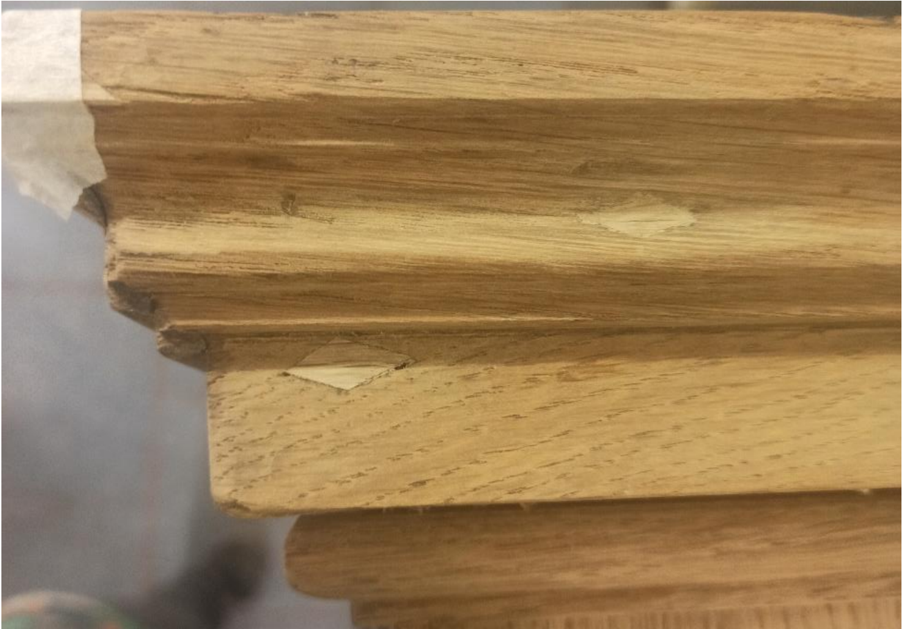
Фото №37: Изготовление вставки в места утрат массива карниза.
