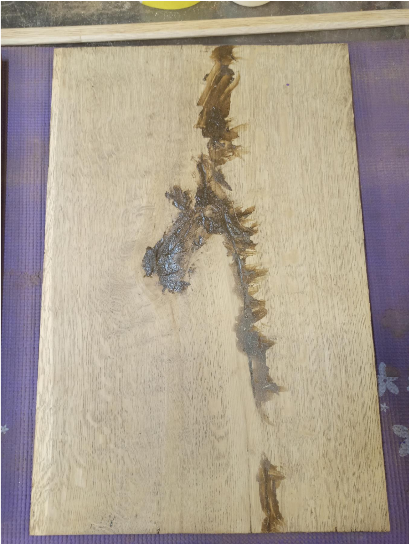
Фото №66: Процесс шпаклевки филенок дверей.
