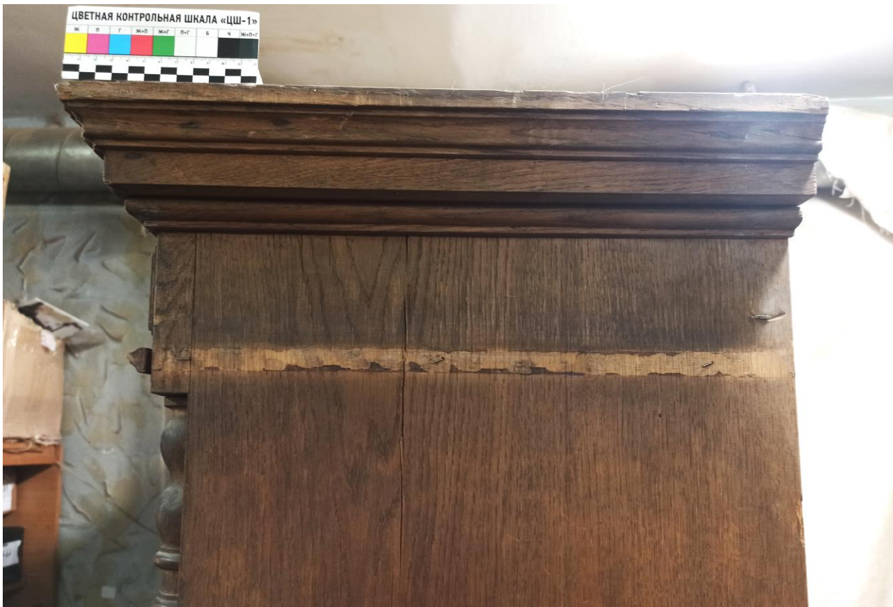
Фото №18: Сколы, выбоины, утраты массива правого карниза. Утрата профиля.
