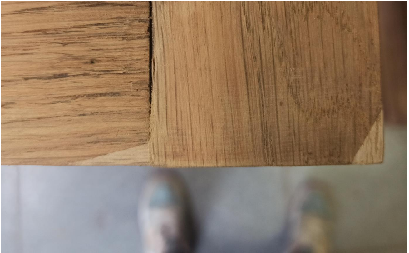
Фото №54: Изготовление вставок в места утрат фанеровки угла левой дверцы.
