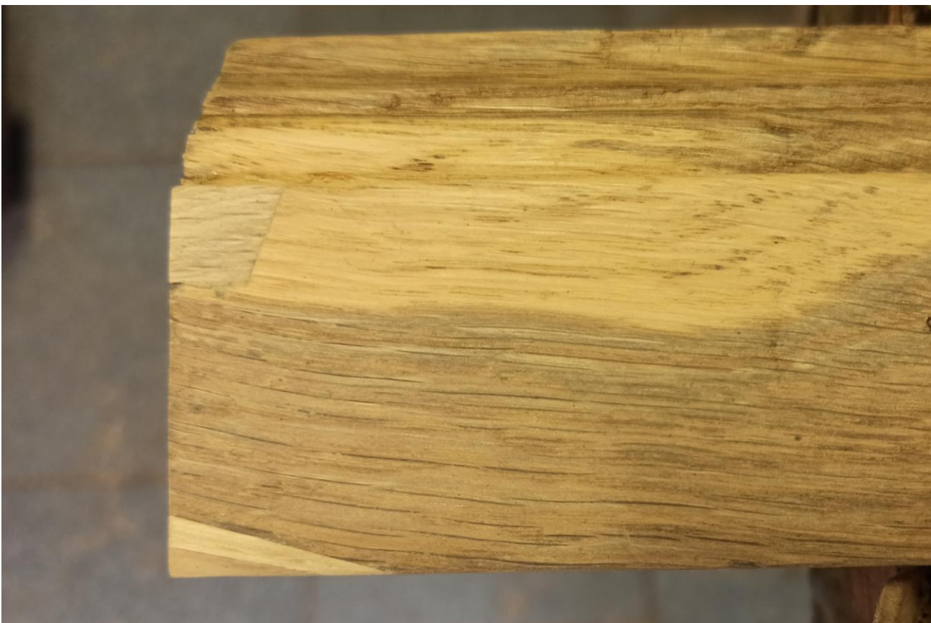
Фото №46: Изготовление вставок в места утрат массива плинта левой боковой стенки.
