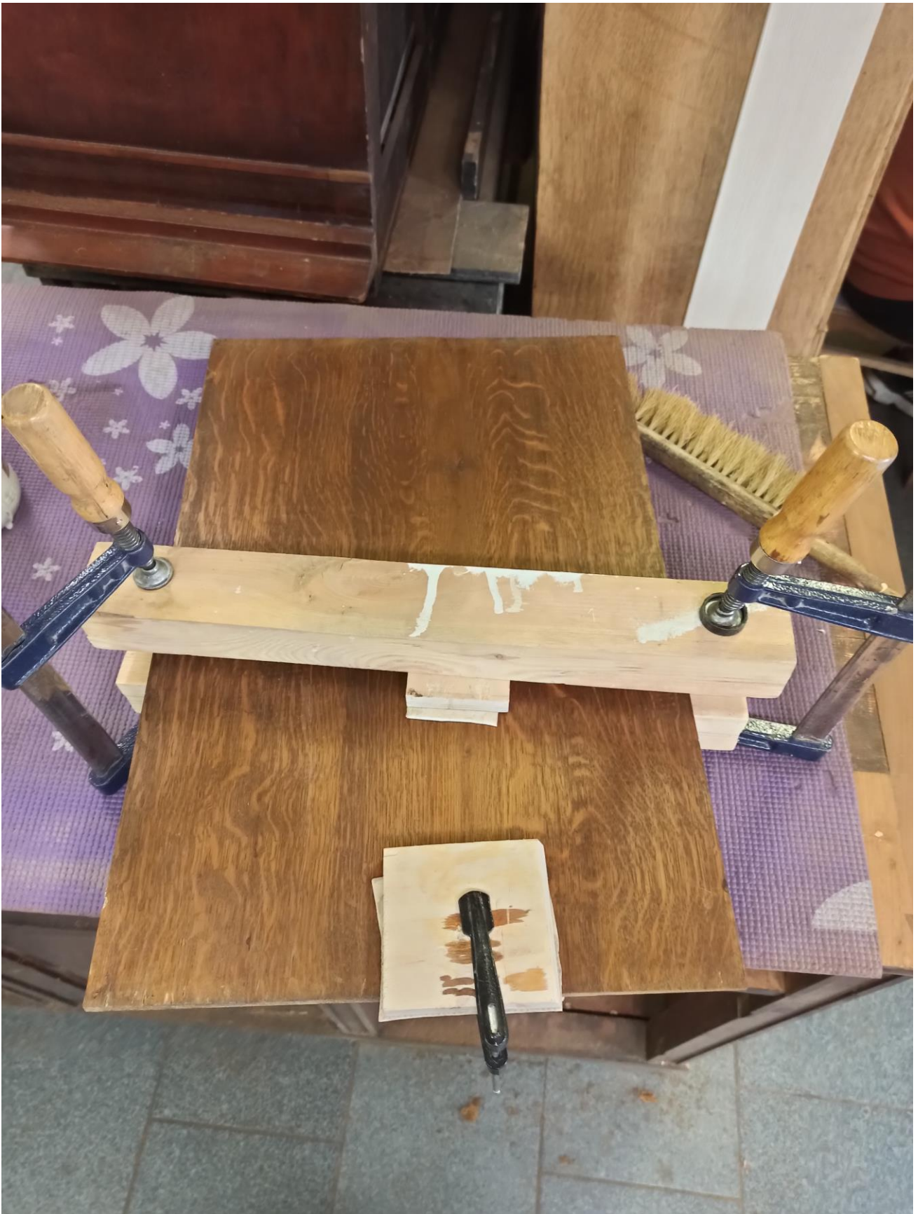
Фото №62: Процесс склейки разрывов массива филенок дверец.
