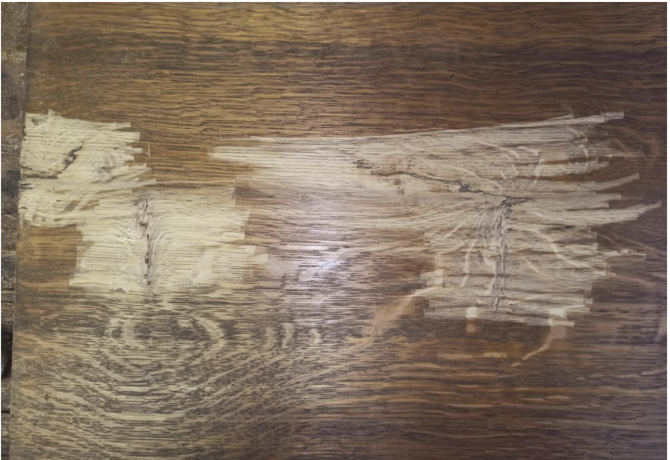
Фото №63: Процесс механической расчистки филенок дверей.
