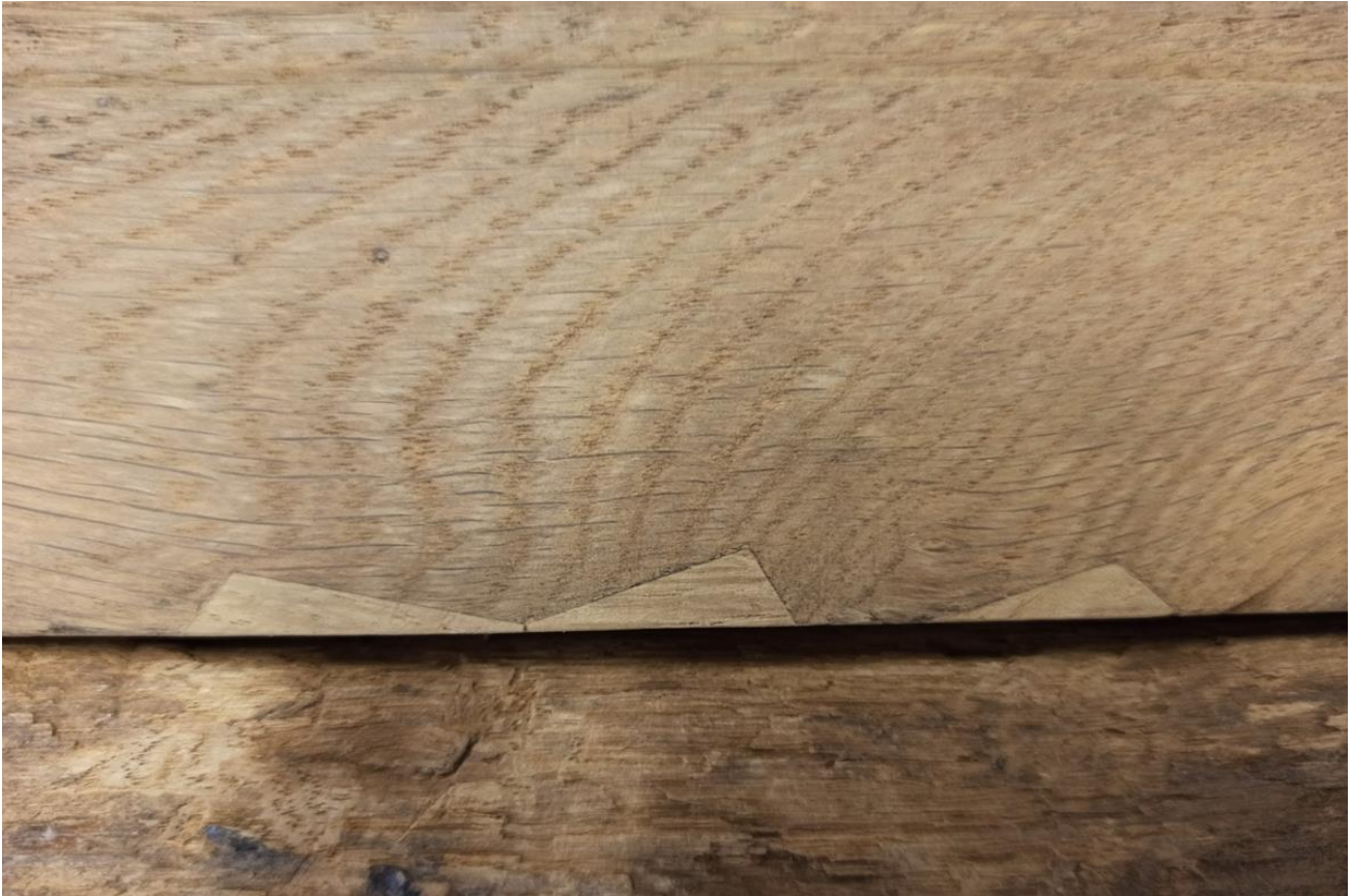
Фото №45: Изготовление вставок в места утрат массива плинта левой боковой стенки.
