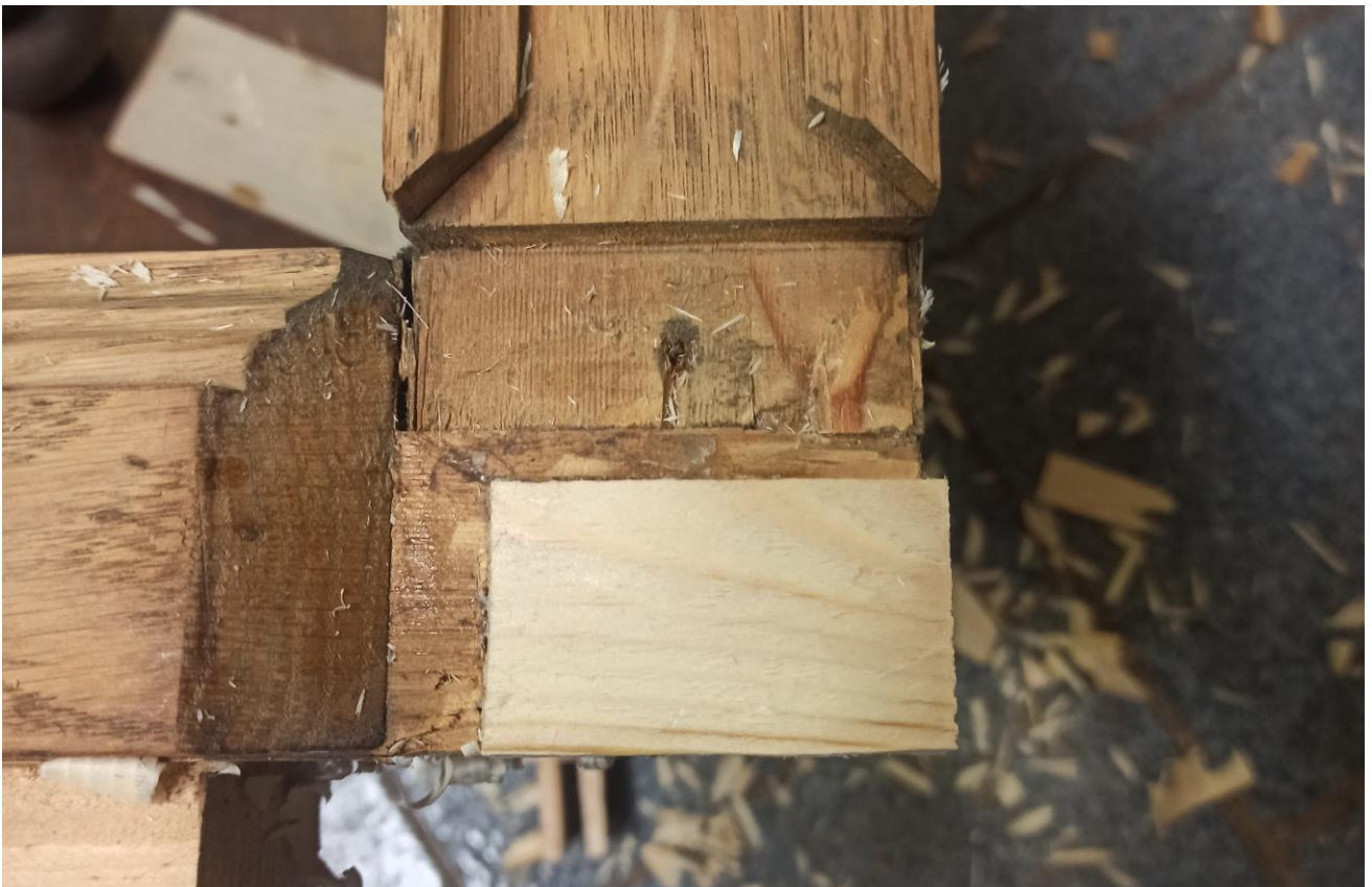
Фото №35: Изготовление вставки в место утраты массива шипового соединения правого переднего угла.
