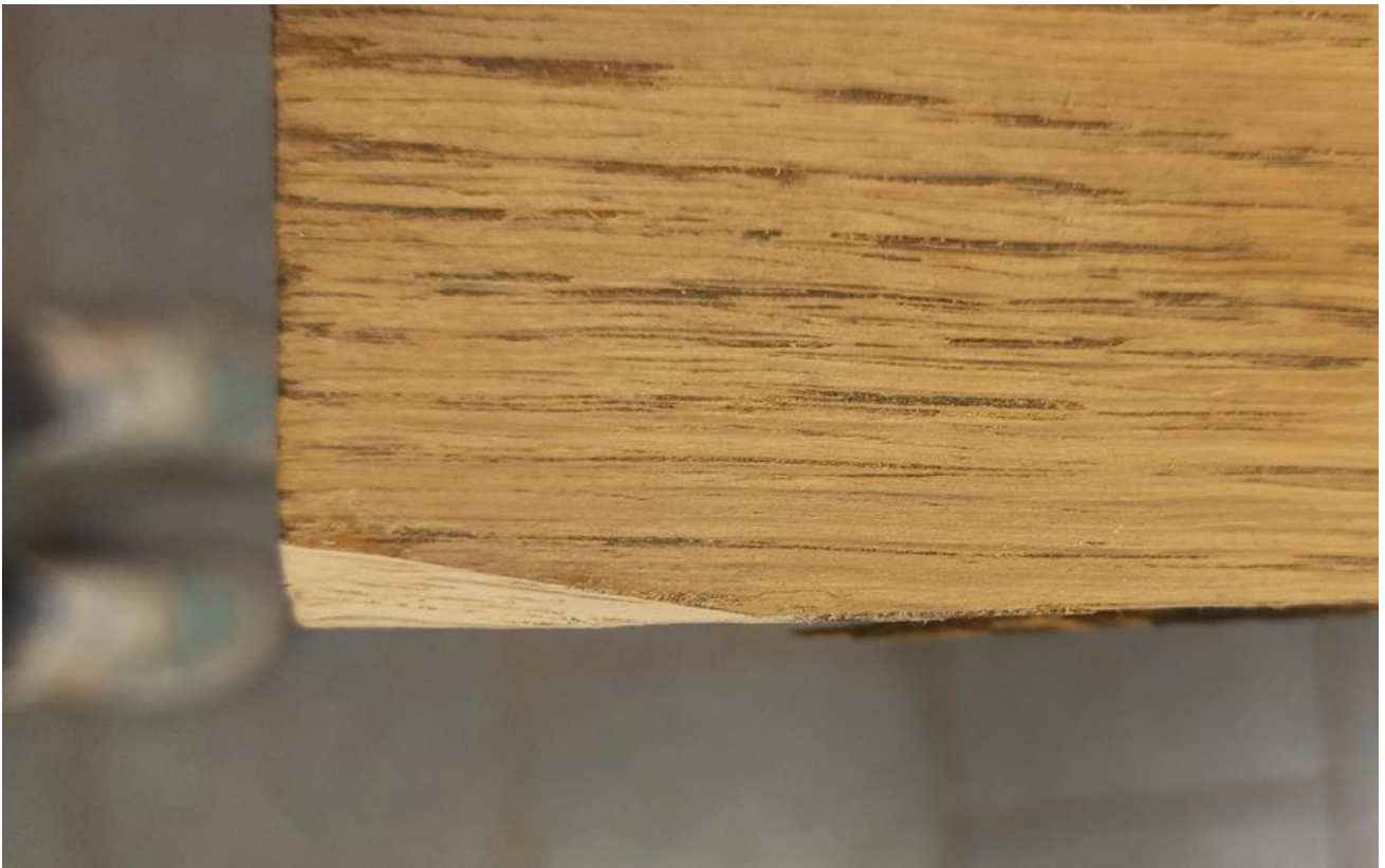
Фото №52: Изготовление вставки в место утраты фанеровки угла левой дверцы.
