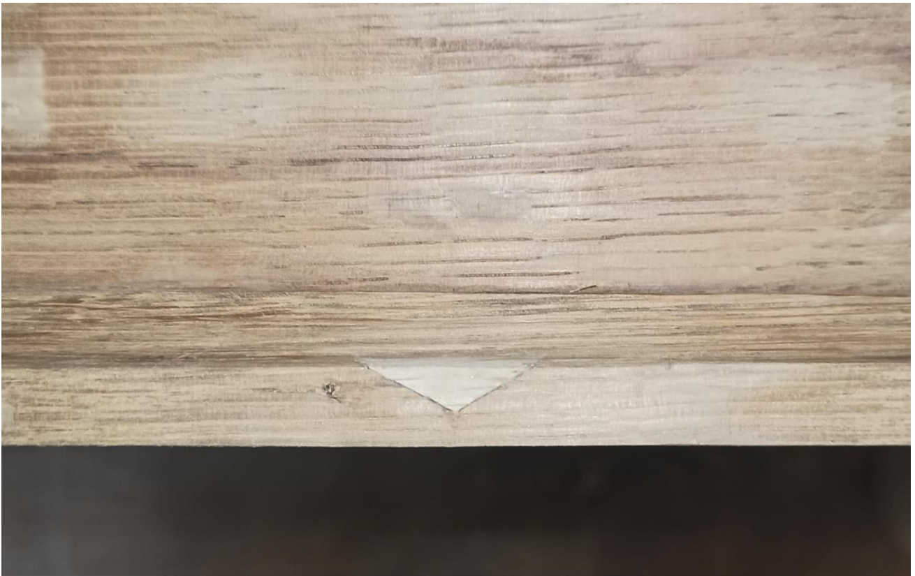
Фото №30: Изготовление вставки в место утраты массива пластика.
