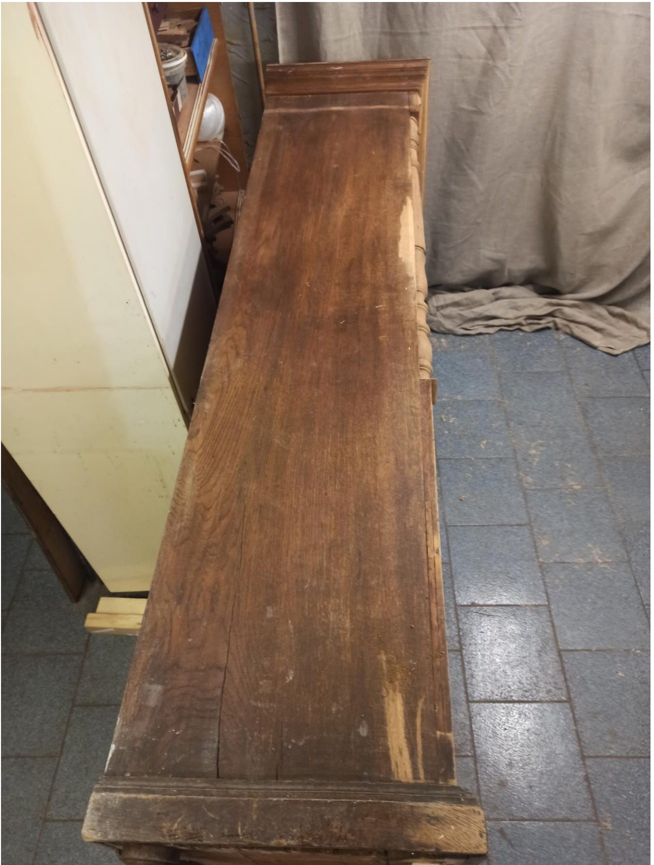
Фото №44: Процесс расчистки от старого отделочного слоя левой боковой стенки.
