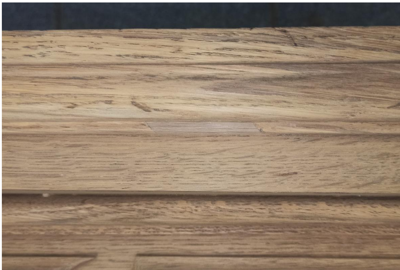
Фото №27: Изготовление и установка вставки в центральной части карниза передней стороны шкафа.
