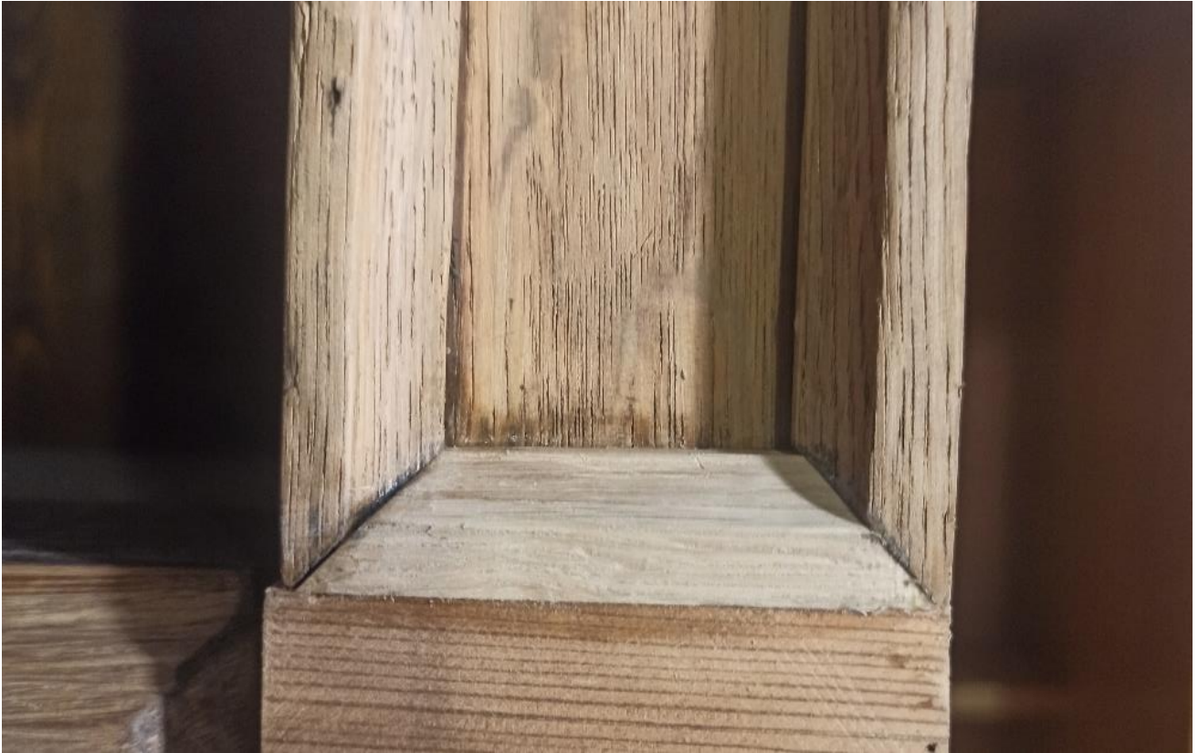
Фото №34: Установка утраченного элемента нижней части пластика фасадной стороны.
