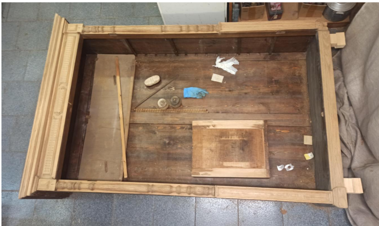
Фото №26: Процесс расчистки от старого отделочного слоя фасадной стороны.
