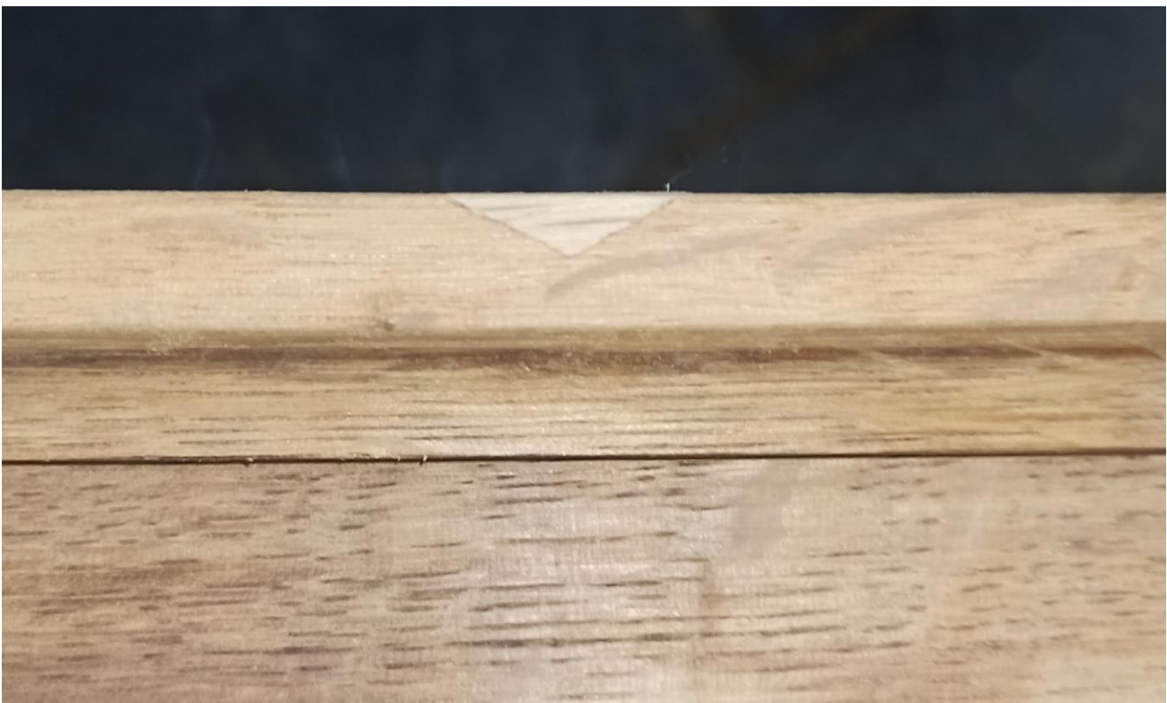
Фото №29: Изготовление и установка вставки на углу левой стенки и пластика фасадной стороны.
