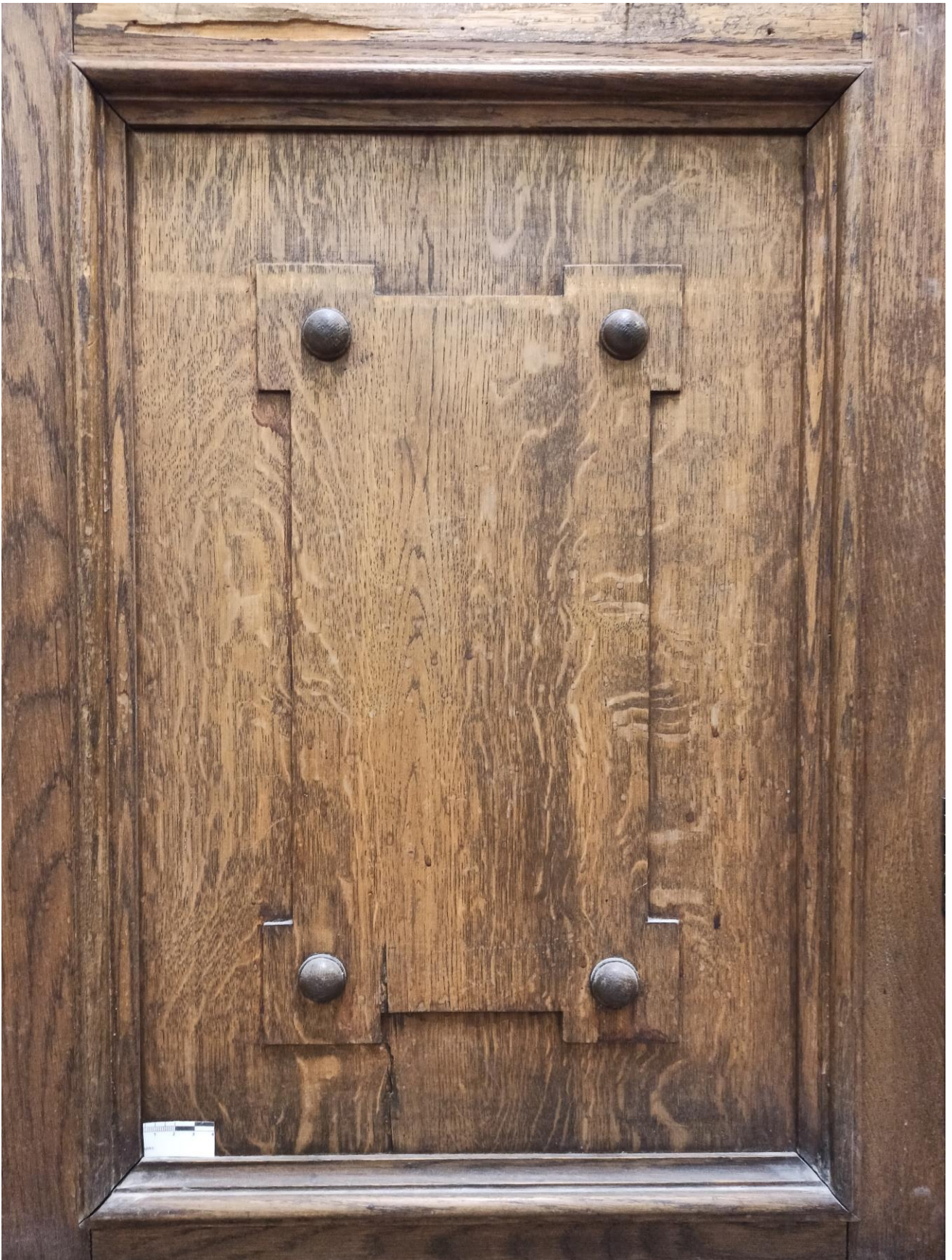
Фото №13: Трещины и расслоения массива филенки правой дверцы.
