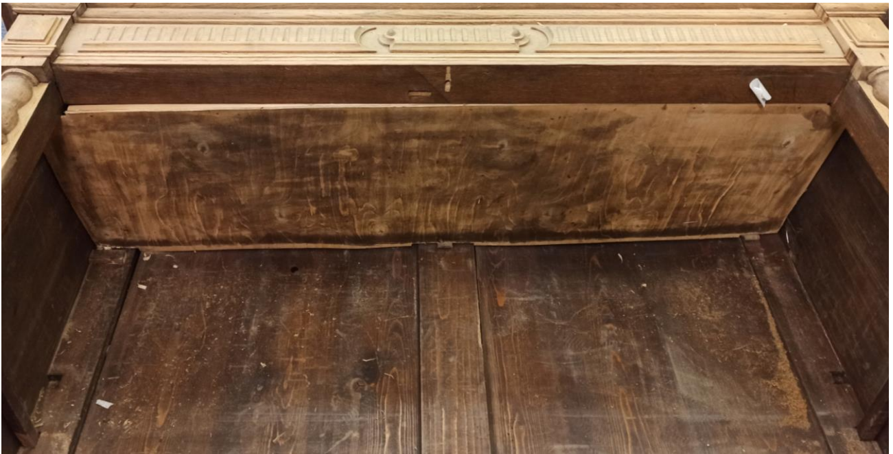
Фото №24: Следы предыдущих ремонтных работ в верхней части шкафа (ДВП).
