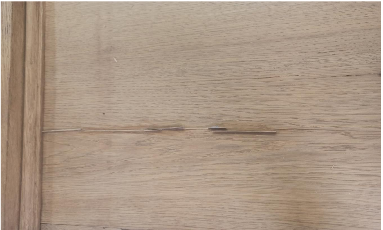
Фото №40: Зарезивание трещин правой боковой стенки.
