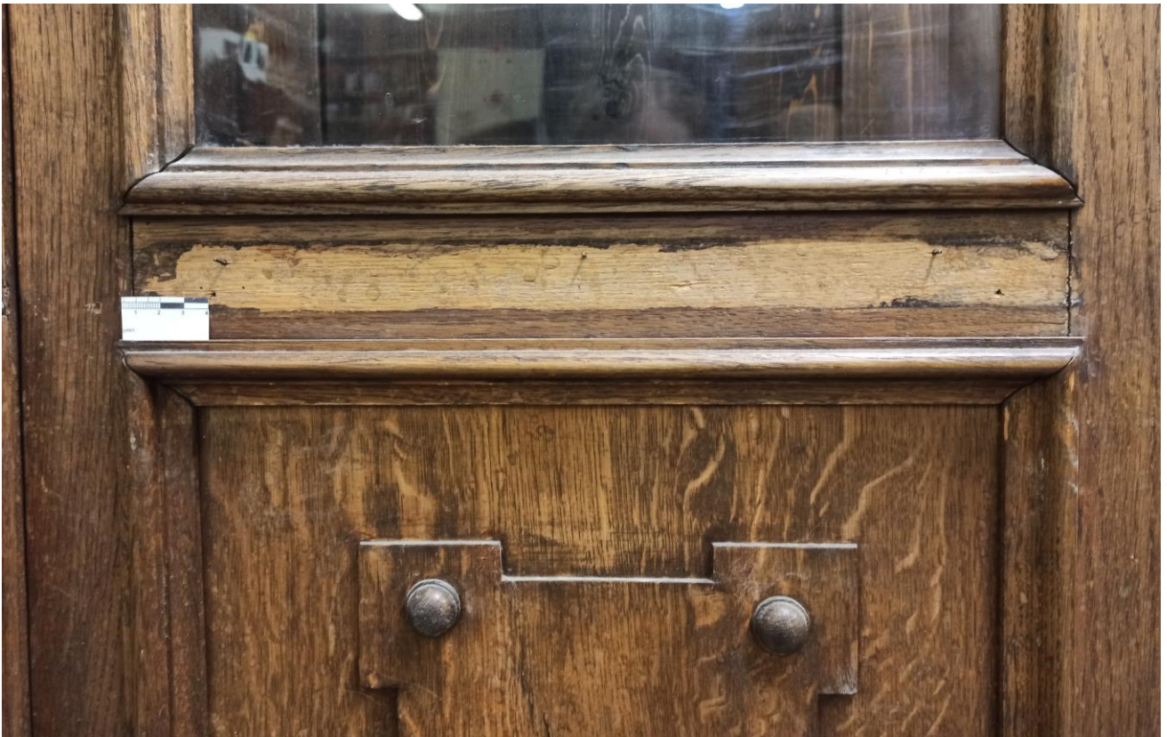
Фото №10: Утрата декоративного элемента средника левой дверцы шкафа.
