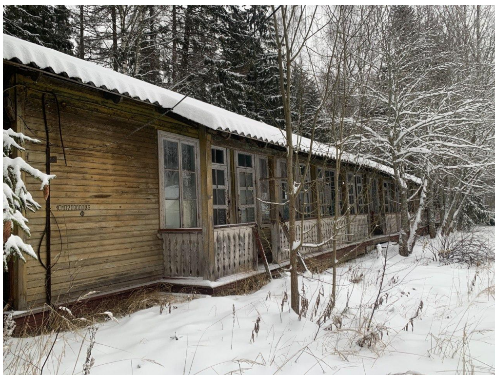
Строения на территории учебно-оздоровительного центра
