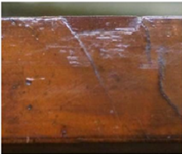
Фото№ 45,46: Вставки на нижней кромке.
