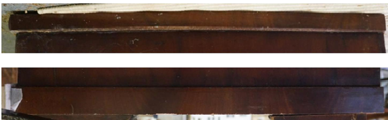
Фото№ 25,26: Изготовление и установка утраченных верхнего и нижнего плинта с правой стороны.
