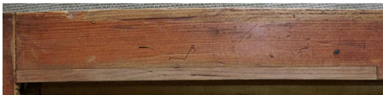
Фото№ 61: Вставка на раме с обратной стороны на дверце Н3
