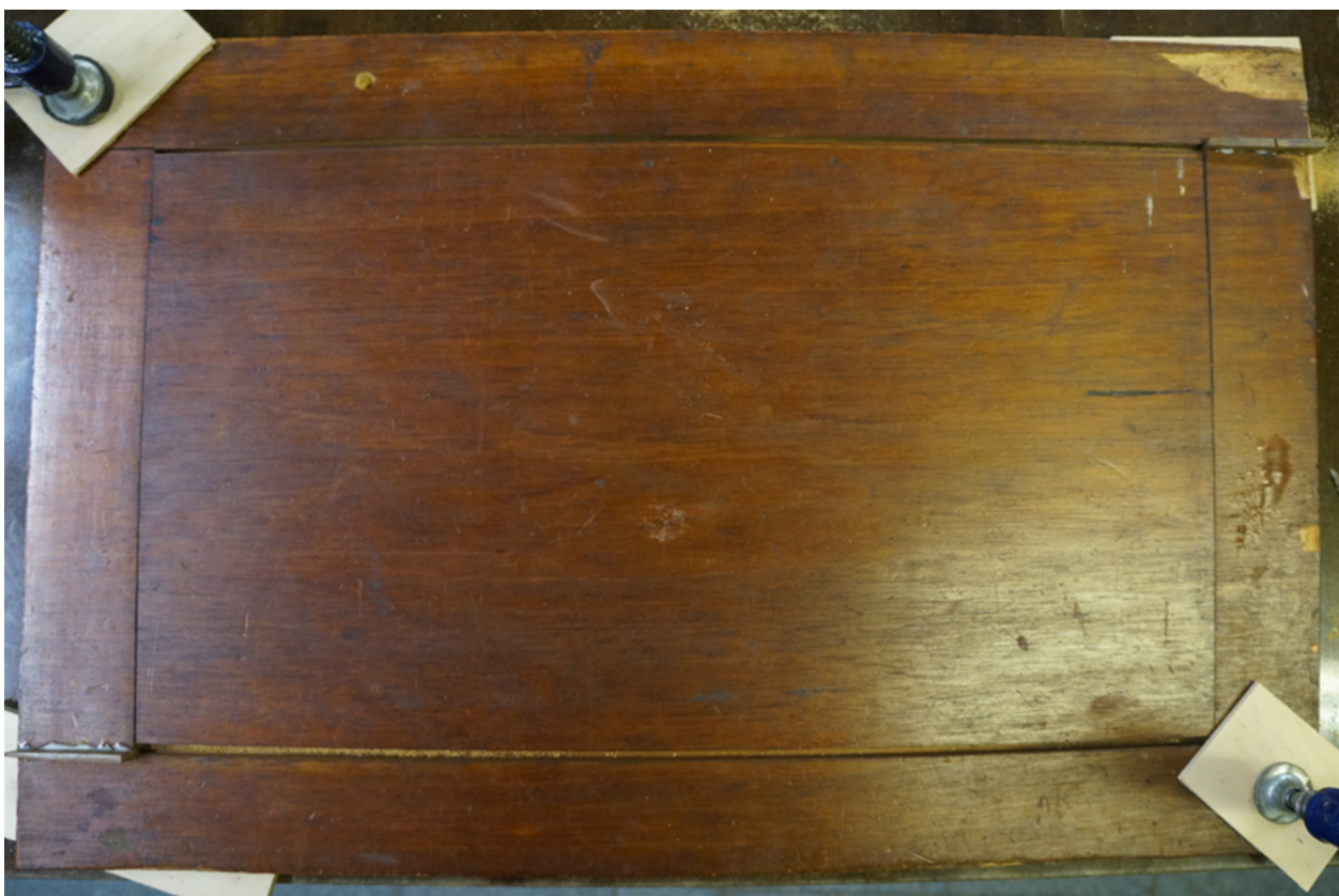
Фото№ 48: Ликвидация деформаций дверец буфета.
