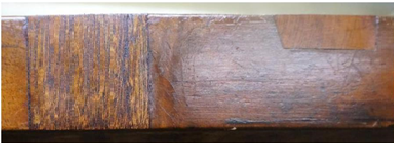
Фото№ 47: Вставка на нижней кромке.
