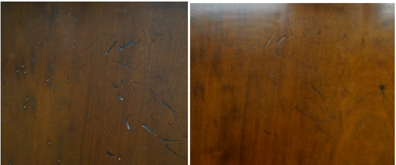
Фото№ 81,82: Устранение мелких дефектов на поверхностях шкафа (до/после).
