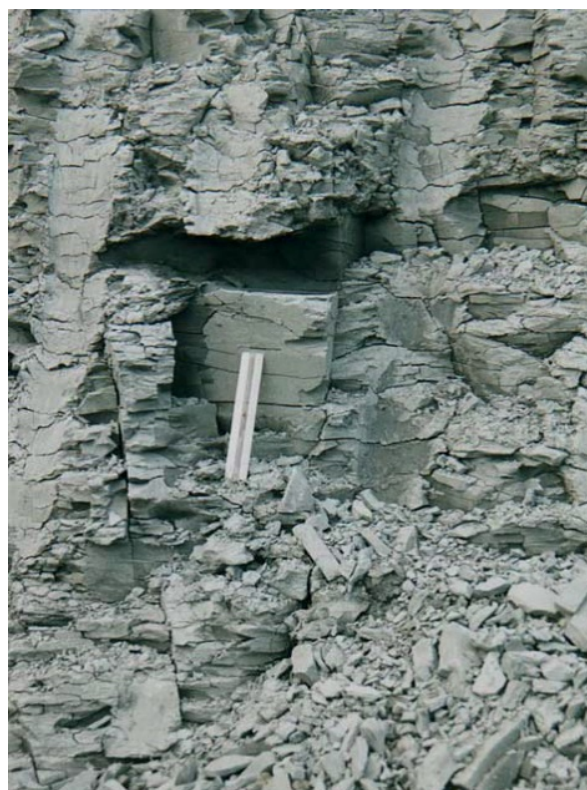
Рис. 10. Трещины в кембрийской глине, карьер Красный Бор (Arnould, 2006).
