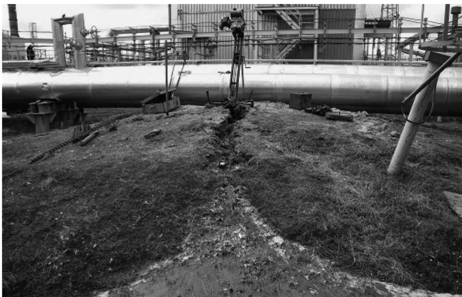
Рисунок 8. Бугор пучения на площадке АВО, вскрытый разгрузочной скважиной (Арабский и др., 2017)
