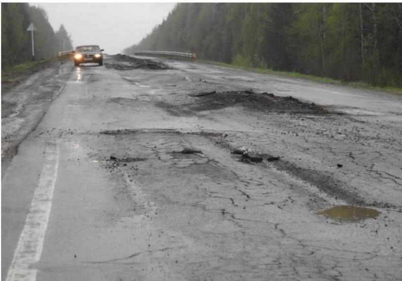
Рисунок 5. Разрушение дороги в результате морозного пучения (Гулин и др., 2022).
