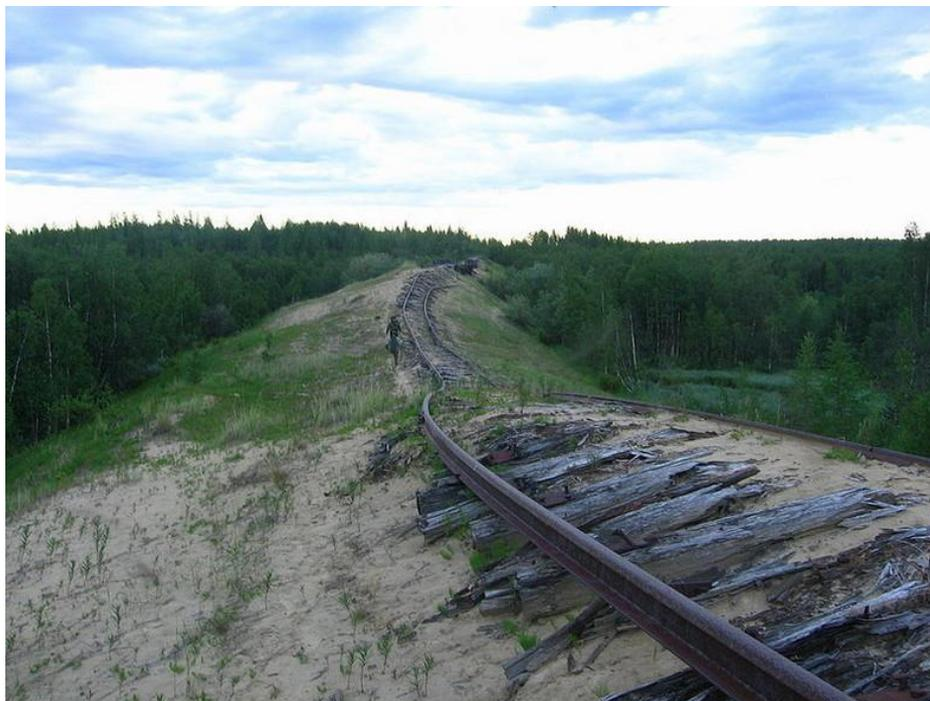
Рисунок 3. Состояние недостроенной железной дороги Чум — Салехард — Игарка на участке с буграми пучения (Заброшенная железная...[Электронный ресурс], дата обращения: 29.04.2022).
