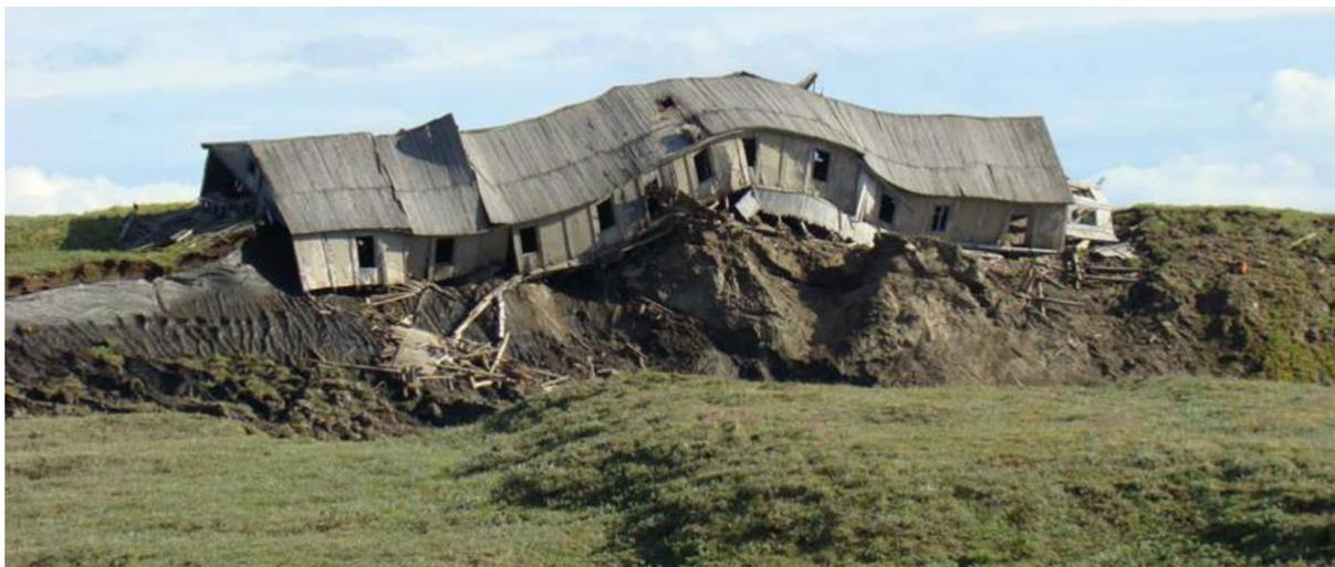
Рисунок 7. Разрушение здания при пучении грунта (Гулин и др., 2022).
