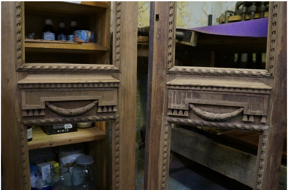
Фото №68. Дверцы в процессе расчистки механическим способом.
