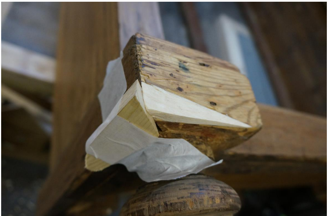
Фото №57. Правый плинт после расчистки механическим способом. Массив берёзы.
