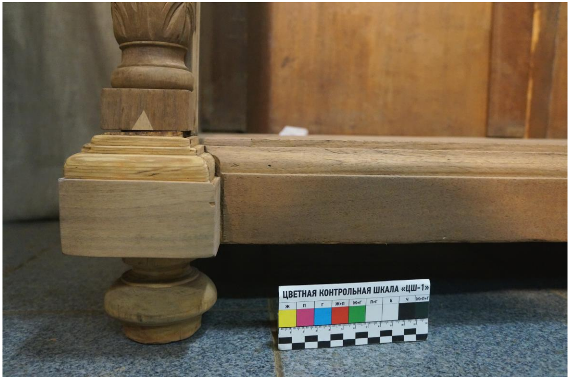
Фото №123. Левая раскреповка цоколя в процессе реставрации.
