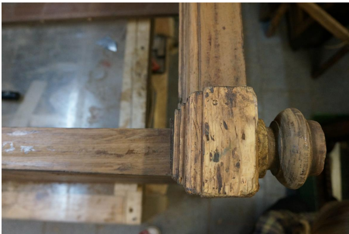
Фото №55. Левая раскреповка плинта после механической расчистки. Массив сосны.
