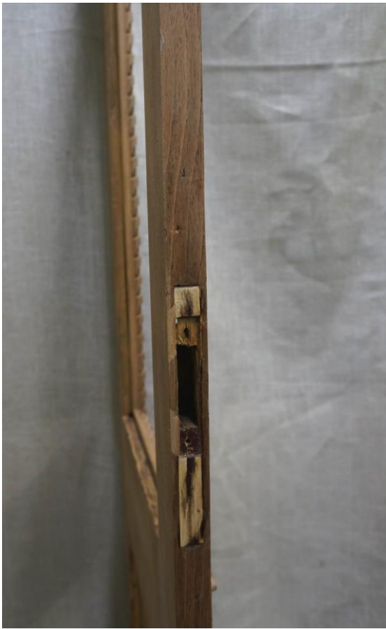
Фото №97. Правая дверца в процессе реставрации, лицевая ст. Область замкового гнезда.
