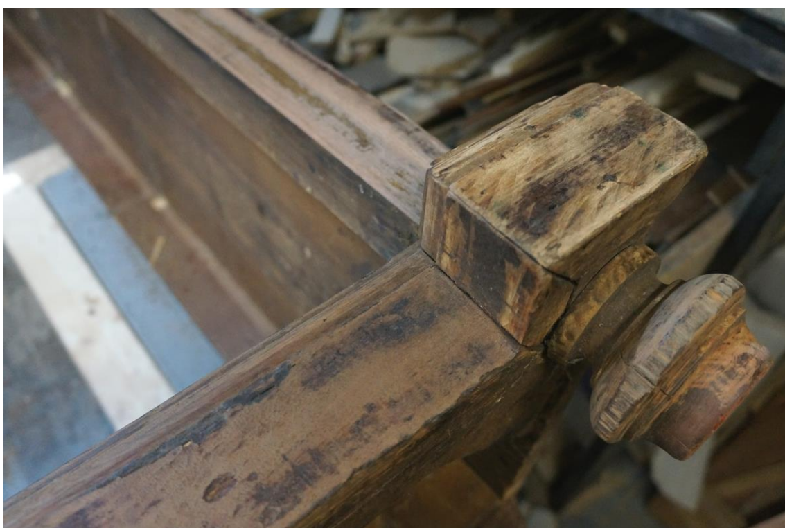
Фото №56. Правая раскреповка плинта после механической расчистки. Массив берёзы.
