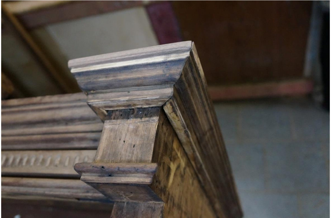
Фото №59. Правая раскреповка карниза, массив берёзы. Восполнение утрат из массива ореха.
