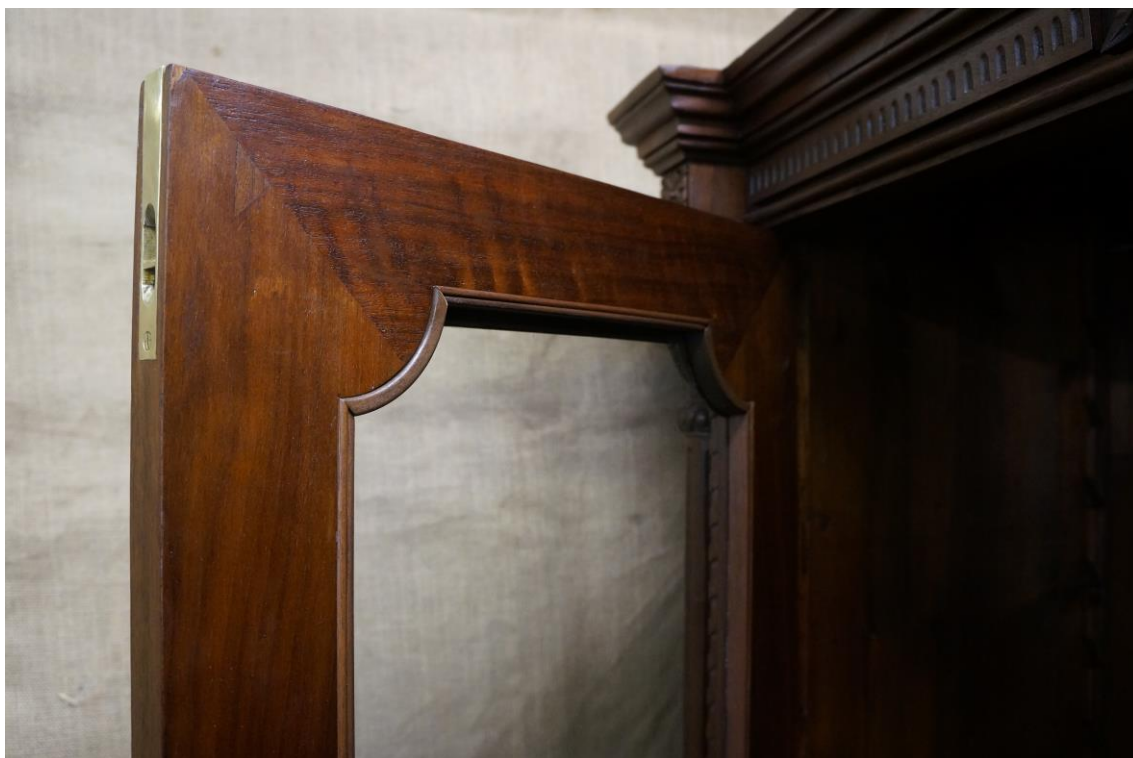
Фото №152. Установленные на дверцы штапики и фурнитура.
