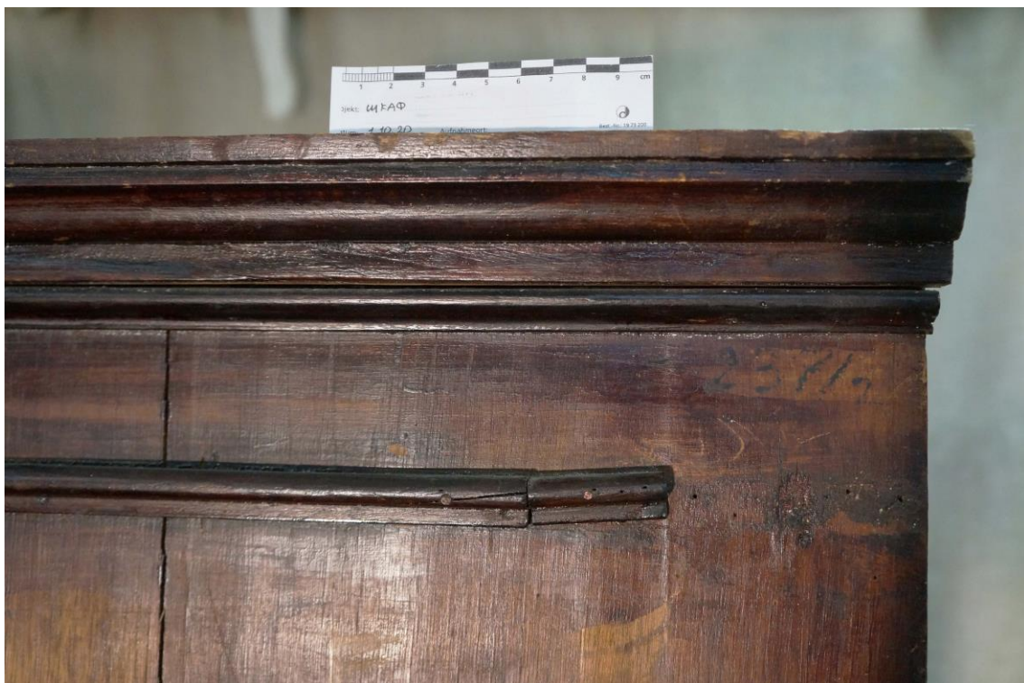
Фото №23. Правая стенка в области карниза. Трещина, утрата части профиля фриза.
