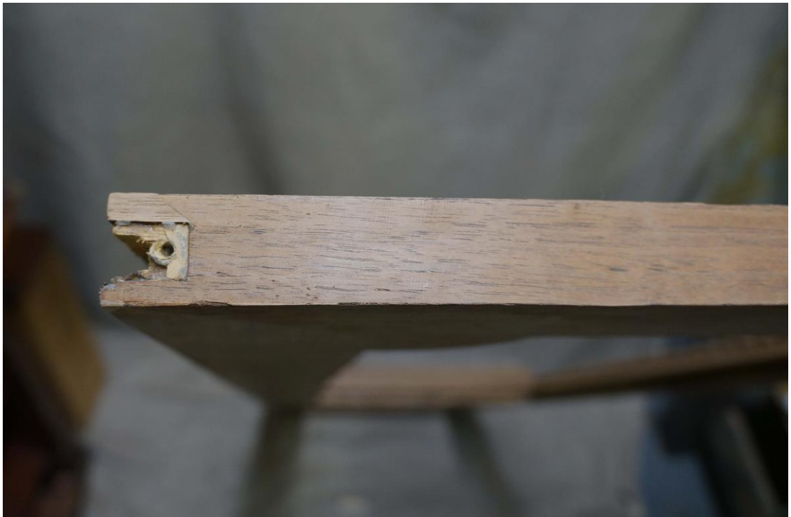
Фото №78. Левая дверца в процессе реставрации. Верхняя часть рамы, область верхнего гнезда стопора.
