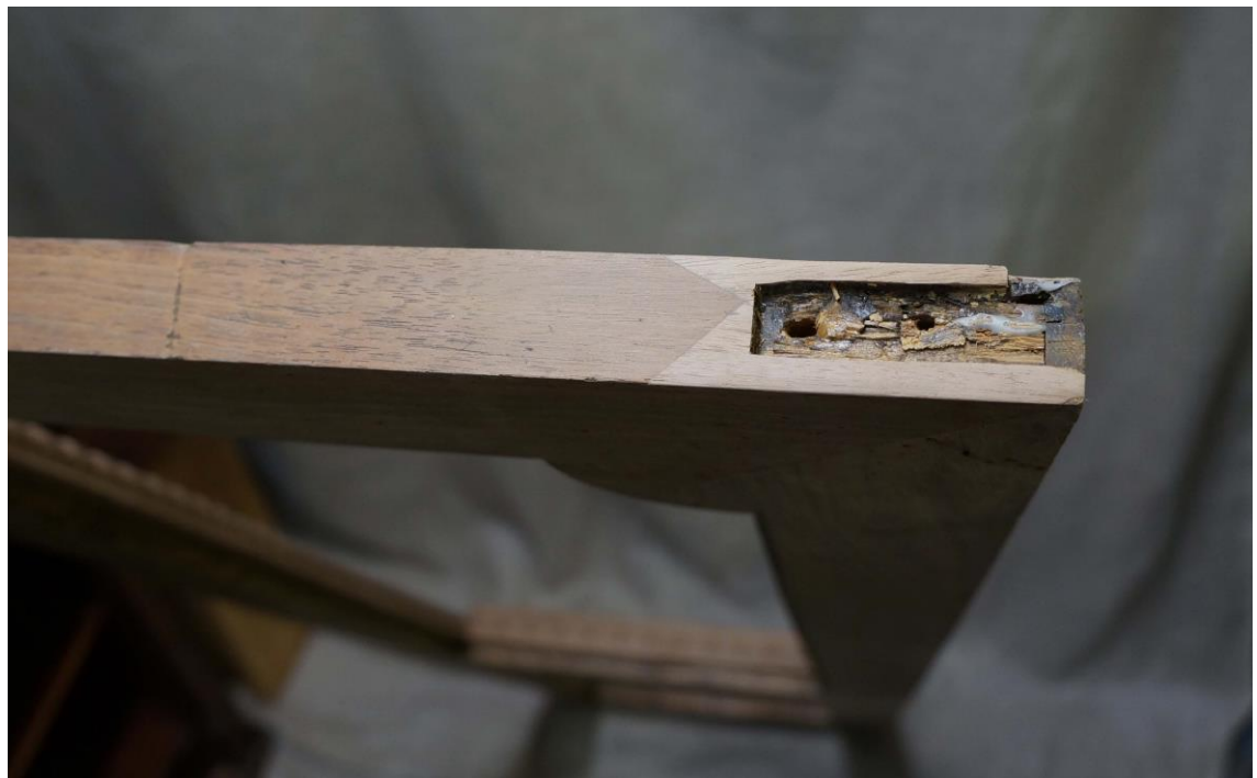
Фото №79. Левая дверца в процессе реставрации. Верхняя часть рамы, область верхнего гнезда пятниковой петли.
