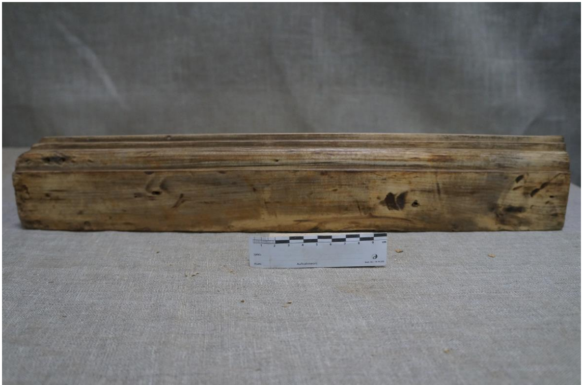
Фото №57. Правый плинт после расчистки механическим способом. Массив берёзы.
