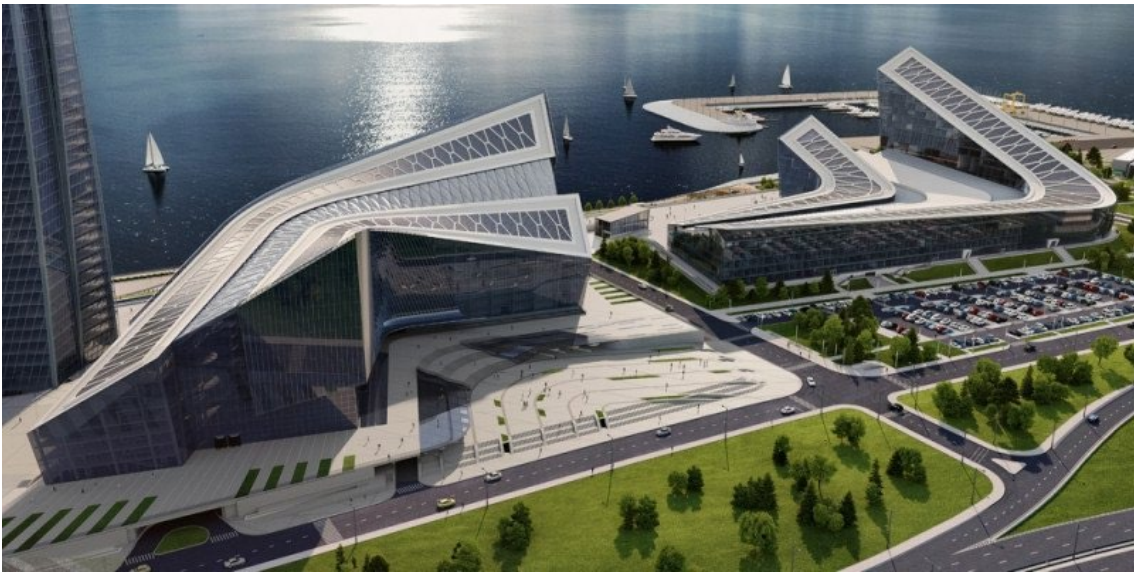
Рисунок 32. Объекты комплекса Лахта–центра
