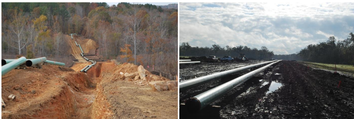
Рис. 23. Земляные выемки, при строительстве трубопроводов ( https://troyconstruction.com/ )
