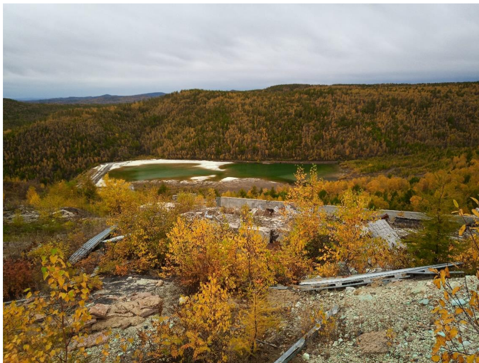
Рисунок 7. Остатки Этыкинской обогатительной фабрики, затопленное хвотсохранилище. Фото Баданиной Е.В., 2021г.
