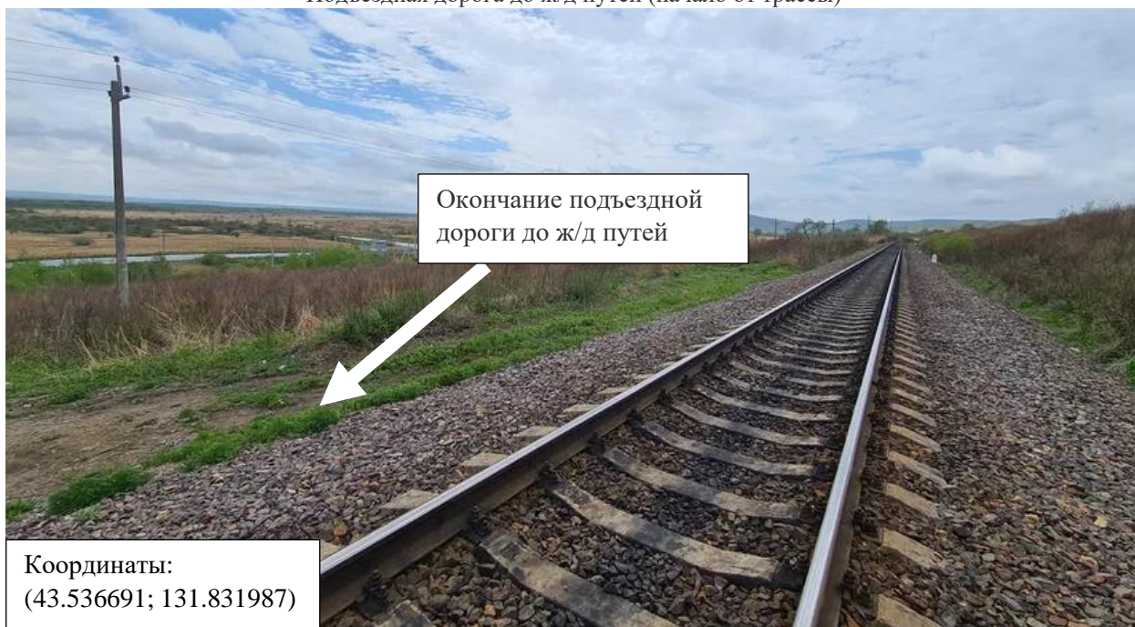
Подъездная дорога до ж/д путей (окончание)
