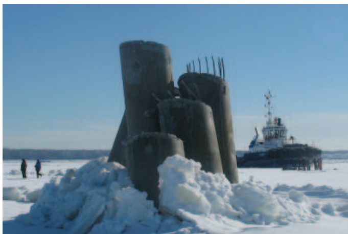
Рис. 3. Авария опор створного знака, Финский залив, 2013 г. Фото С. М. Ковалева.
