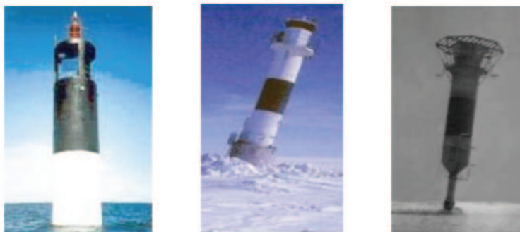
Рис. 2. Аварии маяков Ботнического залива. Слева направо: маяк Тайнио, маяк Бьернклакен, маяк Кеми-1.
