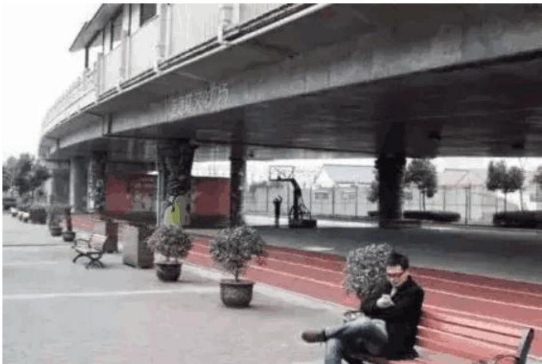
Рис.1-12 Эстакада бэйхуань, район Тяньхэ, Гуанчжоу.
