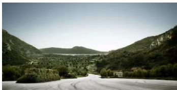
Рис. 1.12 Вход на полигон ТБО
