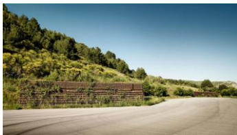
Рис. 1.11 Мусорная ландшафтная стена- Вход на полигон ТБО
