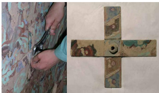
Рис. 42 Анкер и крепёж - крестообразная стальная пластина.
