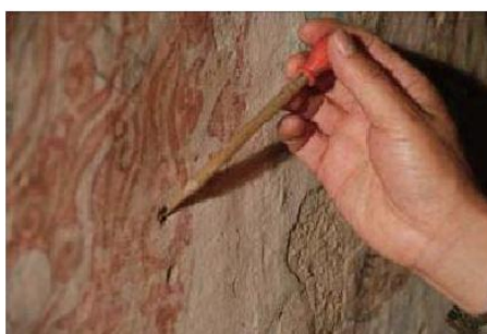
Рис. 68 Восполнение утрат глиняной штукатурки.
