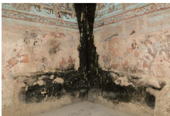
Рис. 31 Поверхность настенных росписей покрыта копотью от дыма.
