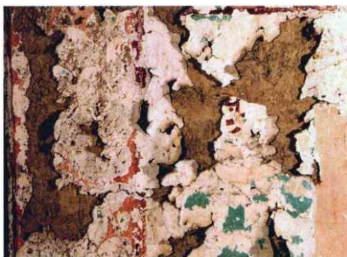
Рис. 23 Шелушение красочного слоя в пещере Могао № 85.
