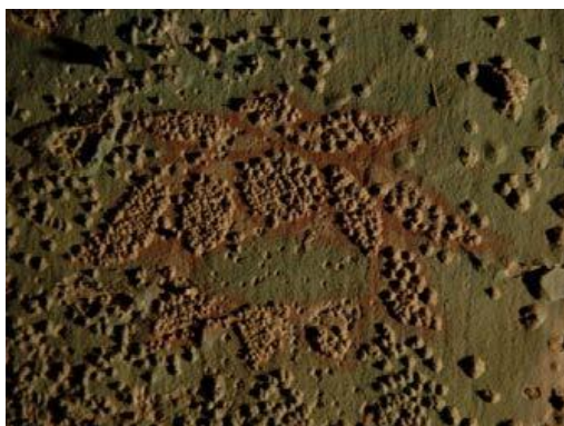
Рис. 27 Повреждение пещеры 85 в гротах Могао
