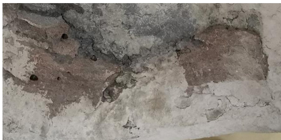
Илл.20. Фрагмент плиты после применения микробластера.
