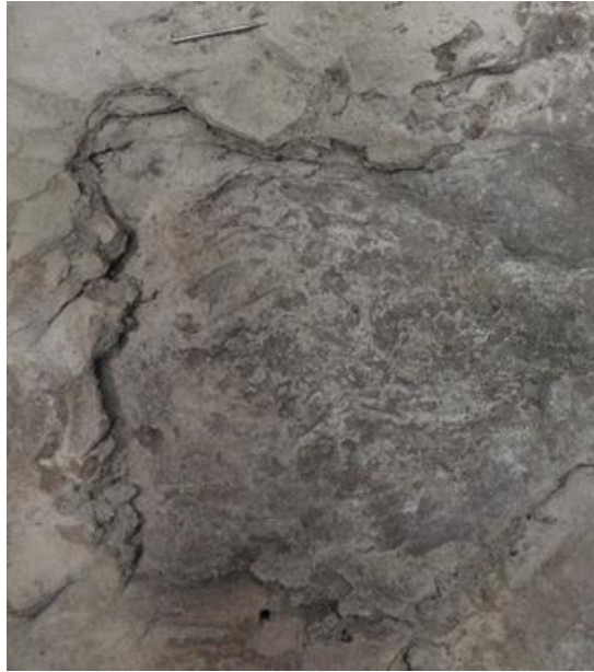
Илл.18 Фрагмент плиты после применения компресса из перекиси водорода и аммиака.
