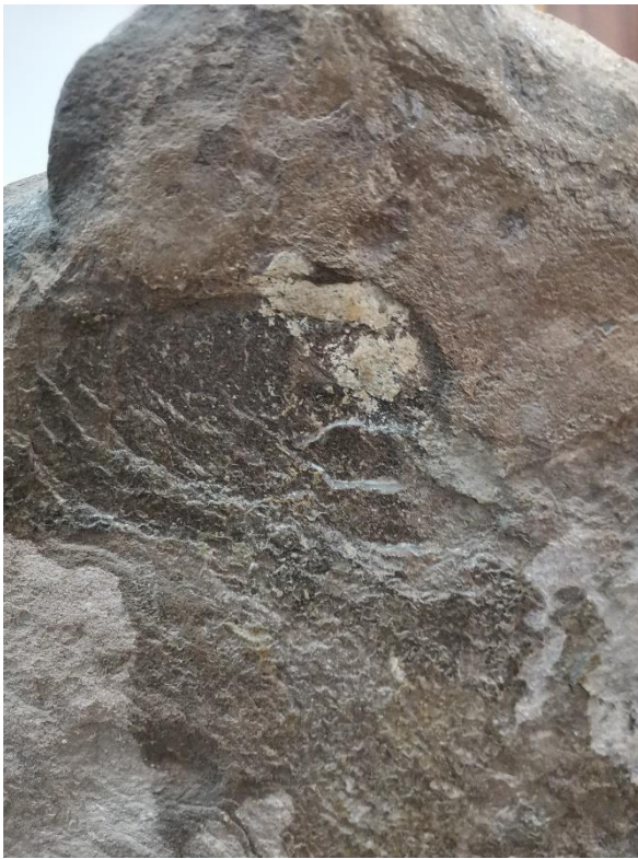
Илл.22. Натёк, образовавшийся под отслаивающимся фрагментом камня.
