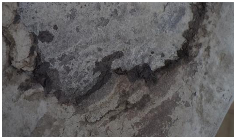
Илл.19. Фрагмент плиты до применения микробластера.
