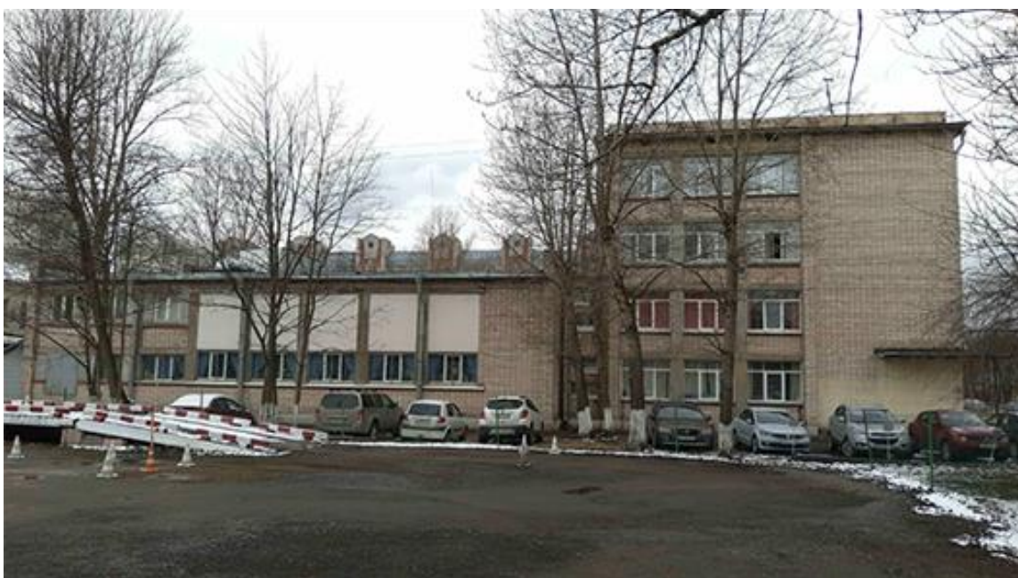
Рис. 1.9 Фотофиксация здания Академии машиностроения имени Ж.Я. Котина. Западный фасад.
