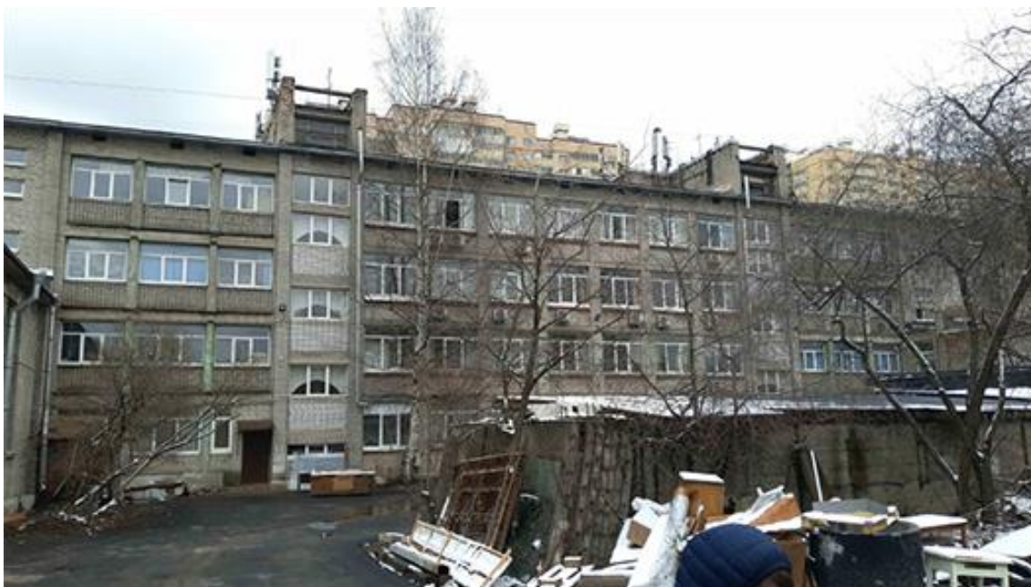
Рис. 1.8 Фотофиксация здания Академии машиностроения имени Ж.Я. Котина. Южный фасад.
