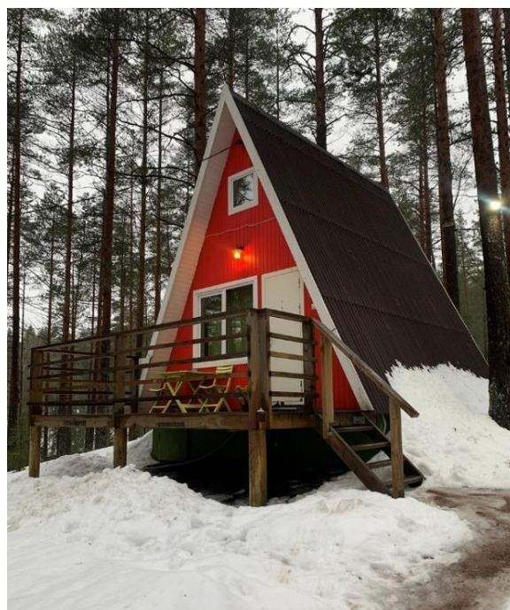
Коттеджи, построенные на свайных конструкциях
