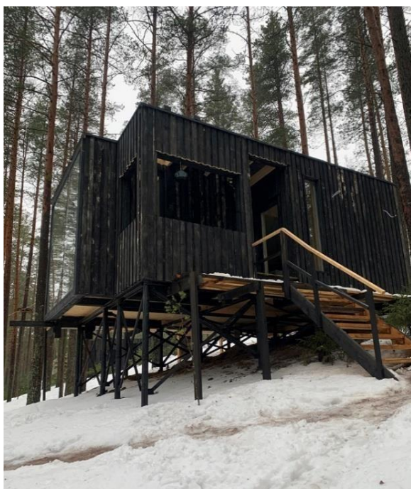
Коттеджи, построенные на свайных конструкциях
