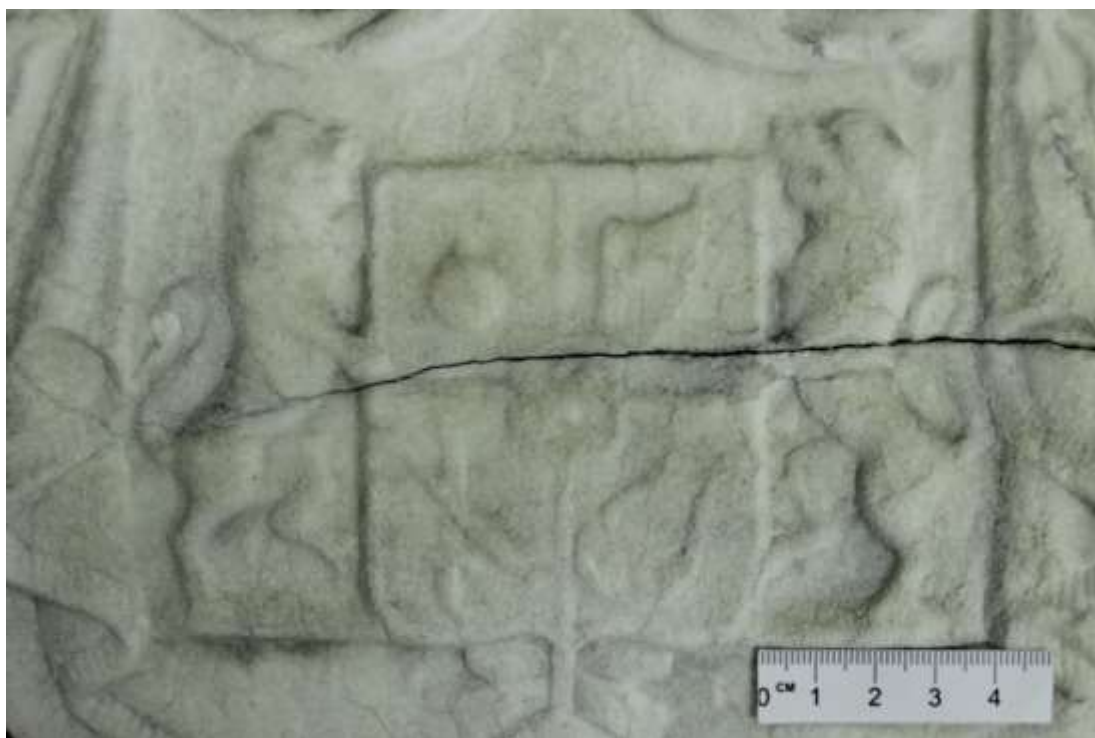
Фото 6. То же. В процессе реставрации.
