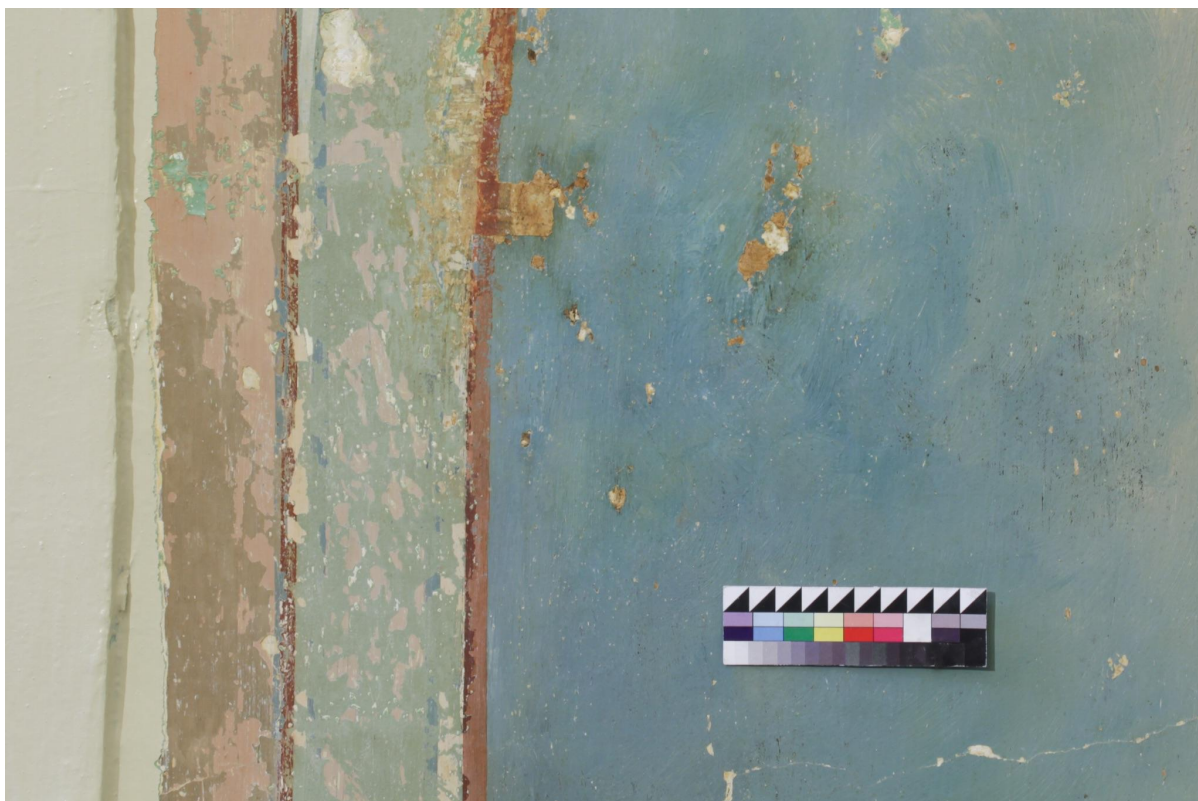
Фрагмент в процессе реставрации. В процессе удаления поздних малярных поновлений. Прямое освещение. После удаления шпаклевки оставлен контрольный участок поновления
