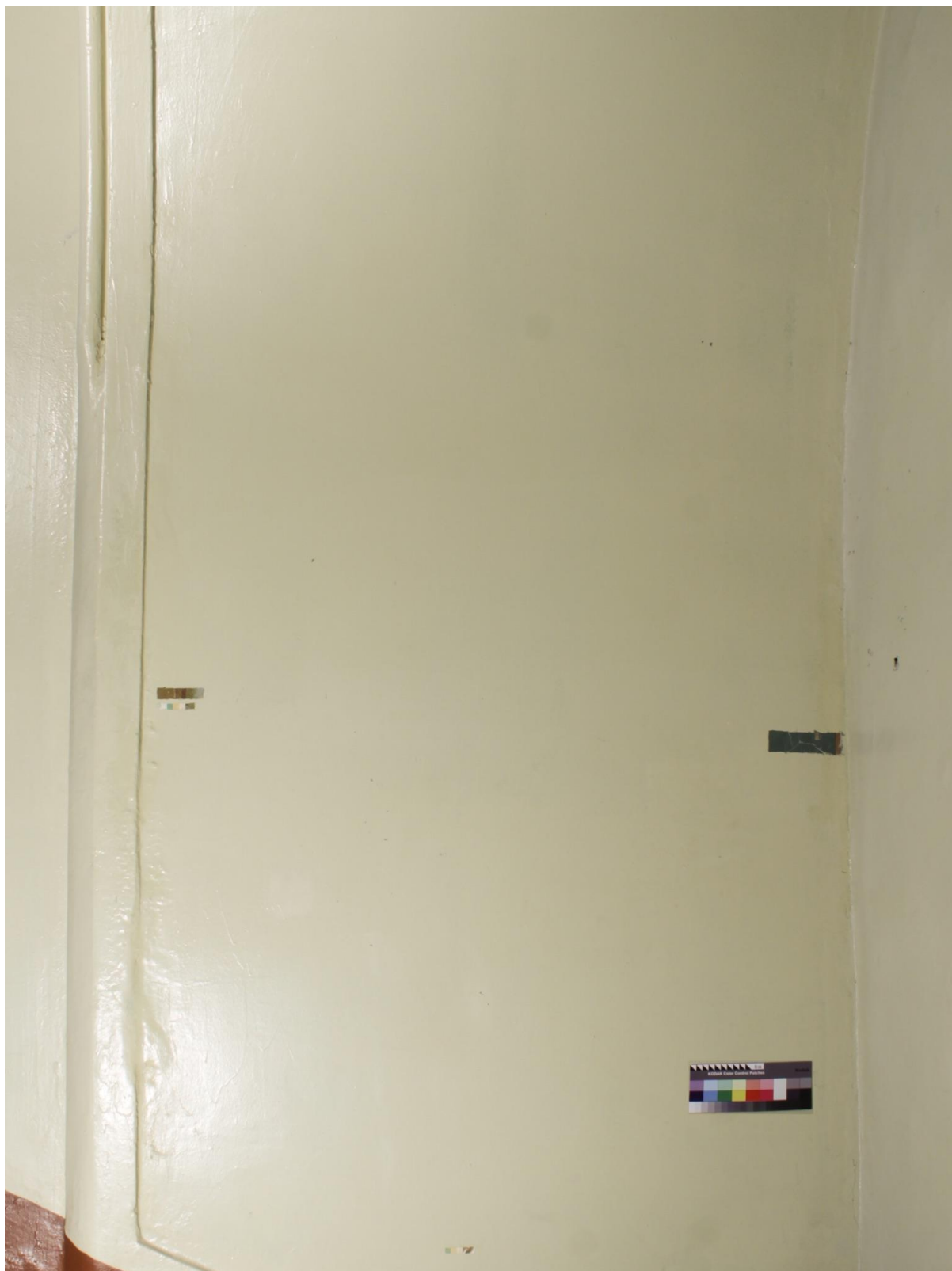
Правая стена лестничного пролета до начала работ. Прямое освещение
