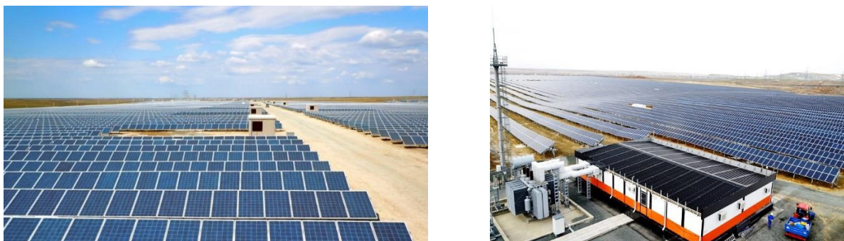
Рис. 14. Орская солнечная электростанция имени А. А. Влазнева
