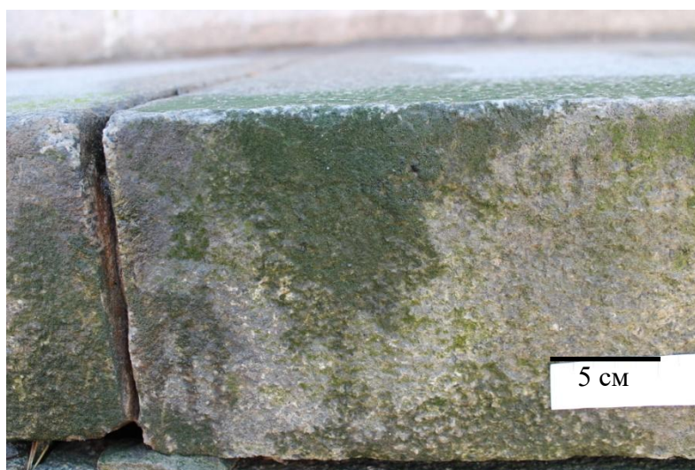
Рис. 18. Зеленая биопленка на поверхности гранита. Фото с набережной Обводного канала.
