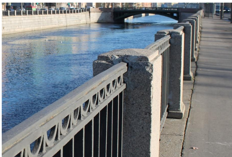
Рис. 15. Сколы и их цементация на гранитном столбике. Фото с набережной Обводного канала.
