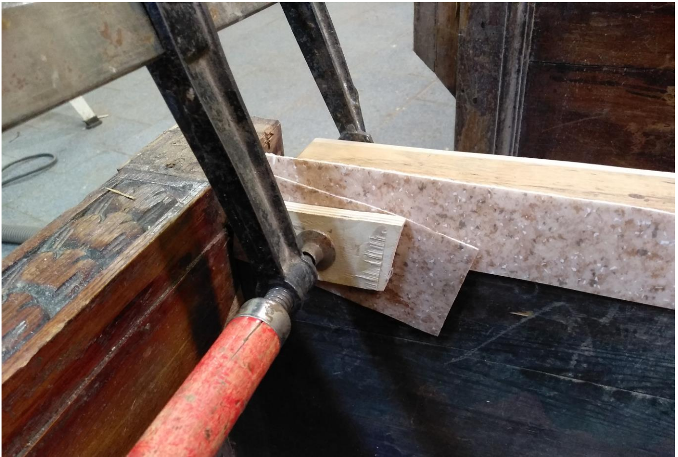
Фото №31. Изготовление вставки в место утраты древесины в основании
