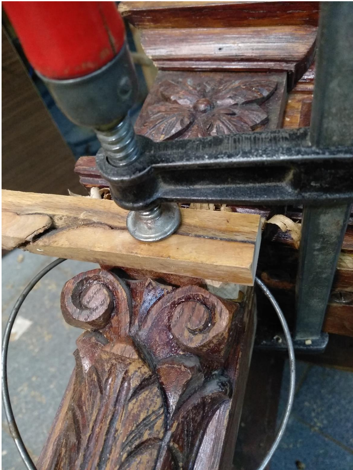
Фото №30. Изготовление вставки в место скола резьбы на капители
