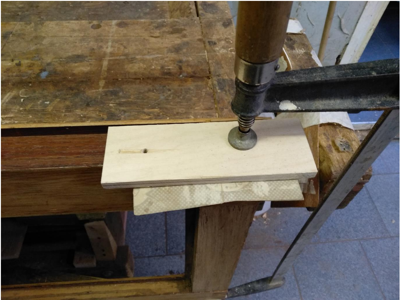
Фото №34. Изготовление вставки в место разрыва древесины на кромке двери
