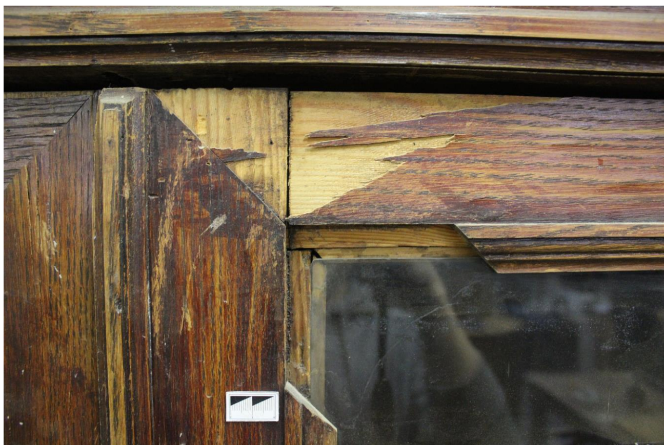
Фото №6. Утрата фанеровки на лицевой стороне двери
