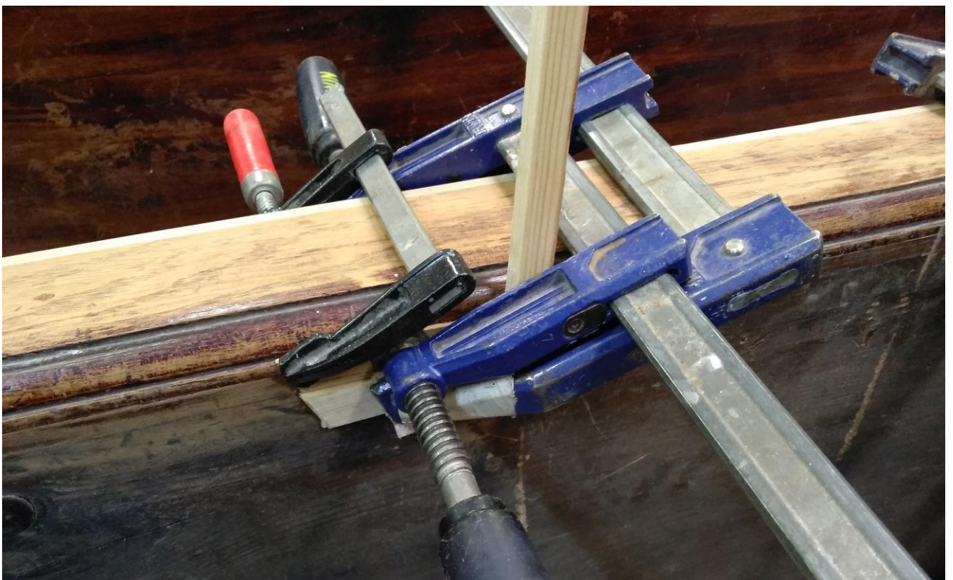
Фото №32. Изготовление вставки в место утраты древесины в основании
