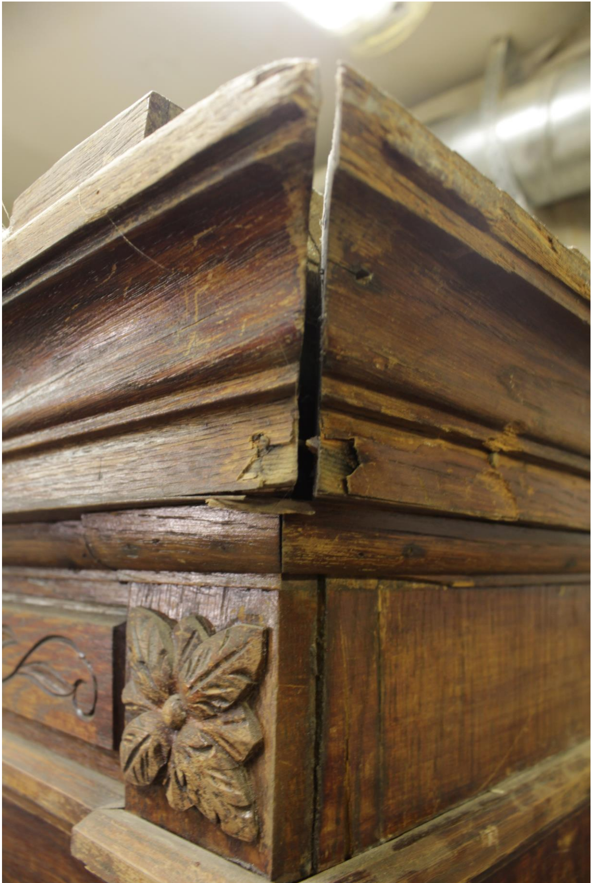
Фото №4. Разрывы древесины на углах
